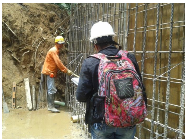
SUPERVISION DE OBRAS DE CONTENCION Fuente: Elaboración propia
