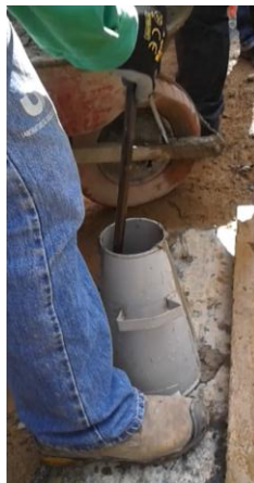
Figura 10. Compactación Del Concreto.
