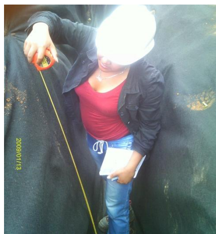
SUPERVICION DE OBRAS DE DRENAJE. Fuente: Elaboración propia
