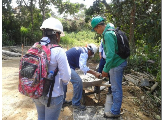
SUPERVICION PRUEBA DE ASENTAMIENTO Fuente: Elaboración propia
