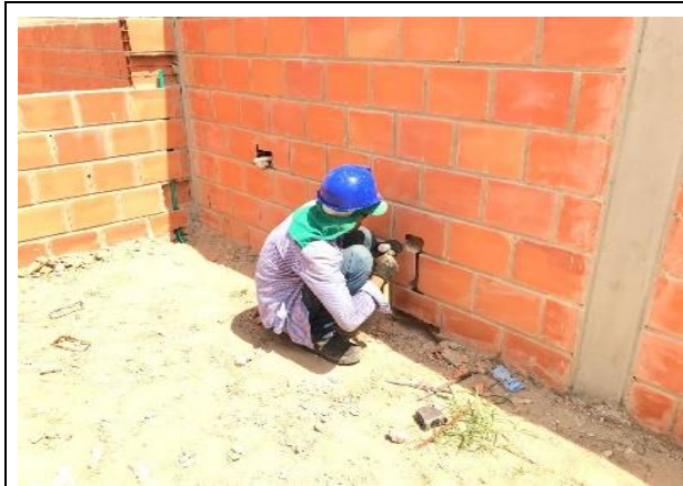
Corte de muro para instalación de tubería eléctrica
