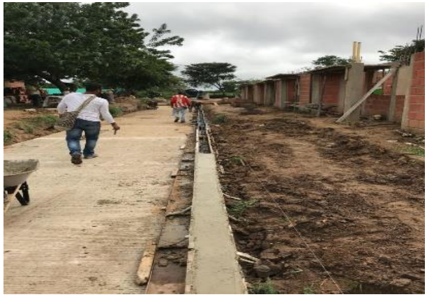
Fundición de bordillos
