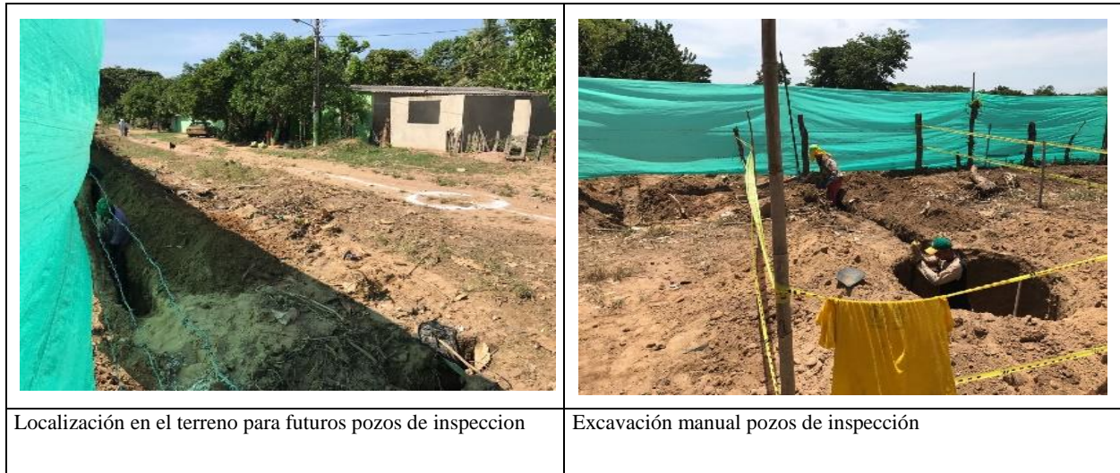
Ilustración 26 Registro fotográfico sistema de alcantarillado
