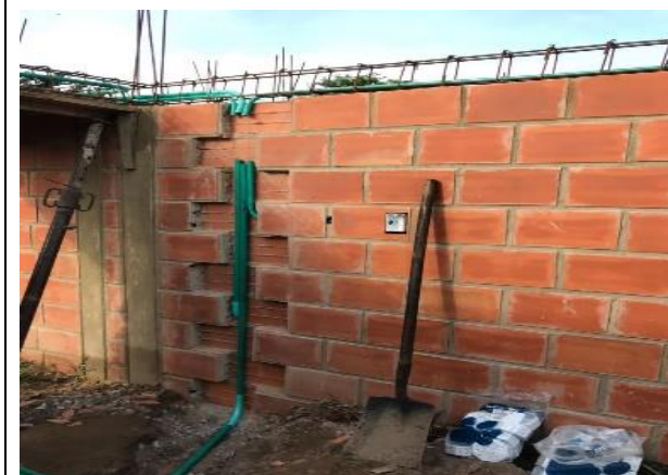
Instalación de red eléctrica
