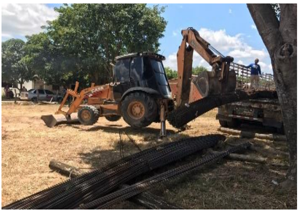
Ilustración 32 Recepción de acero
