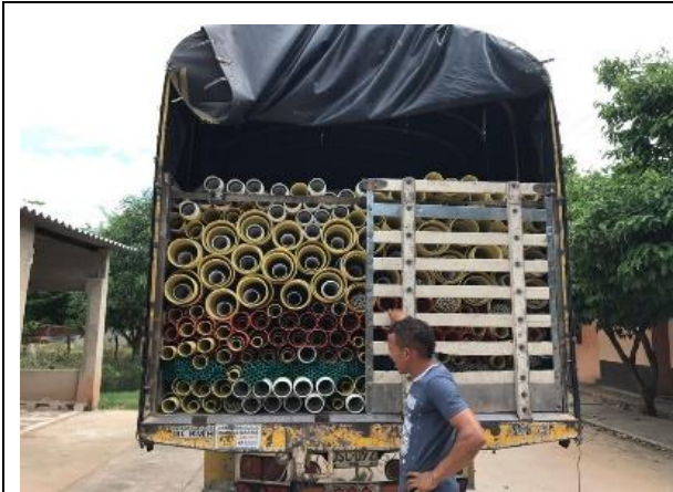
Ilustración 29 Recepción de tubería
