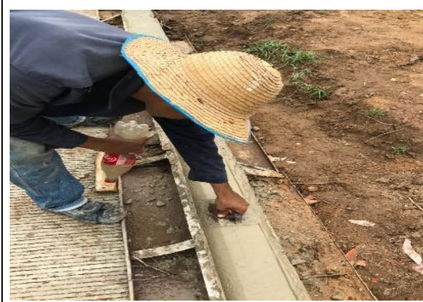
Acabado de bordillo
