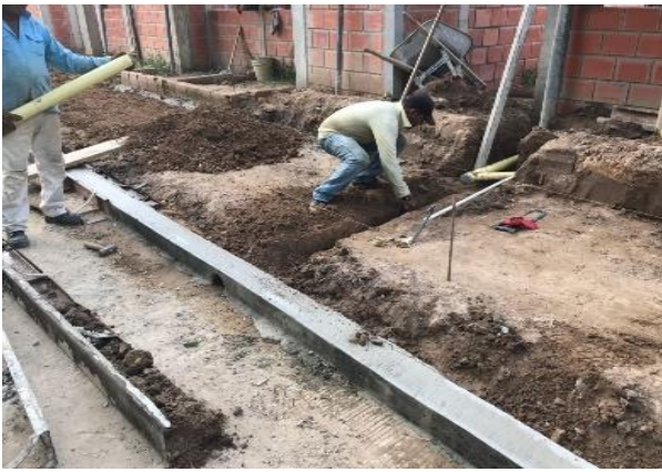
Retiro de formaletas de bordillo
