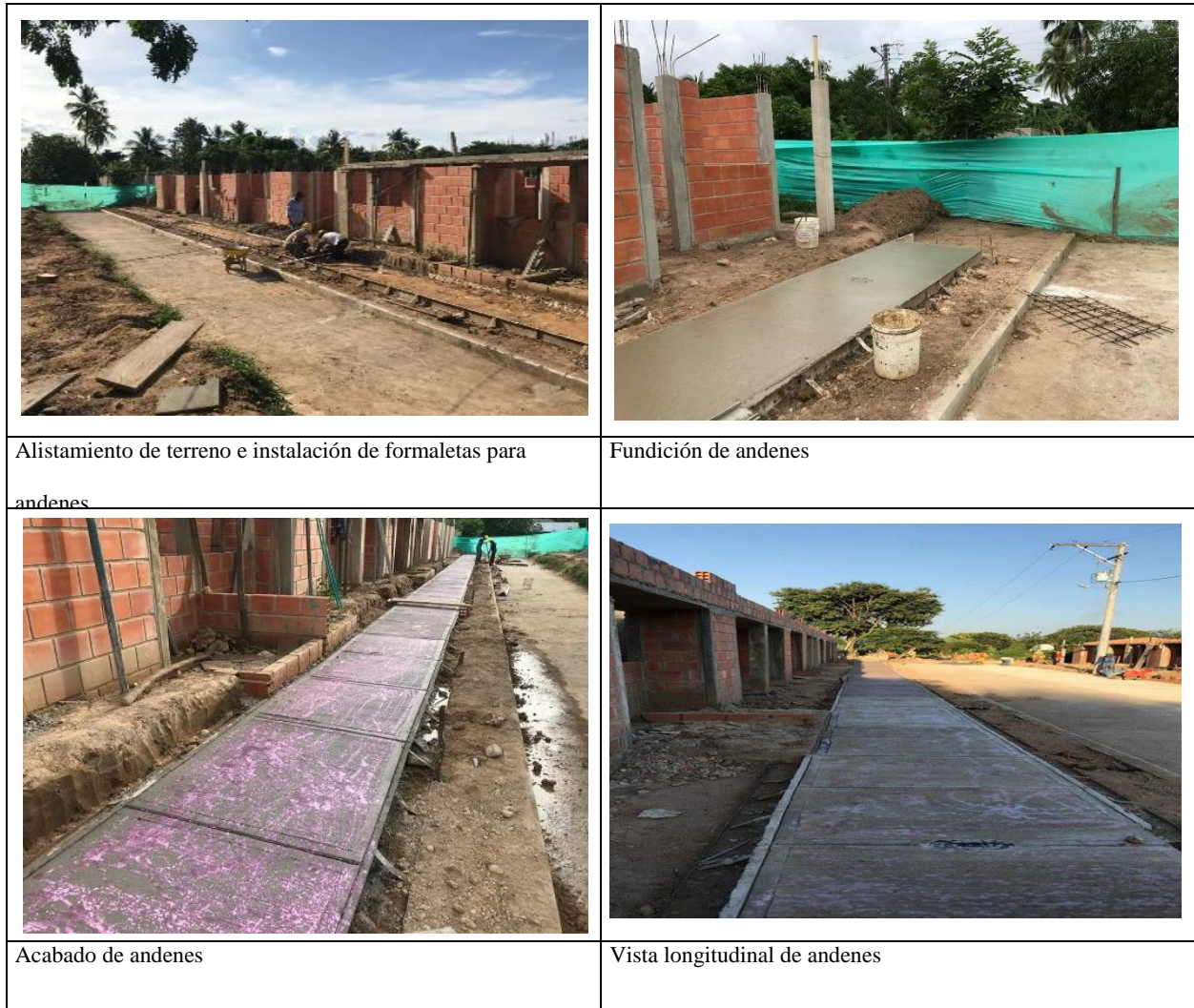
Ilustración 22 Registro fotográfico andenes en concreto
