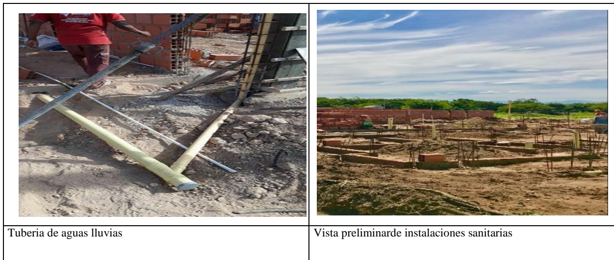
Ilustración 15 Registro fotográfico instalaciones sanitarias
