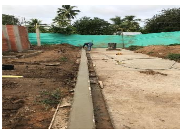
Fundición de bordillo
