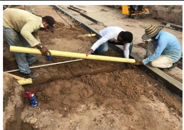
Instalacion de tuberias de aguas lluvias
