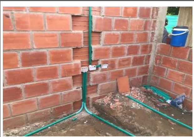
Instalación de tubería eléctrica sala
