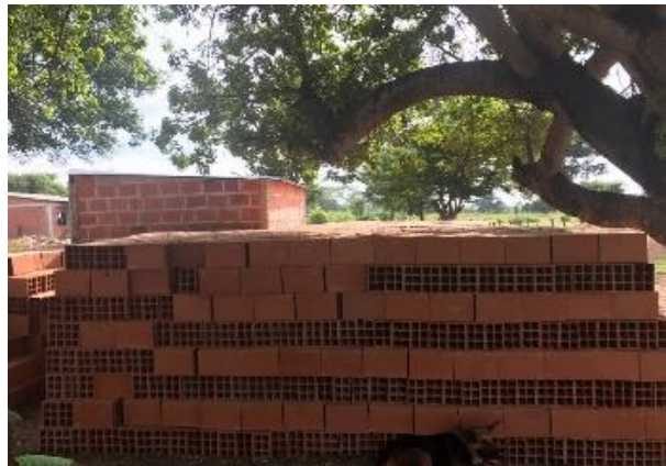
Ilustración 33 Almacenamiento de ladrillos
