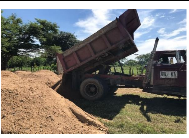
Ilustración 30 Recepción de arena
