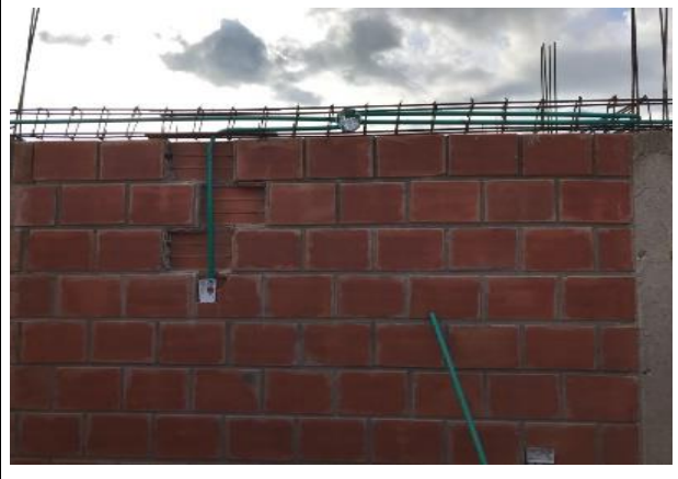
Instalación de tubería eléctrica en vigas y muros
