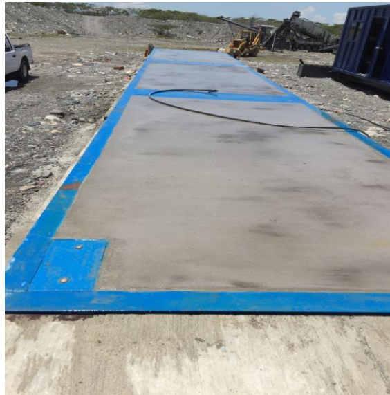
Ilustración 34. Fraguado de las planchas en concreto de 5000 PSI. Fuente. Autor
