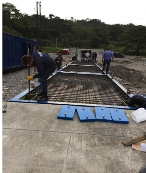
Ilustración 31. Instalación estructura metálica de bascula camionera. Fuente. Autor
