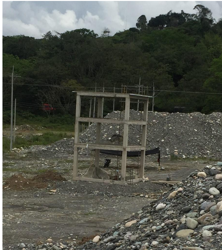
Ilustración 37. Estado inicial de la torre de control. Fuente. Autor
