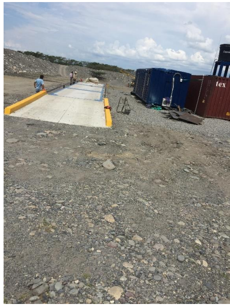
Ilustración 64. Instalación Guarda llantas. Fuente. Autor
