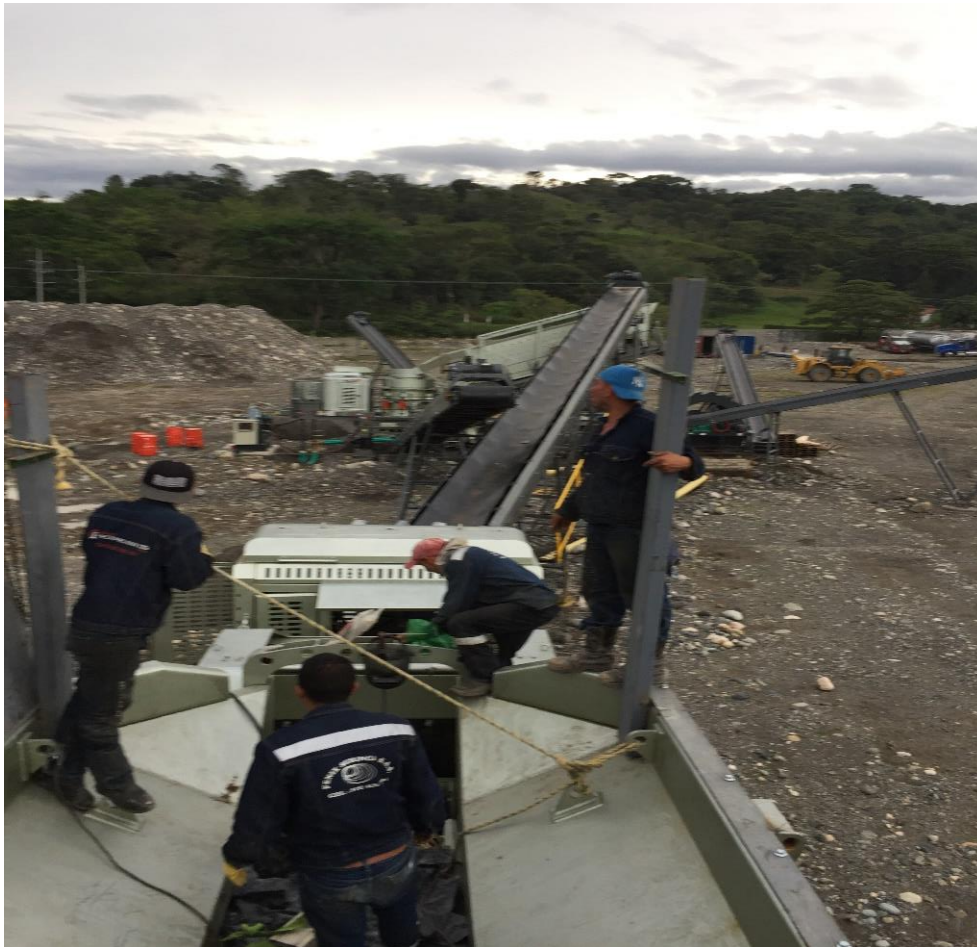
Ilustración 50. Técnicos de FENIX instalan Tolva. Fuente. Autor
