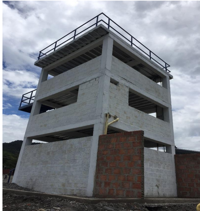
Ilustración 39. Torre de control en construcción. Fuente. Autor
