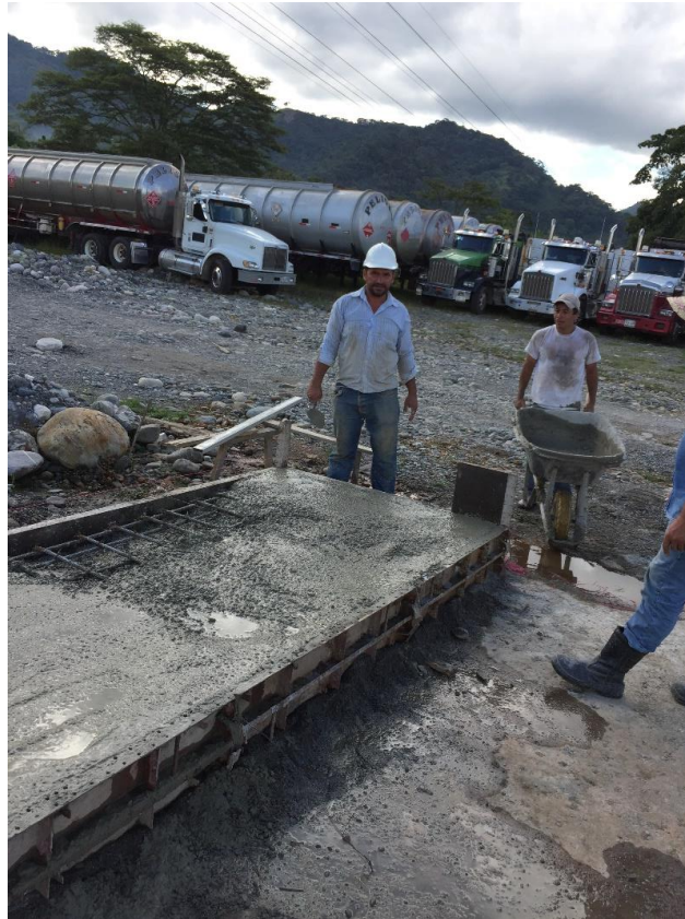
Ilustración 28. Fundición de bases para bascula camionera.
