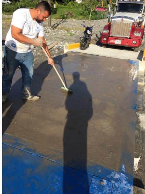
Ilustración 62. Macro texturizado del concreto. Fuente. Autor
