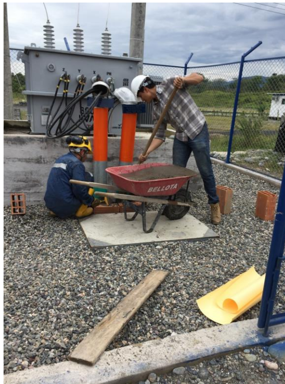
Ilustración 19. Aplicación cuidadosamente de concreto por parte del residente de Obra, concreto al que el mismo realizo diseño de mezcla. (Autor)
