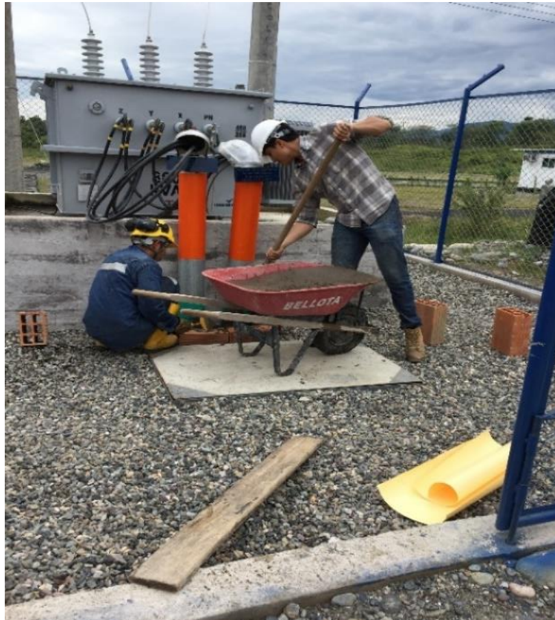
Ilustración 43. Protección y refuerzo a tubería eléctrica saliente del transformador. Fuente. Autor
