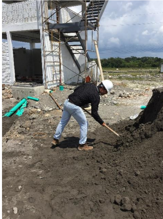
Ilustración 42. Protección a tubería eléctrica con arena de río. Fuente. Autor
