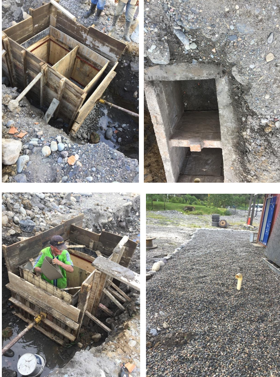
Ilustración 54. Construcción tanques de almacenamiento temporal. Fuente. Autor
