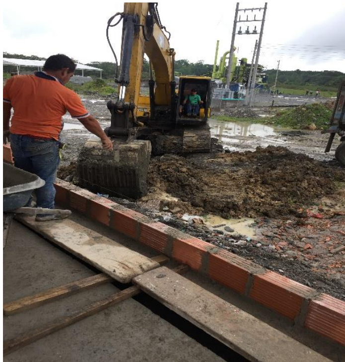
Ilustración 38. Cerramiento en bloque hueco de confinamiento pegado en Canto.
