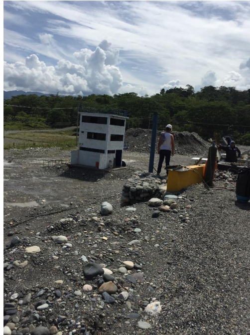
Ilustración 51. Construcción de Bordillo. Fuente. Autor
