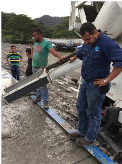
Ilustración 33. Bombeo de concreto 5000 PSI sobre la estructura metálica de la báscula. Fuente. Autor.
