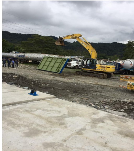
Ilustración 30. Transporte para ubicar estructuras metálicas de la báscula camionera. Fuente. Autor
