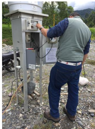
Ilustración 13. Señor Carlos Cárdenas técnico de TECNOAMBIENTAL realizando instalación de filtro para control de aire. (Autor)
