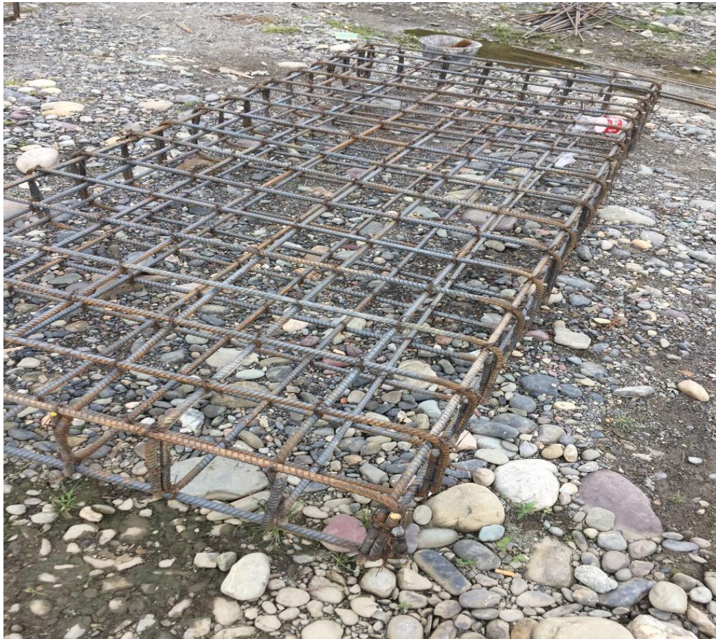
Ilustración 27. Refuerzo bases de bascula camionera. Fuente. Autor.
