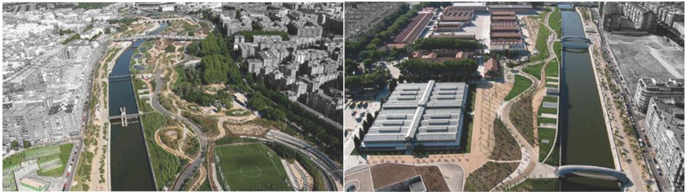
Ilustración 4 Fotografía proyecto Rio en Madrid
