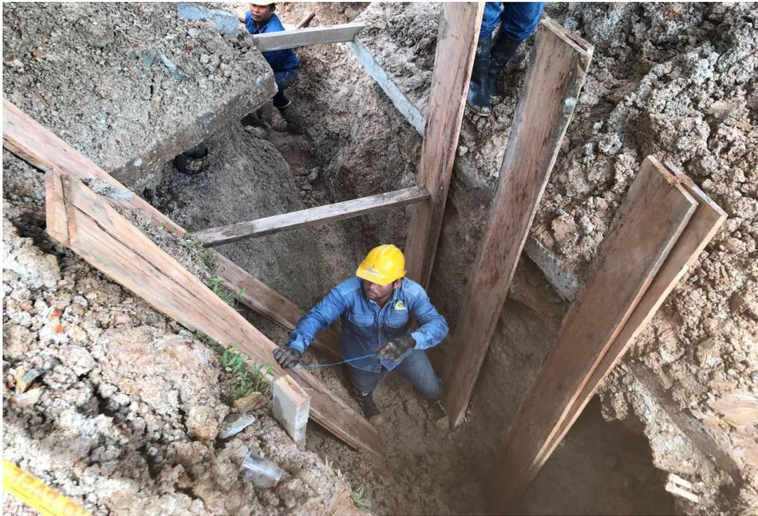
*Ilustración 25 Entibado de la excavación*
