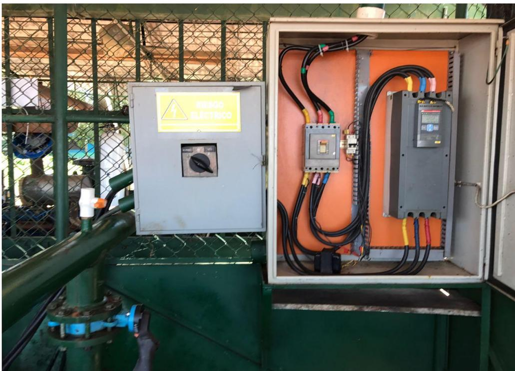
*Ilustración 22 Tablero de control de Motobombas*
