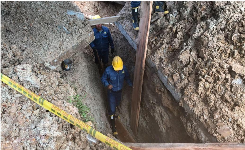
*Ilustración 24 Excavación Tubería Debajo de una Vía*
