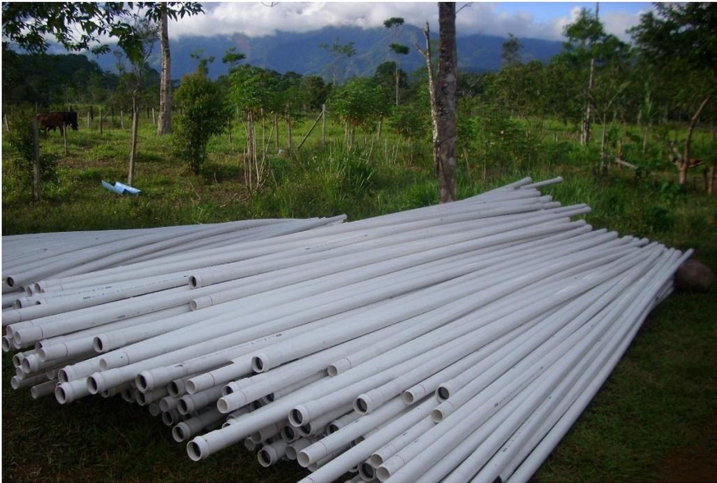
*Ilustración 19 Tubería PVC para la instalación de la línea de conducción*
