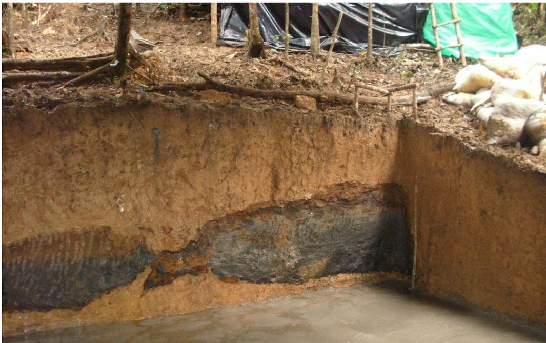
*Ilustración 26 Excavación Tanque Desarenador*
