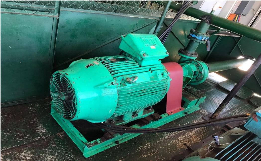
*Ilustración 10 Motobomba utilizada para la Captación*
