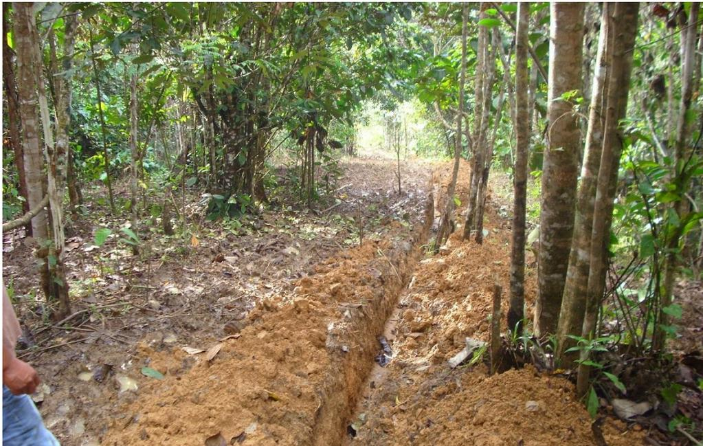
*Ilustración 23 Excavación para la instalación de un tramo de tubería*
