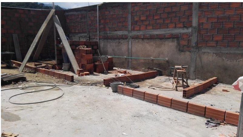
Imagen 17. Campamento para oficinas del personal administrativo y almacén
