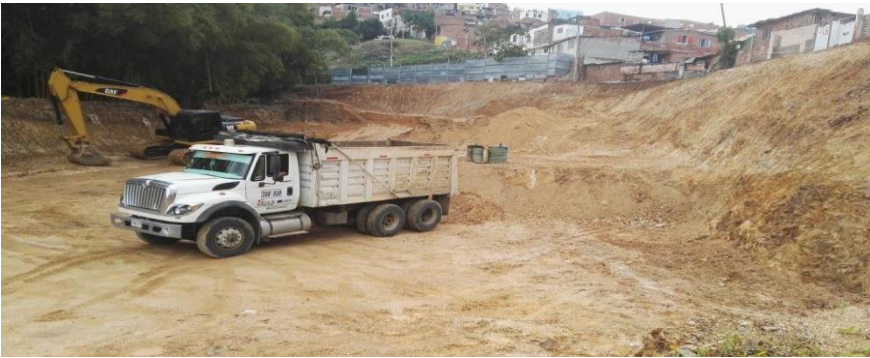
Imagen 22. Fotografía del proceso de excavación.
