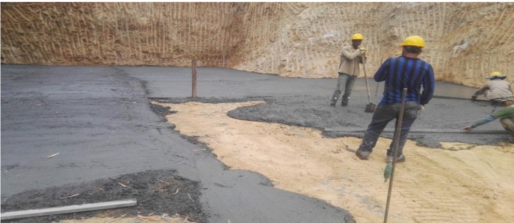
Imagen 24.Concreto de limpieza
