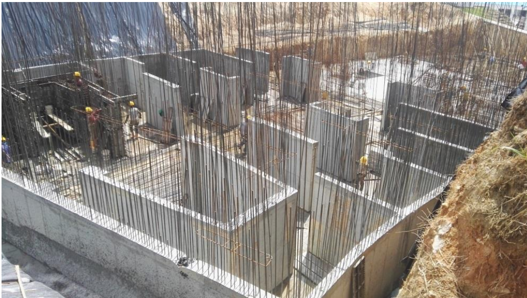
Imagen 31. Pantallas y muros de contención en etapa uno.
