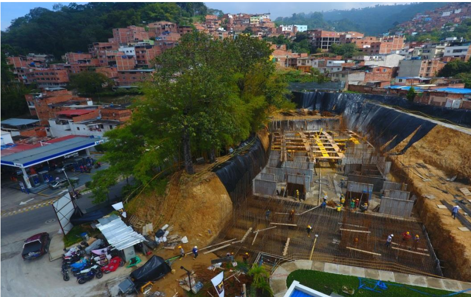
Imagen 28. Armado de cimentación muros, columnas, placa entre piso
