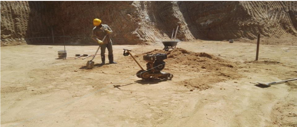
Imagen 23.Replanteo y nivelación.
