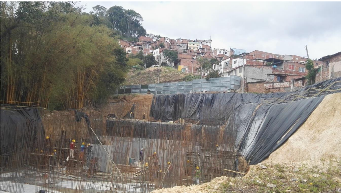
Imagen38. Protección de talud en plástico
