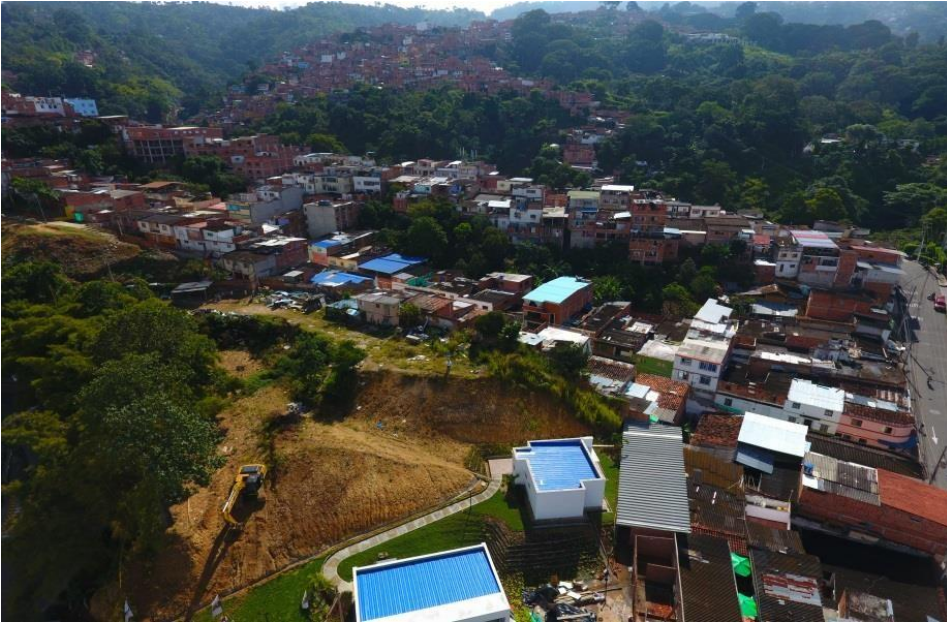
Imagen 20. Fotografía del proceso de descapote.
