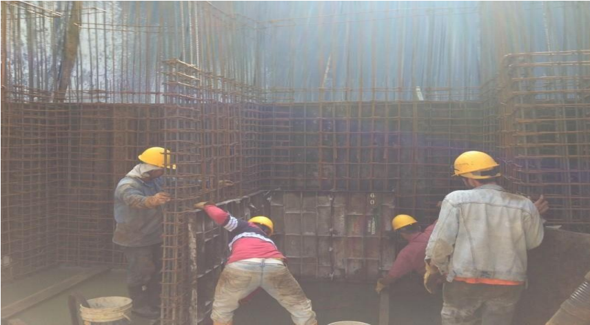
Imagen 27 Armado de refuerzo de pantallas y columnas
