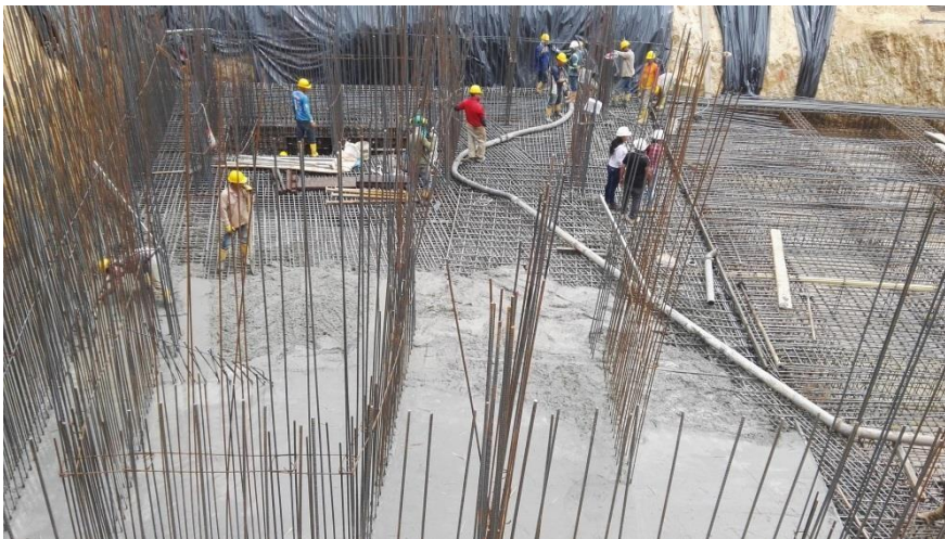
Imagen 30. Vertimiento de concreto en la losa de cimentación
