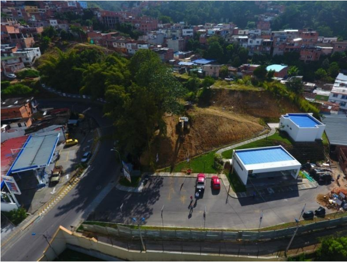
Imagen 16. Encerramiento en zinc del área de trabajo.
