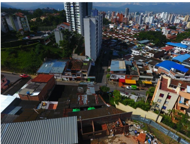
Imagen 18. Fotografía del proceso de construcción de campamentos
