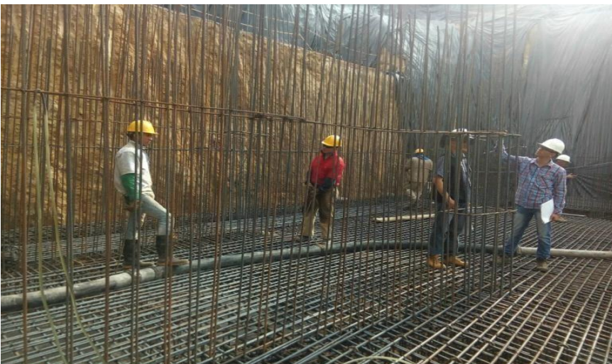
Imagen 26. Revisión del acero de refuerzo junto con supervisión técnica
