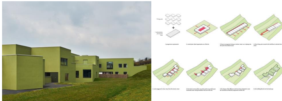
Ilustración 15 Imagen Casa de Retiro
