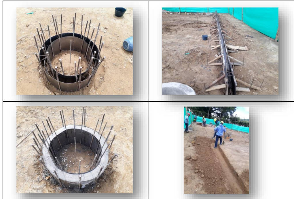
Ilustración 17. Jardinera en concreto de 3000 psi e= 10 cm
