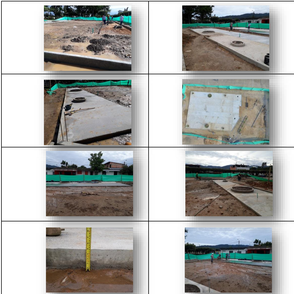
Ilustración 27. Piso en concreto de 3000 psi e= 10 cm
