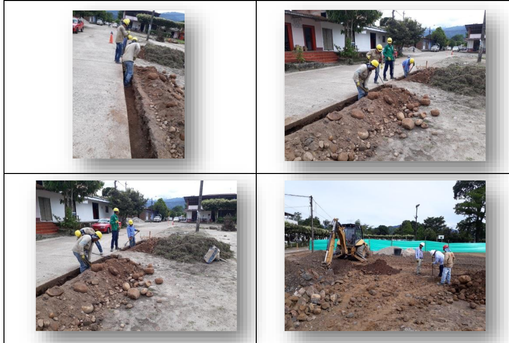
Ilustración 8. Excavación en material común incluye retiro
