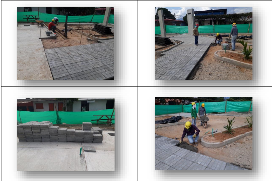
Ilustración 28. Suministro e instalación de tableta en concreto
