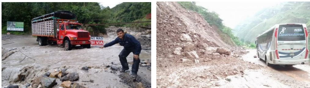
Foto 1. Estado de la Vía a pamplona, vía la Soberanía
