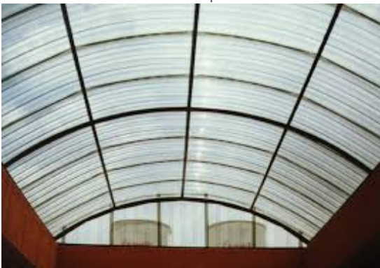
Ilustración 78. Cubierta con policarbonato alveolar
