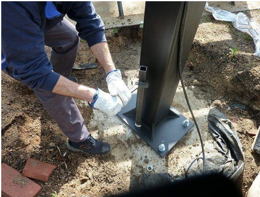
Imagen 1: Placa de Anclaje
