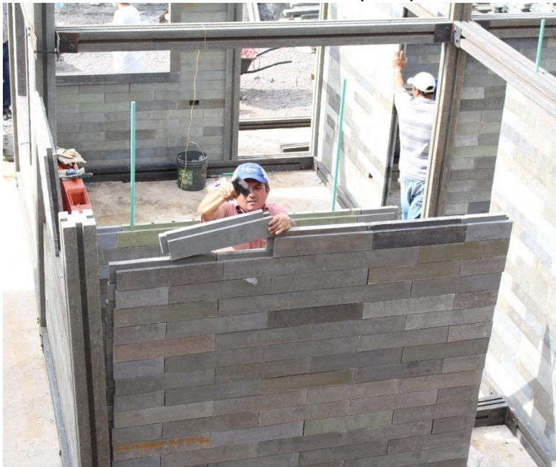
Imagen 6: Proceso de Construcción
