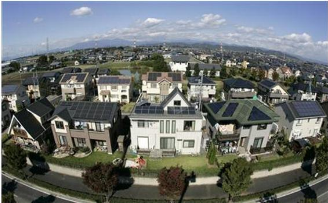
Imagen 24: Vecindario accionado con energía solar.
