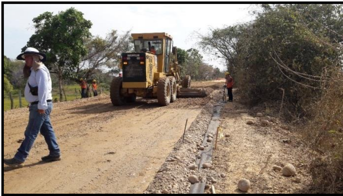
Figura10. Nivelación Y Compactación Material Granular Para Mejoramiento.
