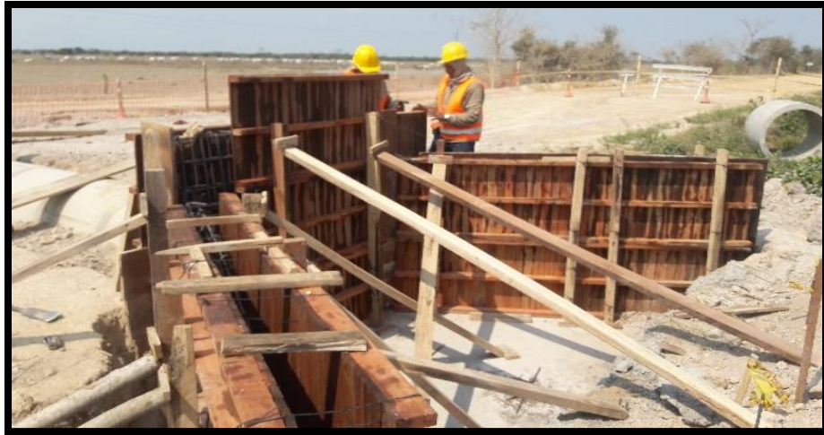
Figura 28. Construcción De Muro Cabezal Para Alcantarilla.
