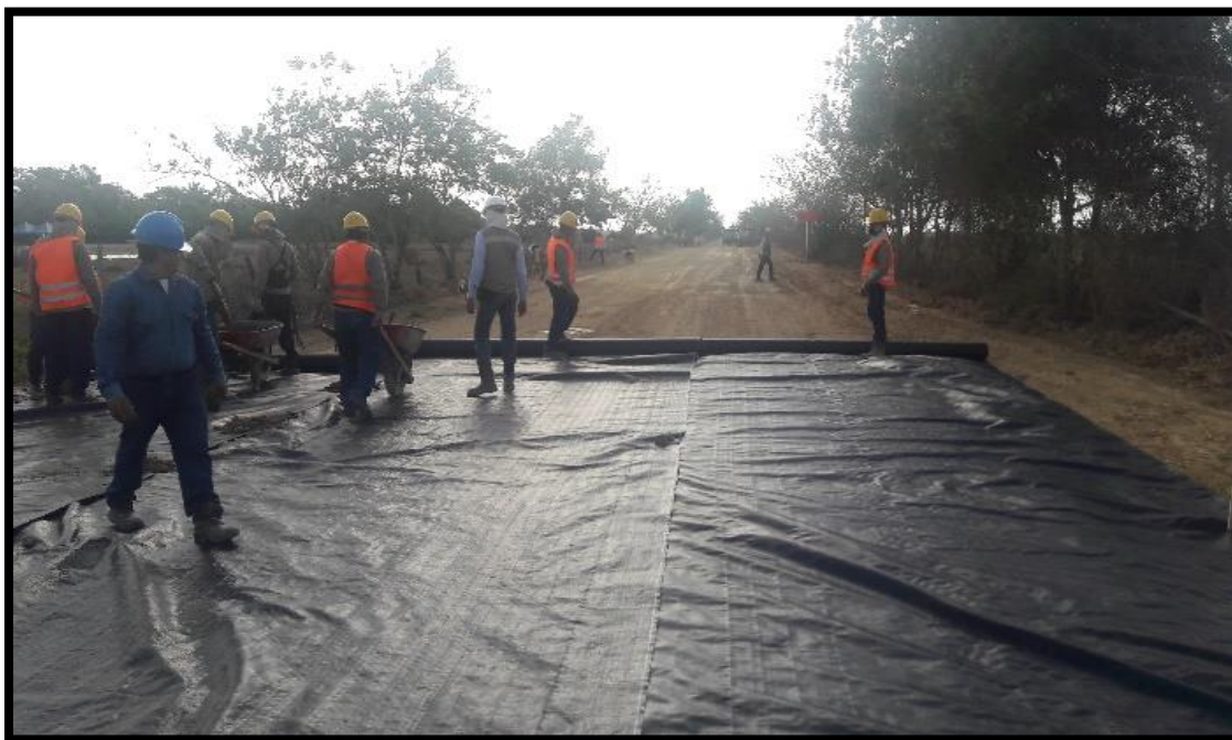
Figura 22. Instalación De Geotextil.
