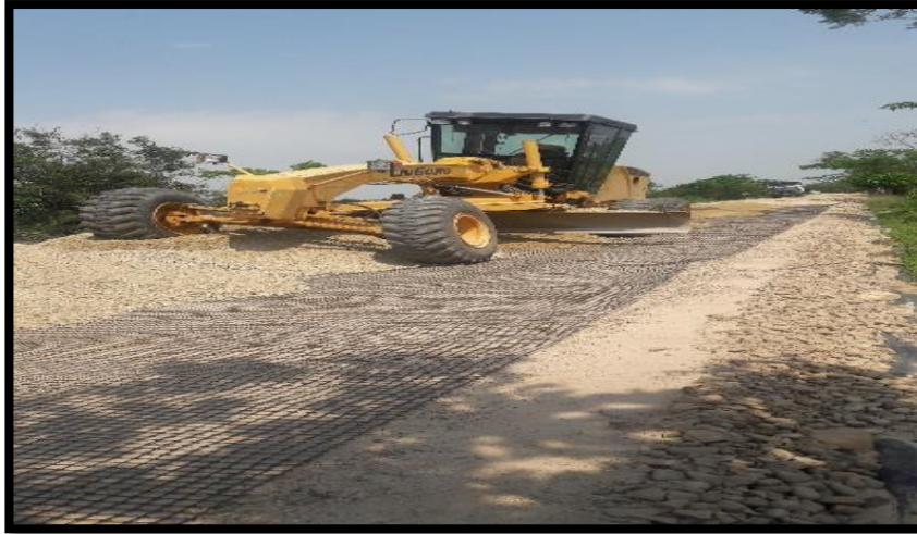
Figura 57. Acopio Y Extendida Del Material Base Granular.
