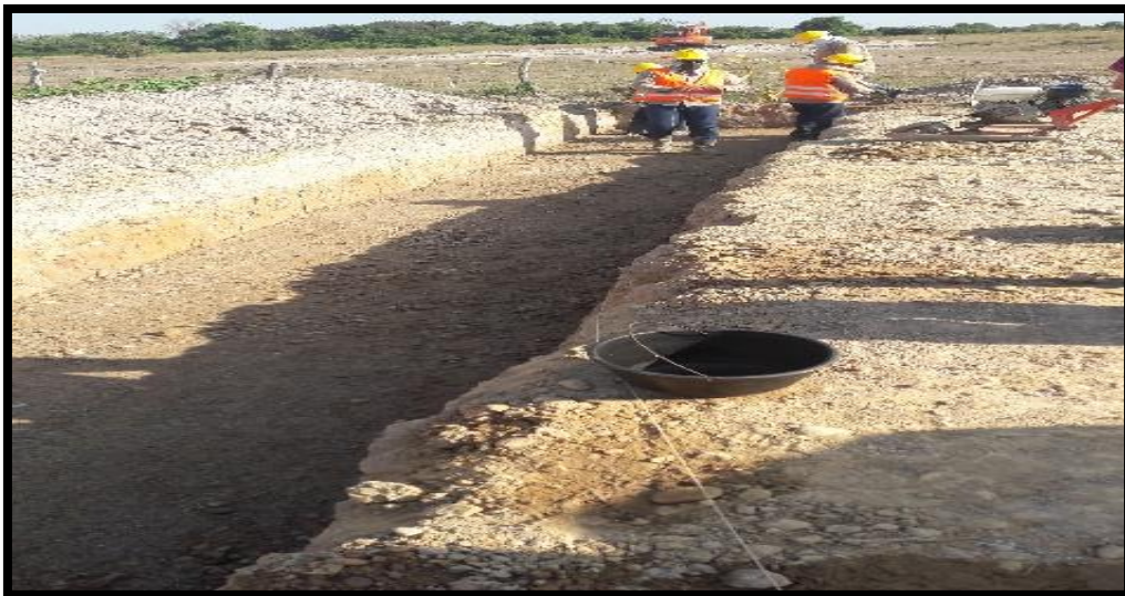
Figura 14. Nivelación Fondo Excavación.
