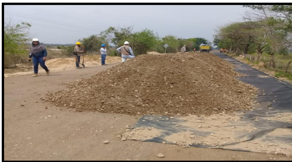
Figura 36. Disposición De Material Granular
