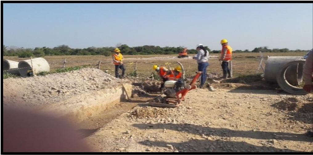
Figura 13. Localización Y Nivelación De Obras De Arte.
