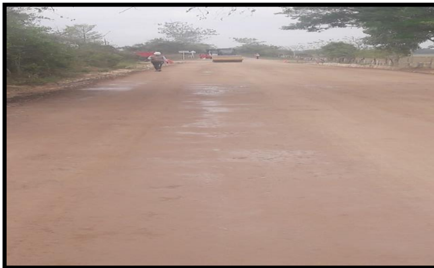
figura 47. Trabajos De Compactación De La Subbase Granular.
