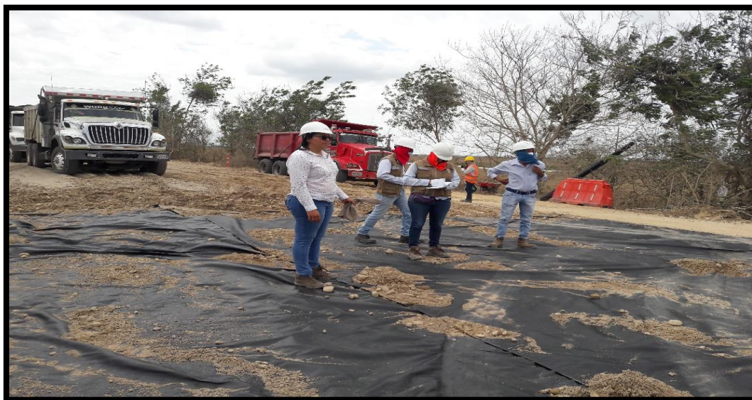
Figura 24. Instalación De Material Granular Para Mejoramiento.
