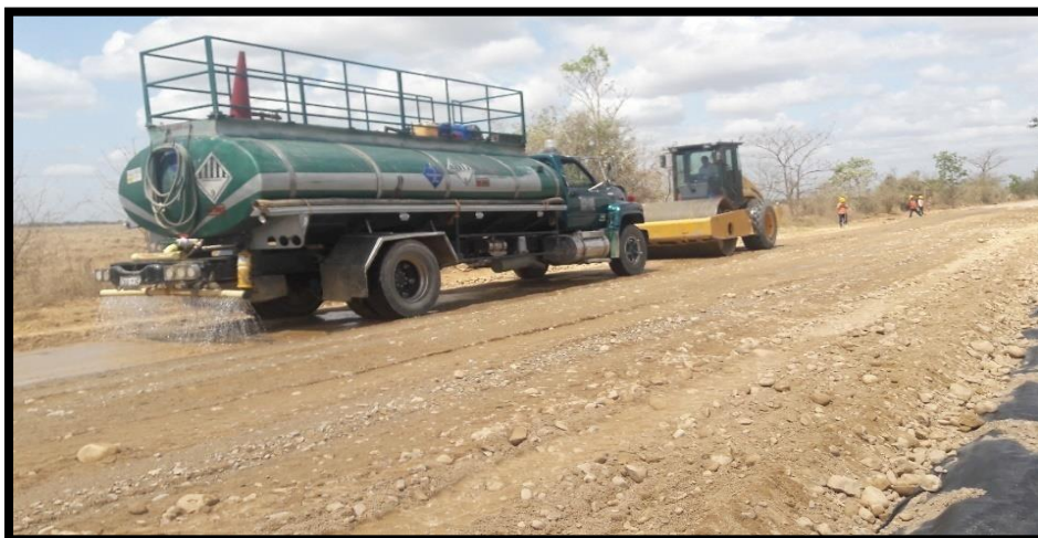
Figura 44. Riego De Agua Para Humedecer El Material Granular.
