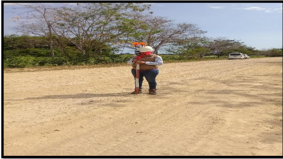
Figura 5. Trabajos De Localización Y Replanteo Topográfico
