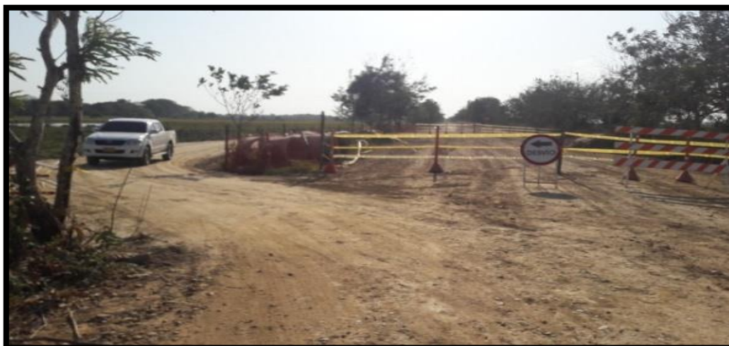
Figura 12. Desvío Temporal De La Vía. Vista Fondo.
