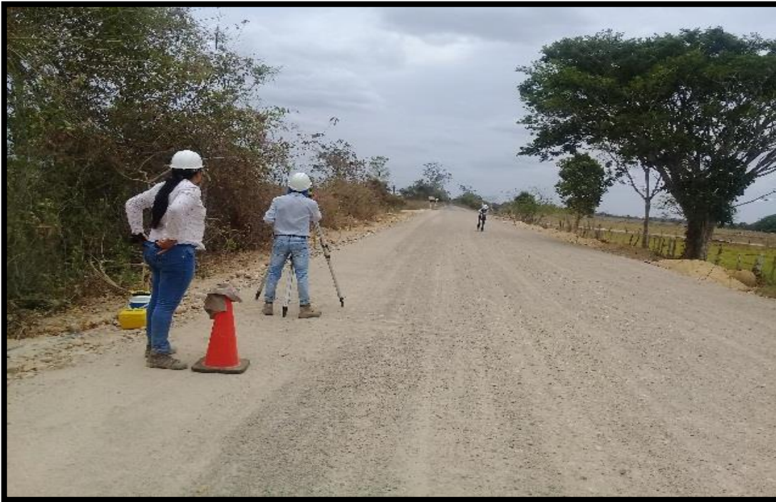
Figura 20. Levantamiento Topográfico Personal De Interventoría.
