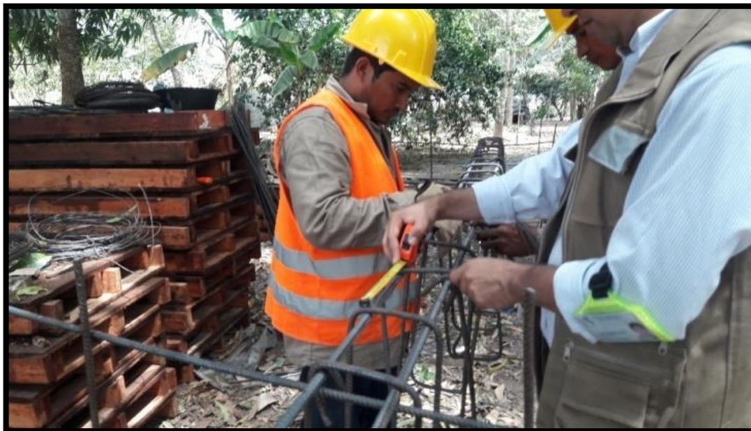
Figura 17. Verificación Acero De Refuerzo.
