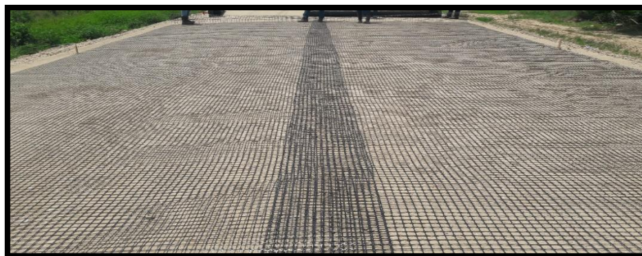
Figura51: Traslapo Longitudinal De La Geomalla.
