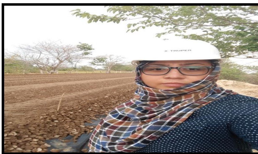
Figura 37. Instalación De Pedraplen Para Recuperación De Fallo.
