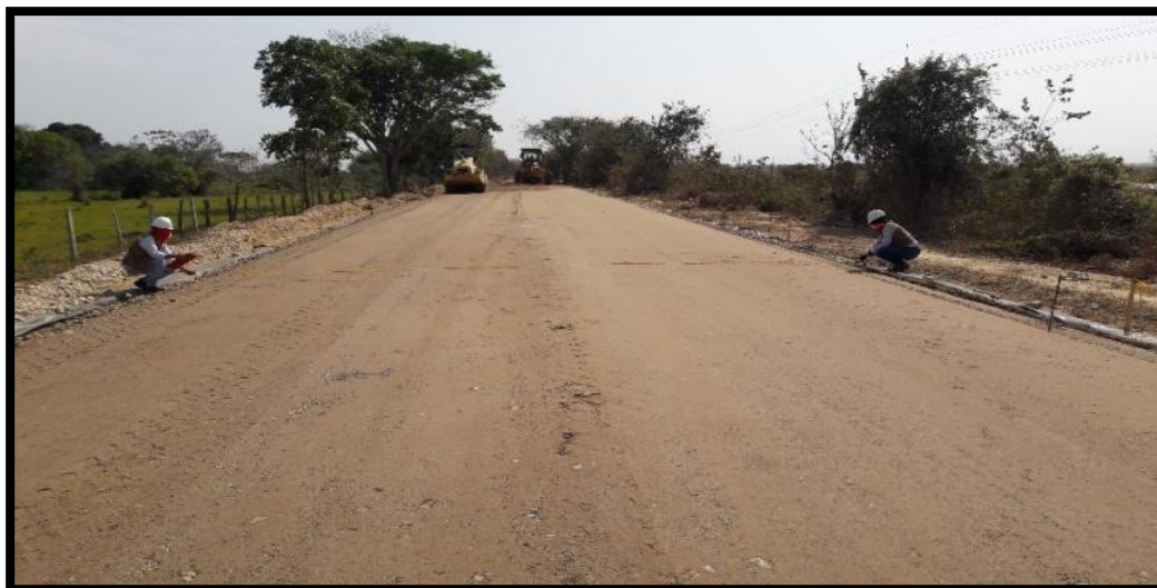
Figura 11. Medición Del Ancho De La Vía Para Verificar Diseño De Pavimento.
