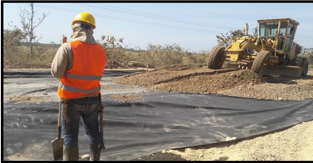
Figura 43. Nivelación Con Material Clasificado
