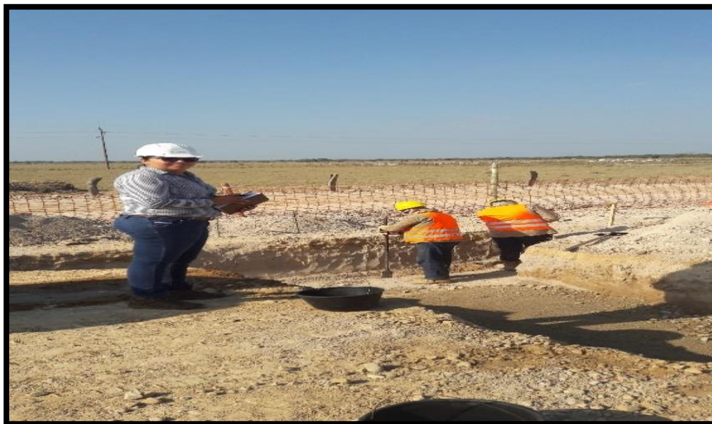
Figura 15. Medición De Excavación.
