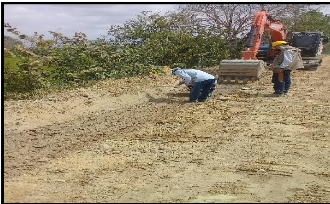
Figura 35. Excavación De Fallo Sobre Hombro Izquierdo De La Vía.
