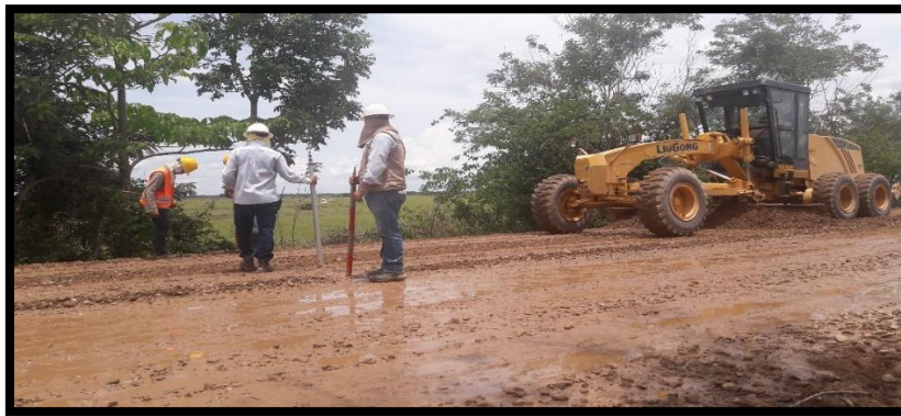
Figura 54. Toma De Lecturas Para Re Nivelación De La Subbase Granular.
