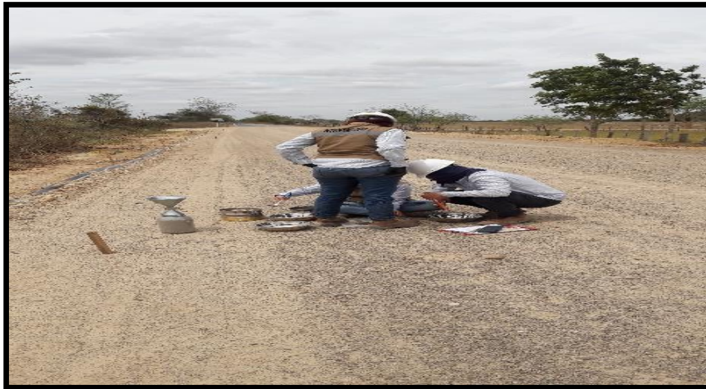
figura 26. Verificación De Densidad Sobre Estrato De Material Granular.
