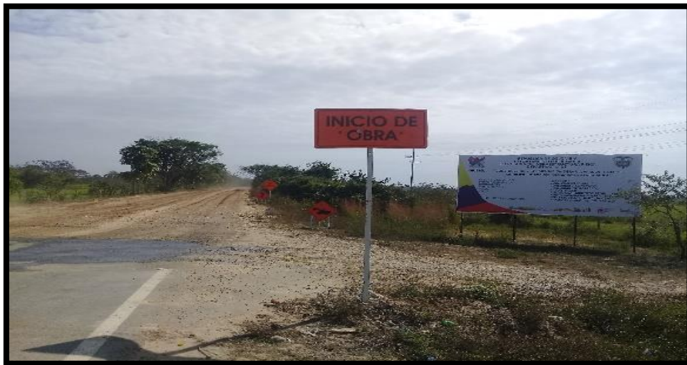
Figura 6. Señalización De La Vía
