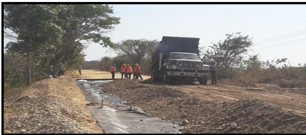
Figura 42. Suministro De Material Granular.
