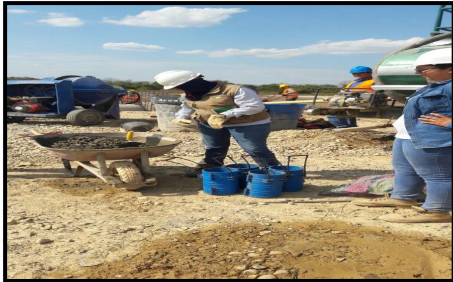
Figura 30. Toma De Muestras De Concreto
