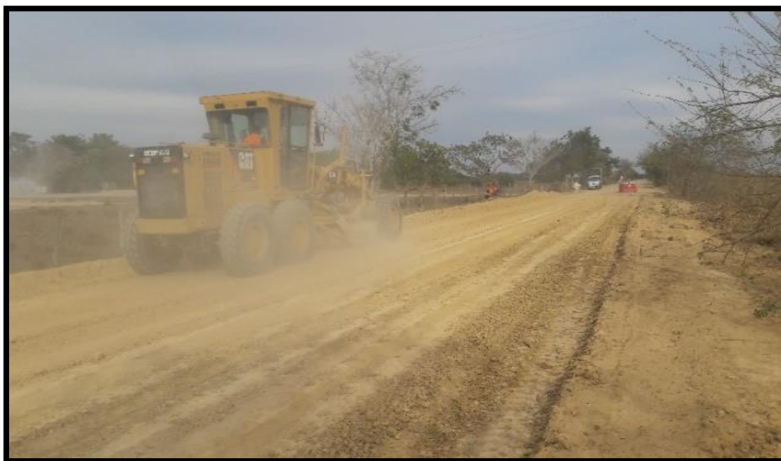
Figura 21. Excavación Mecánica Para Mejoramiento De Subrasante.
