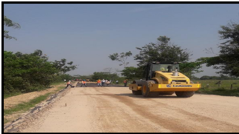
Figura Proceso De Compactación De La Base Granular.
