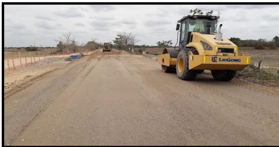
Figura 45. Compactación De La Rasante Terminada.
