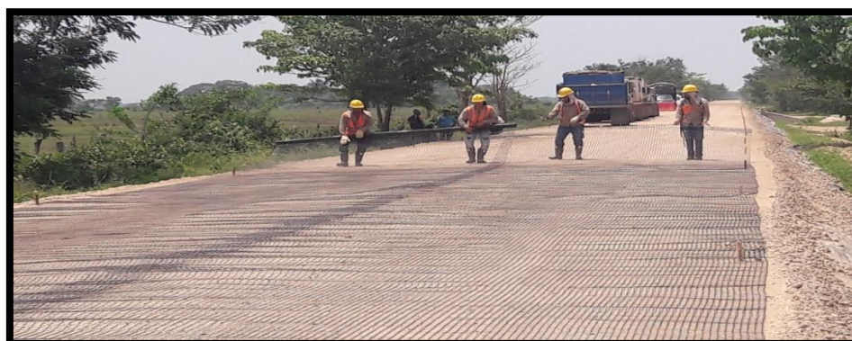
Figura52: Instalación Progresiva De La Geomalla.
