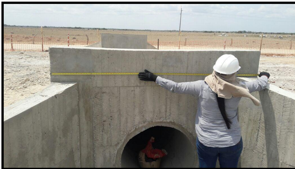
Figura 32, 33. Terminado En Concreto De Aletas Y Cabezal De Alcantarilla. •
