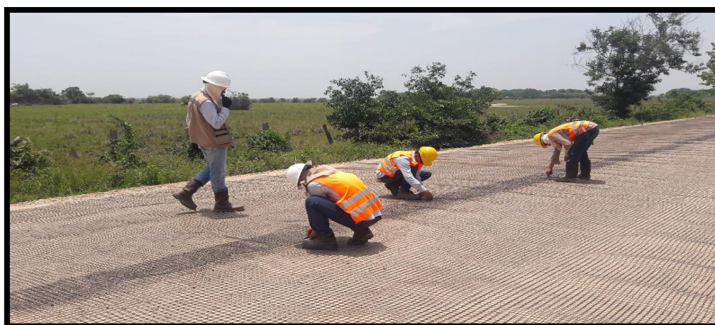
Figura 50: Revisión E Instalación De Geomalla Para Refuerzo.
