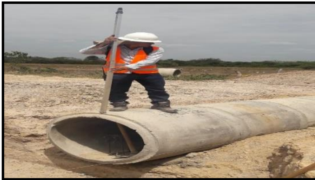
Figura 16. Nivelación De Tubería
