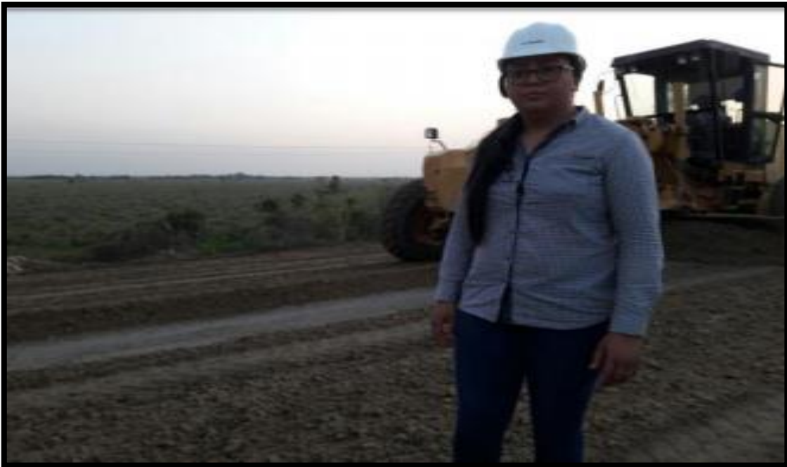
Figura 23. Instalación De Material Granular Para Mejoramiento
