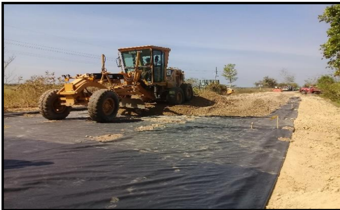
Figura 39. Instalación De Material Granular Para Mejoramiento
