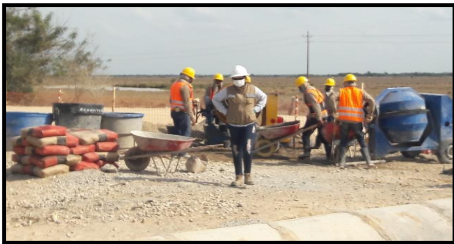
Figura 29. Control Elaboración Mezcla De Concreto.
