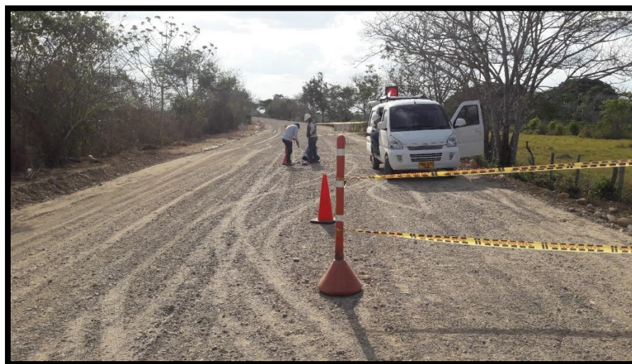
Figura 58. Toma De Densidades De La Base Granular.
