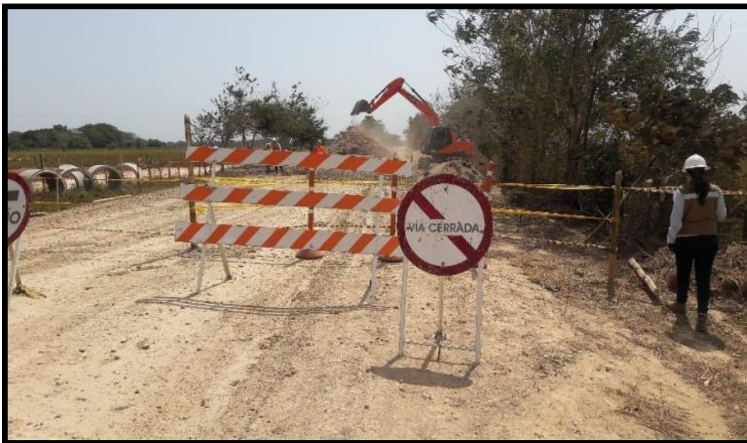
Figura 18. Señalización Sitios De Obra.
