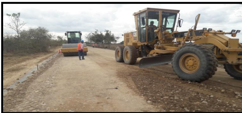
Figura 25. Instalación Y Compactación De Estrato De Mejoramiento.
