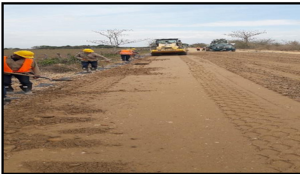
figura 27. Trabajos De Compactación Material Tamaño Máximo 3”
