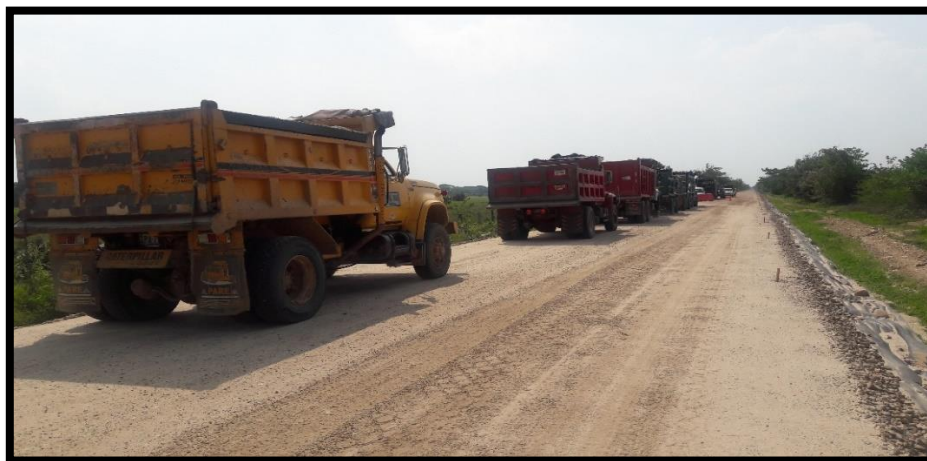
Figura 56. Transporte De Material Base Granular.
