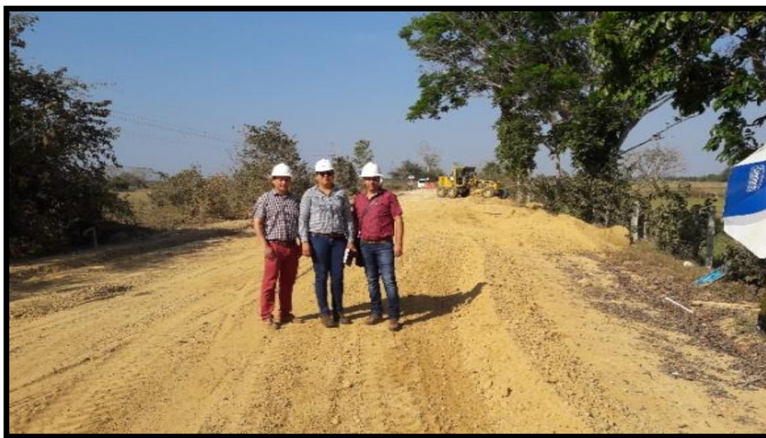
Figura 8. Mejoramiento Del Terreno Soporte Mediante Adición De Material Granular E Instalación De Geotextil Entre Subrasante Y Material Granular.
