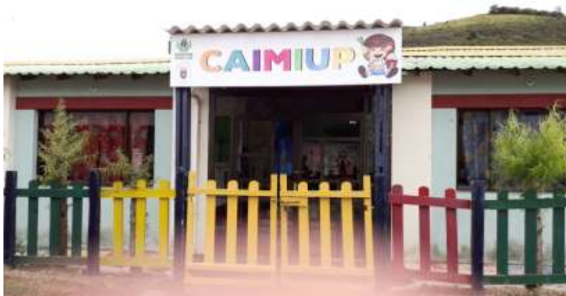
Figura 18. Entrada principal del Caimup ubicado en las instalaciones de la Universidad de Pamplona
