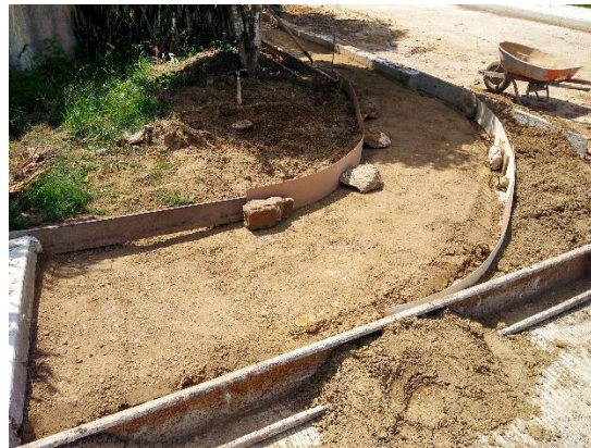
Ilustración 36 armado andenes monolíticos
