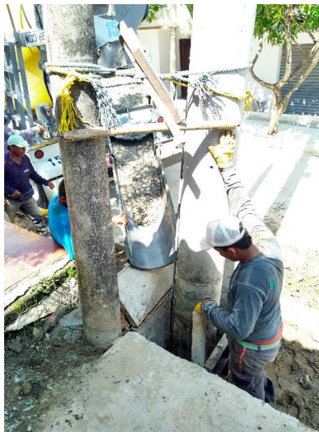
Ilustración 46 Fundición pedestal poste
