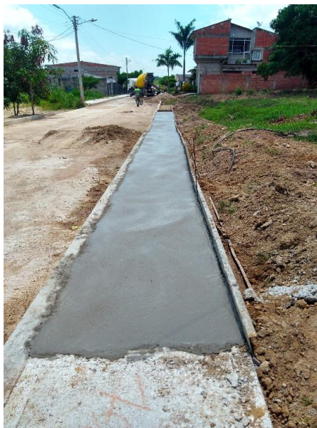
Ilustración 37 Fundición andenes
