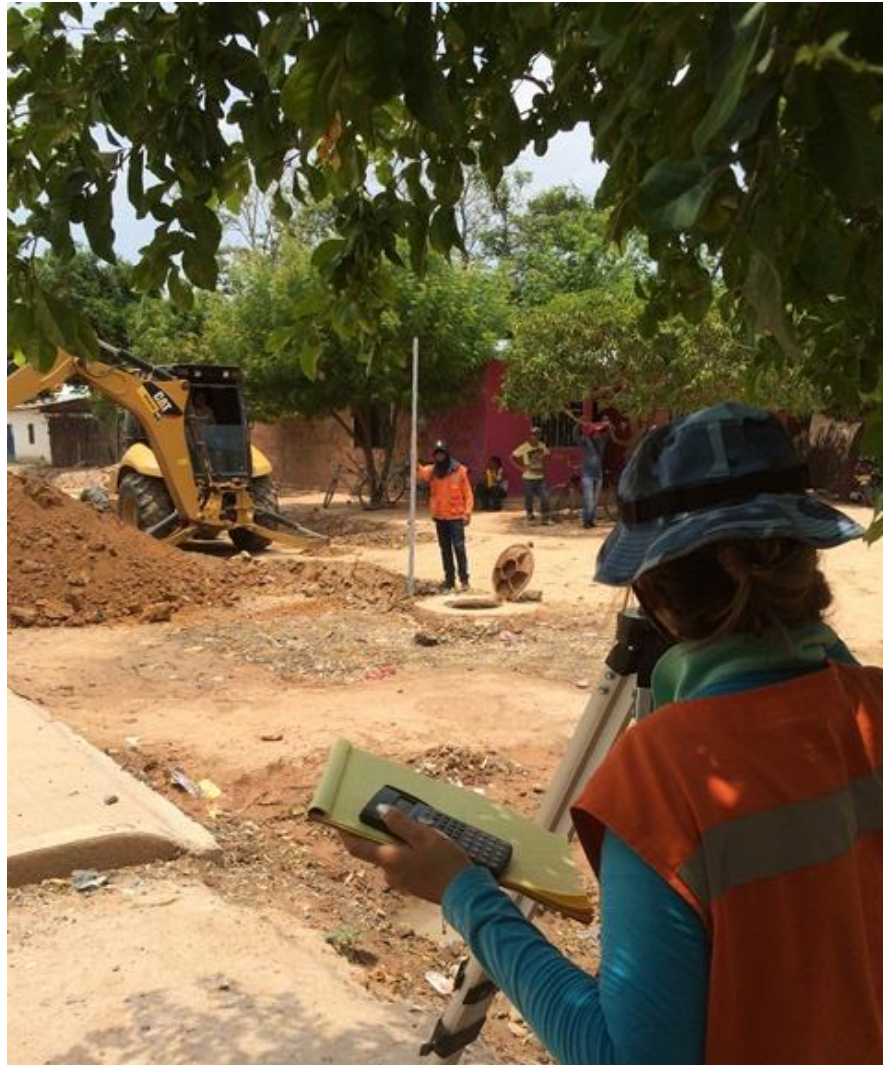
Figura 32. Adecuación de la sub base.
