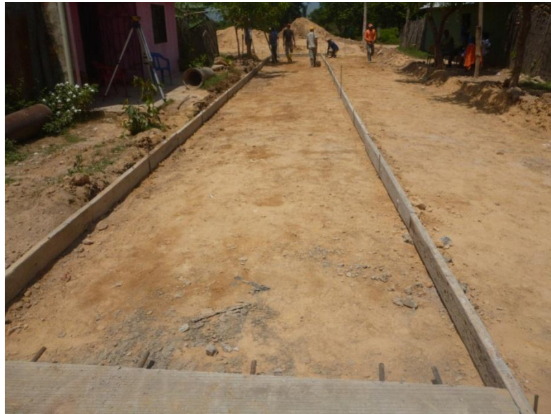
Figura 34. Adecuación de formaletas.
