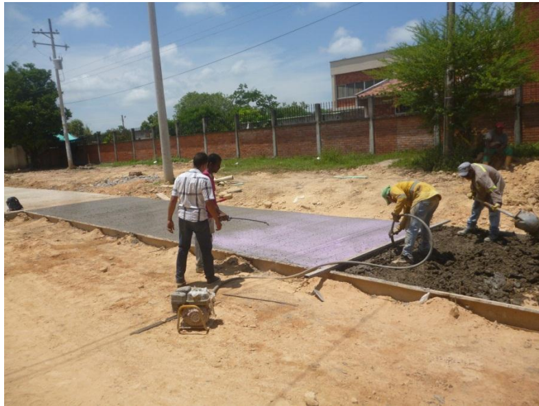
Figura 42. Aplicación de antisol.
