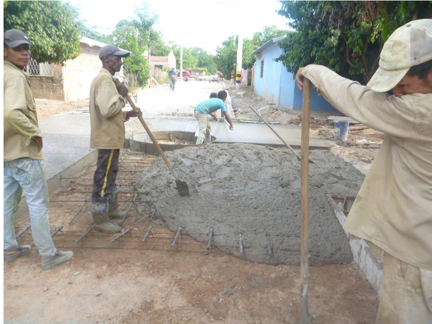
Figura 40. Colocación de la malla de acero.
