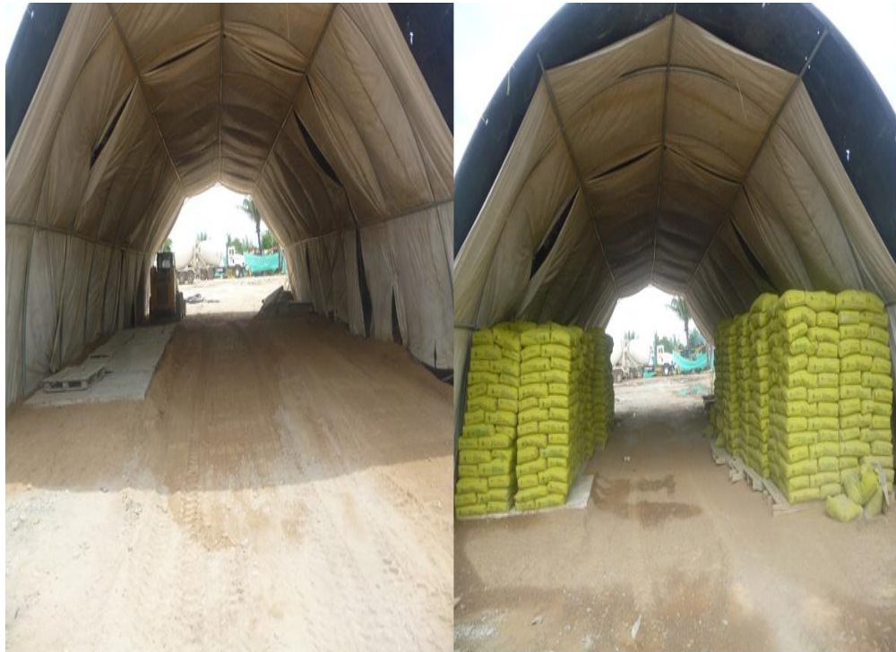
Figura 11. Almacenamiento de cemento.
