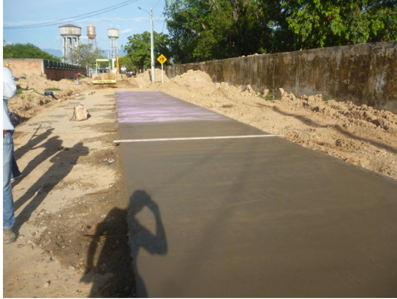
Figura 41. Acabado de la placa.
