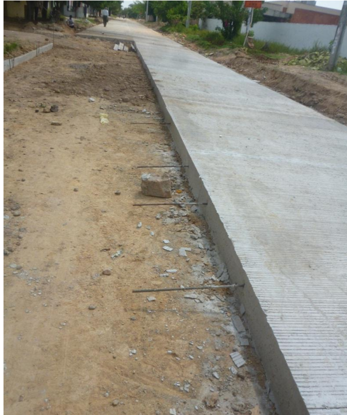
Figura 37. Barras de unión.
