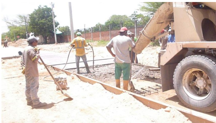
Figura 39. Vibrado de la mezcla.
