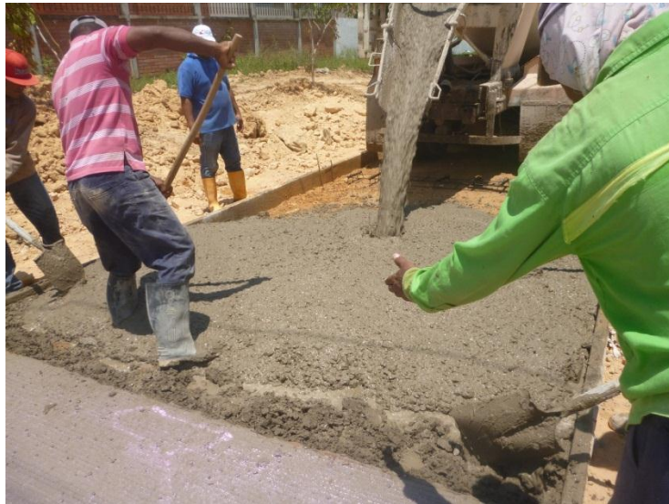
Figura 38. Vaciado de concreto.
