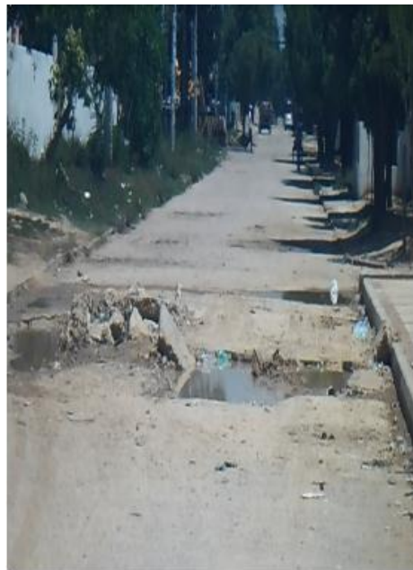
Figura 10. Carrera 7 entre calles 3 y 7.
