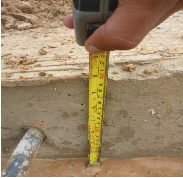
Figura 45. Verificación del espesor de la placa.
