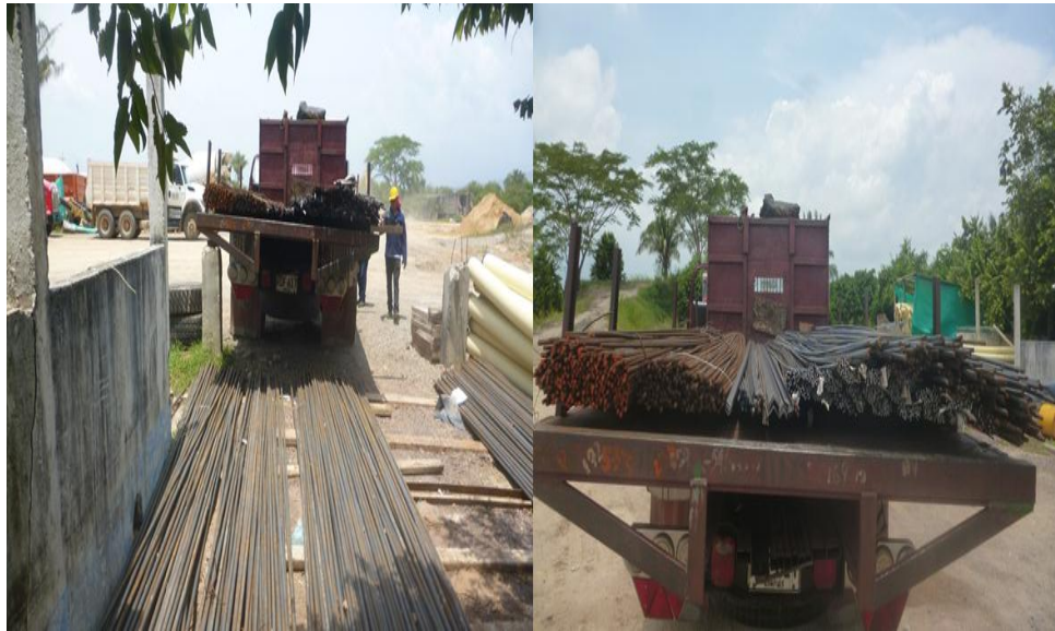
Figura 15. Almacenamiento de varillas.
