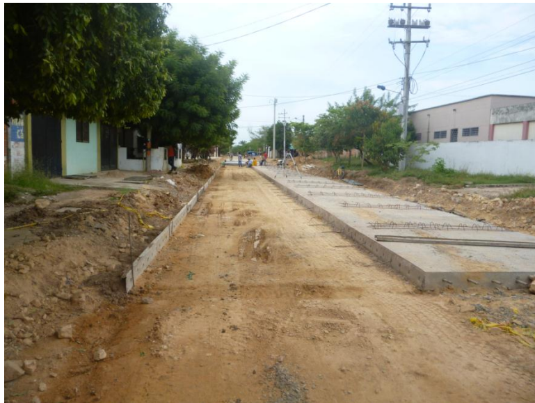
Figura 44. Placas desencofradas.
