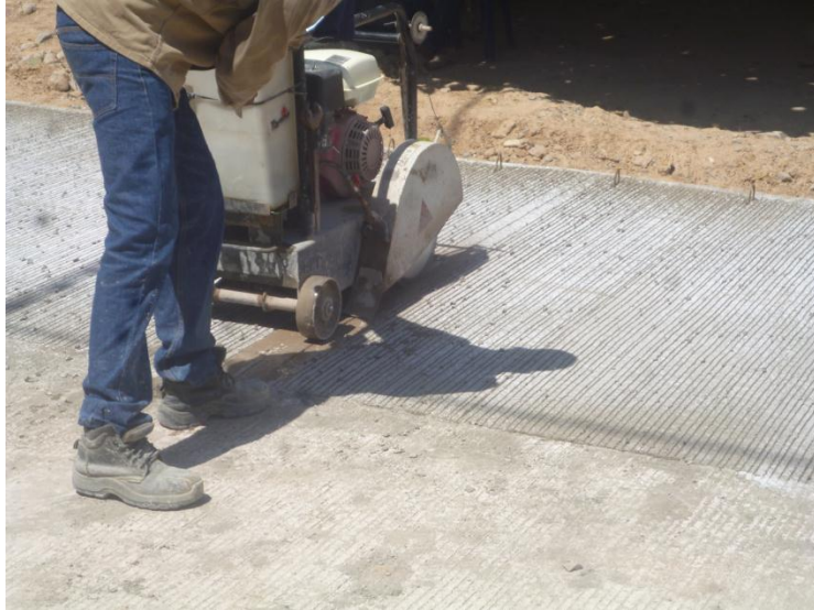
Figura 43. Corte de la placa.
