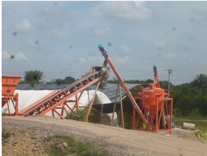
Figura 27. Vista de la planta.
