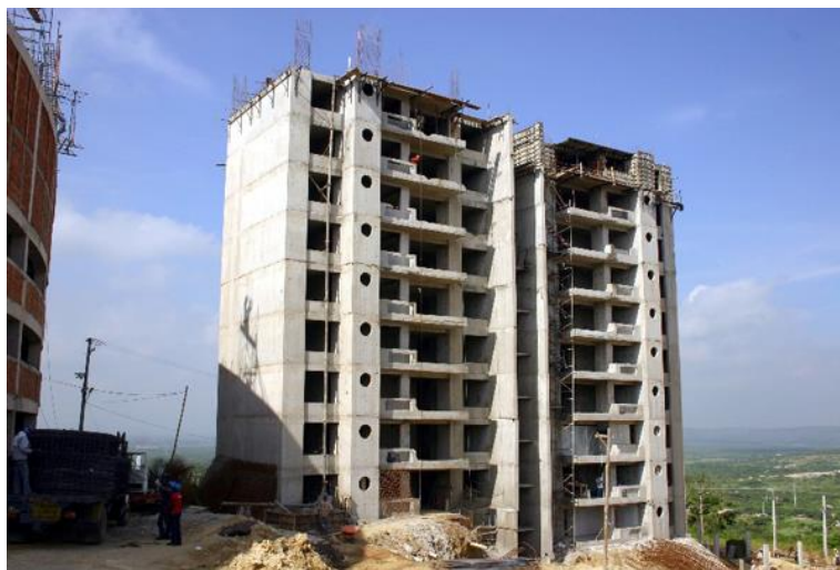
Figura 29: Ejemplo Sistema Estructural Dual, Fuente: Wikimedia-westernforms ,
