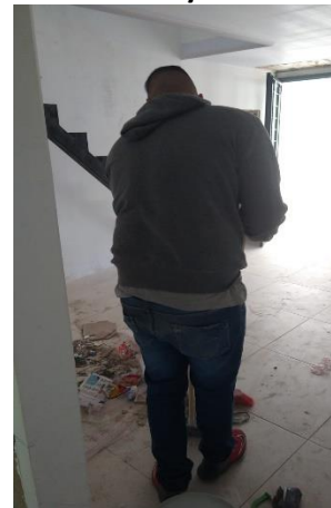
Foto 26|. Orden y aseo en obra
