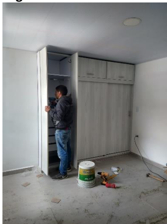
Foto 7. Seguimiento Actividades de acabados
