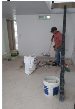
Foto 24. Orden y aseo en obra
