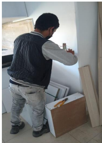
Foto 11. Seguimiento Actividades de eléctrica
