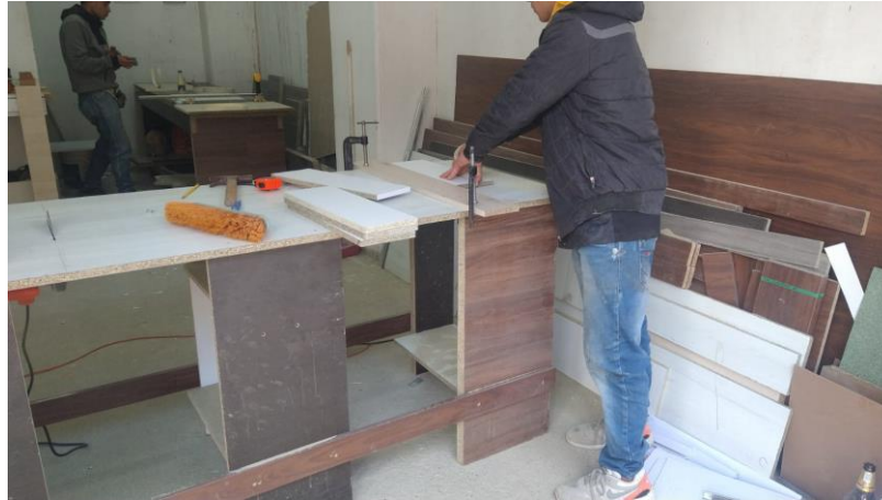
Foto 30. Maquinaria de obra
