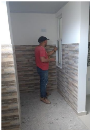
Foto 23. Seguimiento Actividades eléctrica
