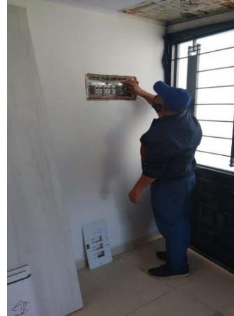
Foto 16. Seguimiento Actividades eléctrica
