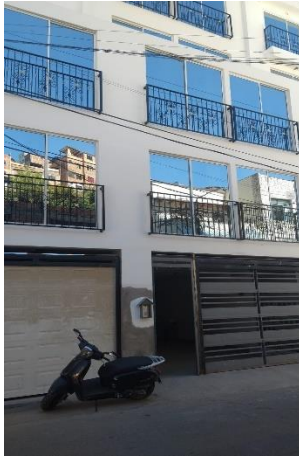
Foto 21. Fachada de obra
