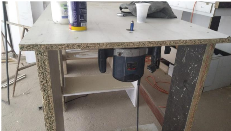
Foto 28. Maquinaria de obra
