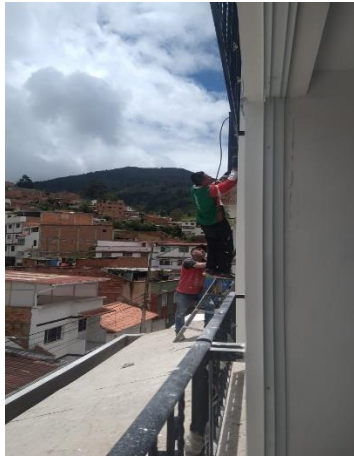
Foto 1. Seguimiento trabajo de altura
