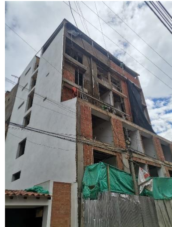
Foto 2. Seguimiento actividades de fachada
