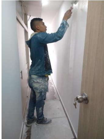
Foto 5. Seguimiento Actividades de pintura
