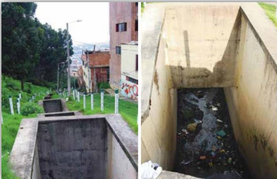
*Figura 29.* Tramo canalizado del “sistema de drenaje 1” ALCALDÍA MAYOR DE BOGOTÁ. 2012-2015. Tramo canalizado del “sistema de drenaje 1” de Pardo Rubio.
