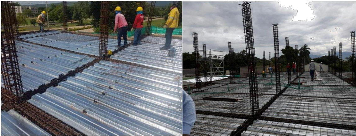
Imagen 35. Instalación de malla electrosoldada en placa entrepiso Fuente: Autor
