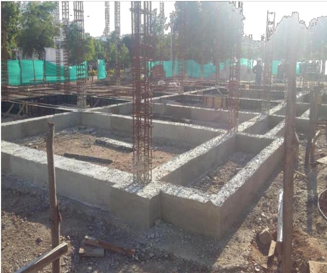
Imagen 13. Vigas de cimentación Fuente: Autor
