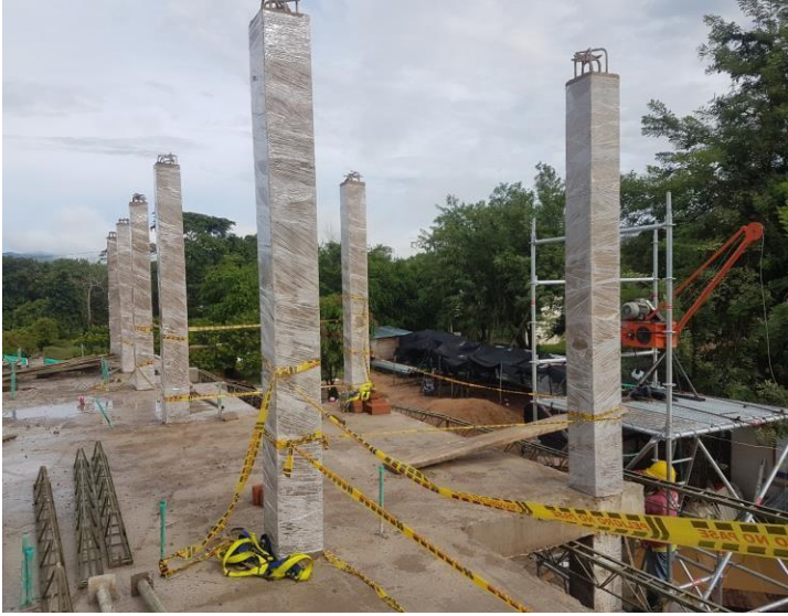
Imagen 43. Columnas de placa entrepiso Fuente: Autor
