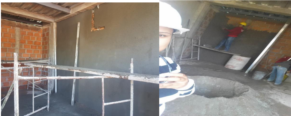
Imagen 54. Pañete en muros del primer nivel
