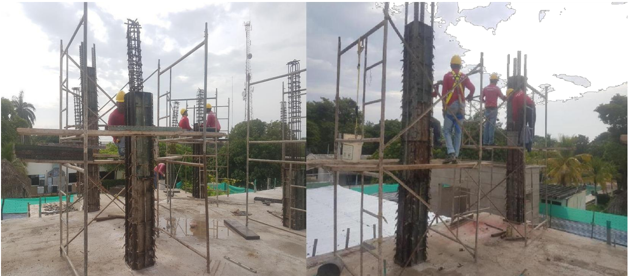
Imagen 42. Encofrado de columnas del segundo nivel Fuente: Autor
