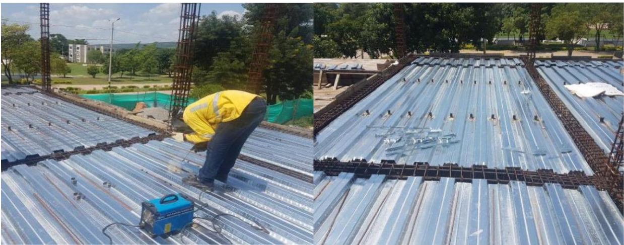
Imagen 40. Soldadura de conectores y refuerzos en placa entrepiso
