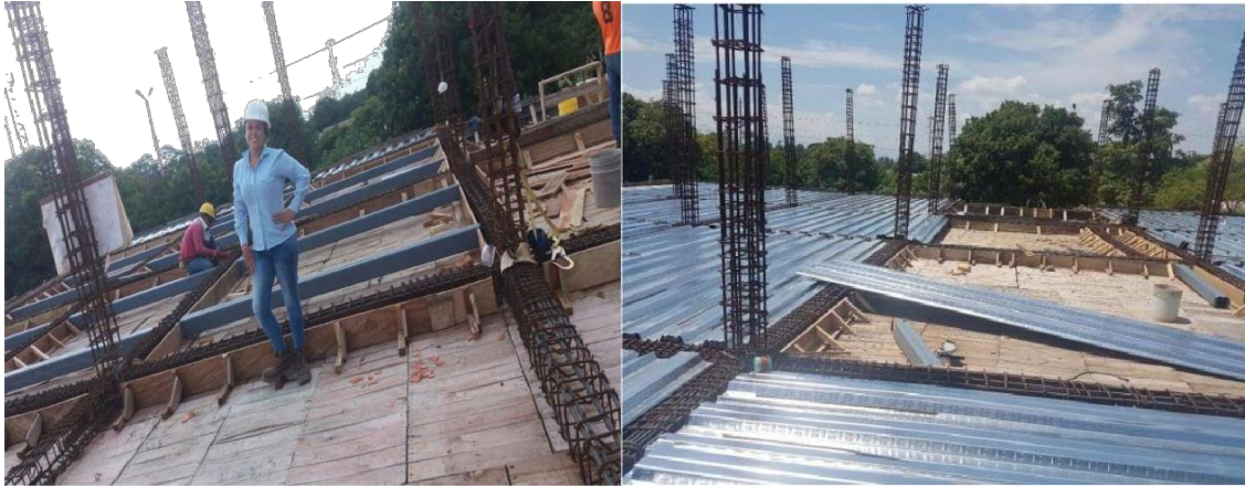
Imagen 34. Instalación de perlines y steel deck en placa entrepiso Fuente: Autor
