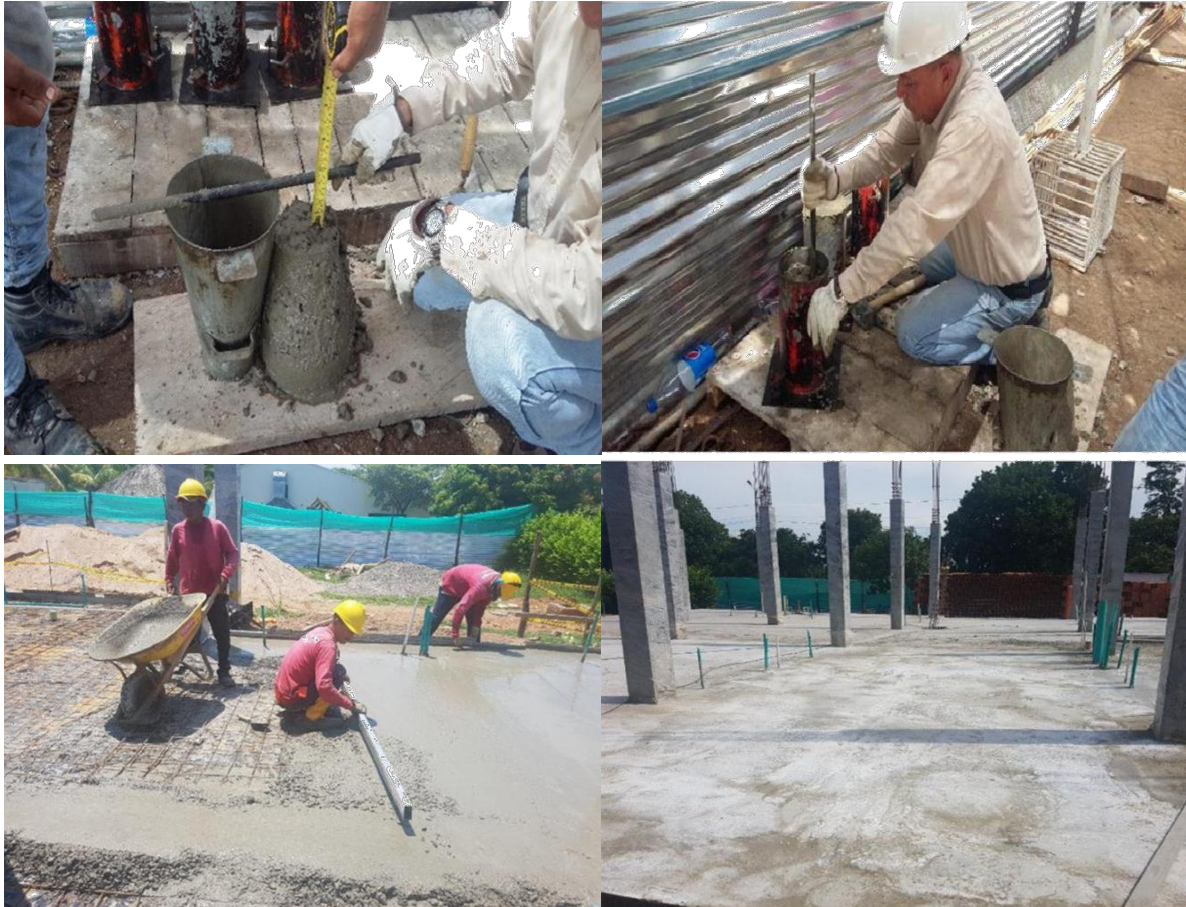
Imagen 23. Ensayo de asentamiento y testigos para laboratorio Fuente: Autor
