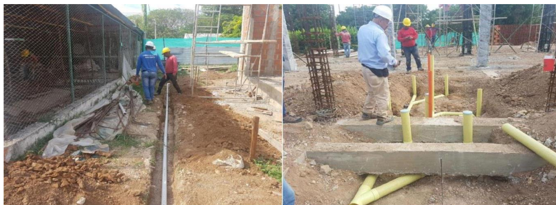
Imagen 16. Instalación de redes hidráulicas y sanitarias Fuente: Autor
