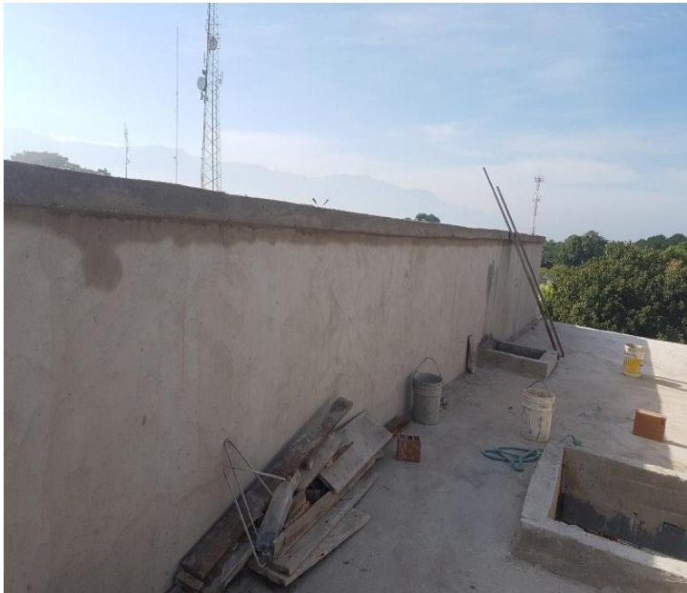
Imagen 62. Fundida de vigueta en culata de placa aérea
