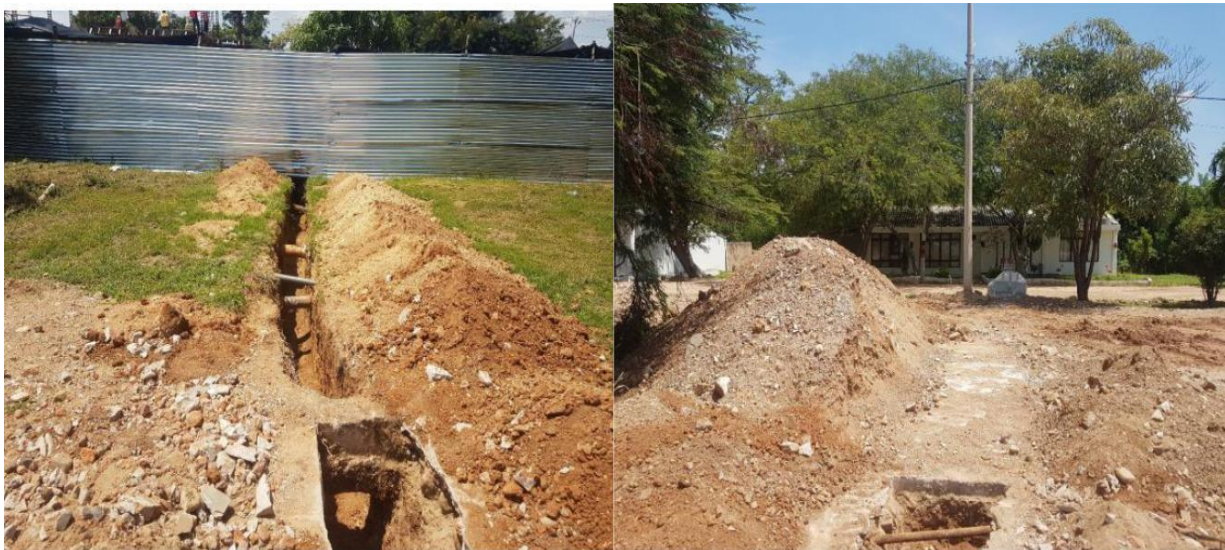
Imagen 38. Excavación para red eléctrica Fuente: Autor
