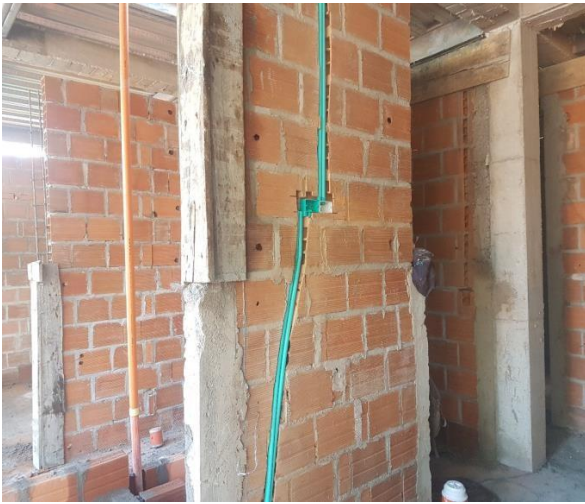
Imagen 58. Instalación de puntos eléctricos en alcobas Fuente: Autor
