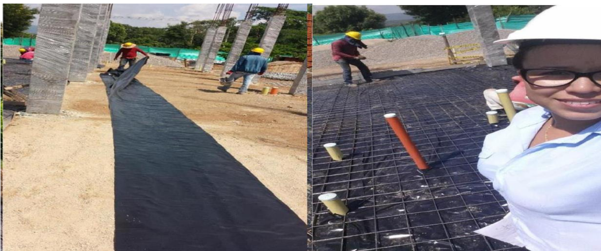
Imagen 21. Instalación de polietileno y malla electrosoldada en placa del primer nivel
