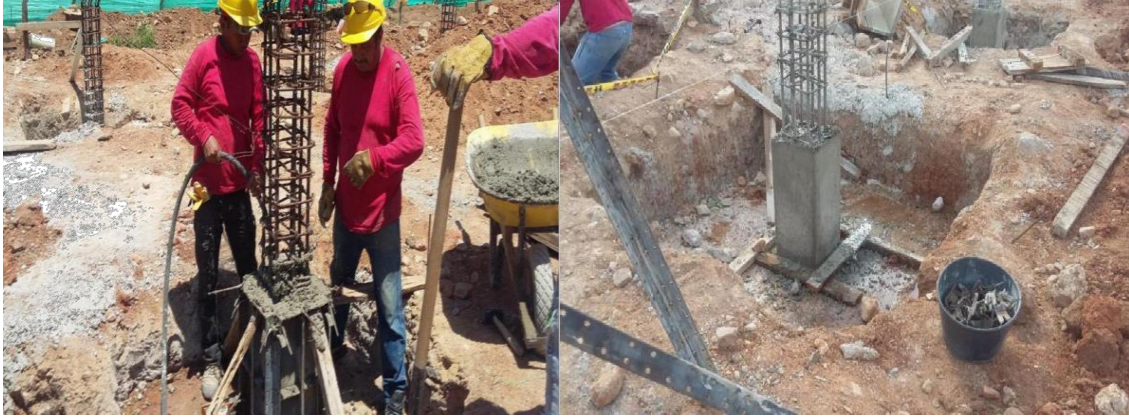
Imagen 7 Fundida de pedestales Fuente: Autor
