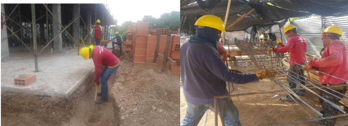
Imagen 30. Amarre e instalación de vigas de entrepiso Fuente: Autor
