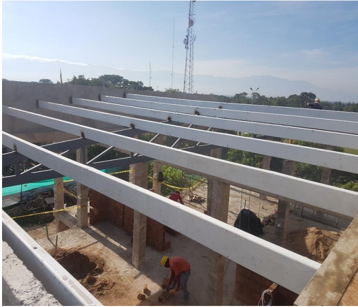
Imagen 63. Instalación de correas para cubierta
