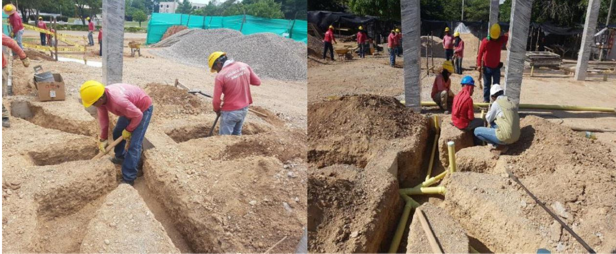
Imagen 18. Excavación e instalación de red hidráulica y sanitaria en lavanderías Fuente: Autor
