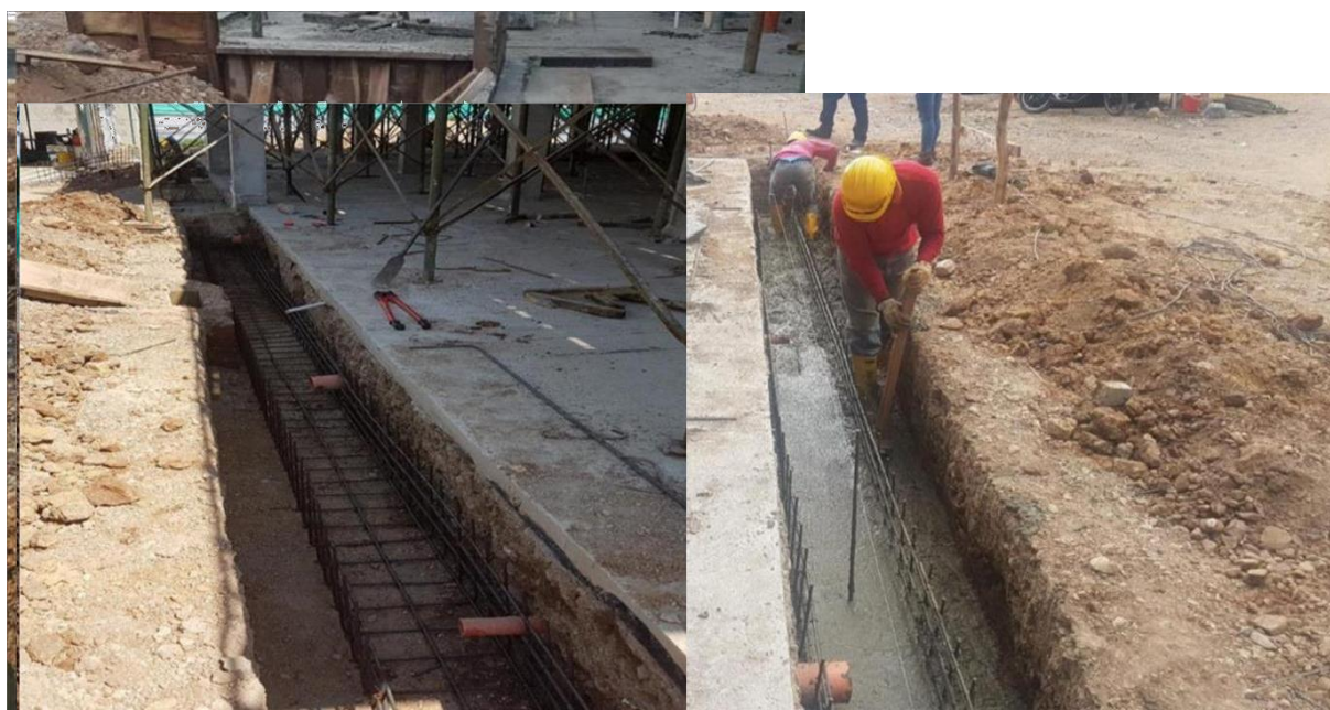
Imagen 32. Instalación y fundida de paredes laterales del cárcamo
