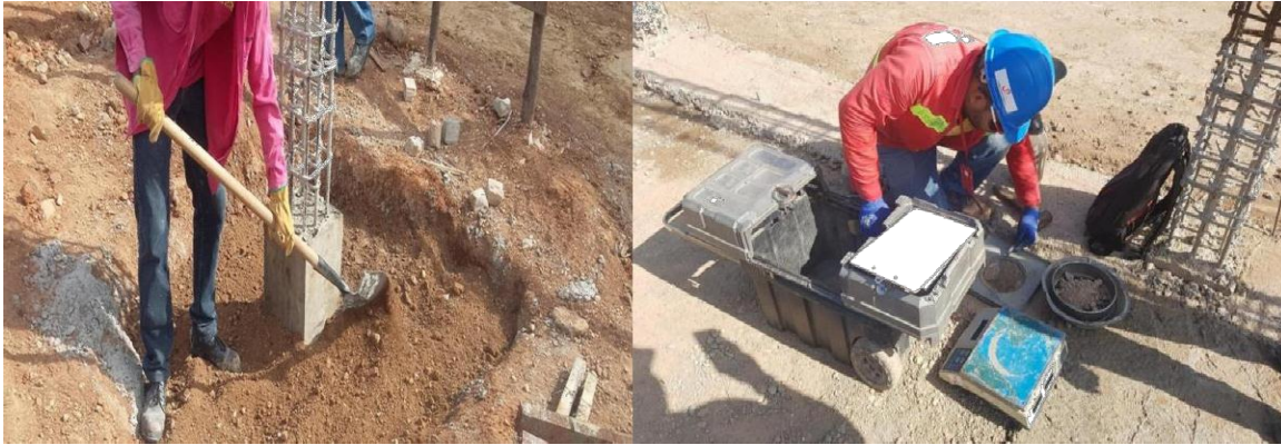
Imagen 8 Relleno con sub-base y ensayo de densidad Fuente: Autor
