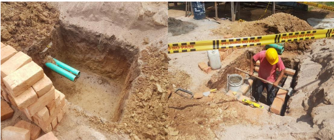
Imagen 59. Mampostería en caja #1 para acometida eléctrica Fuente: Autor
