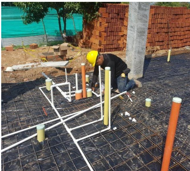
Imagen 22. Instalación de red hidráulica en baños del primer nivel
