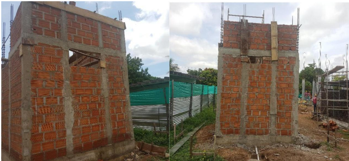
Imagen 66. Fundida de viga cinta Fuente: Autor
