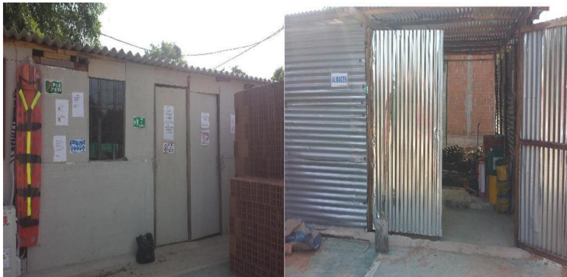
Imagen 6 Campamentos de interventoría y contratista; almacén. Fuente: Autor
