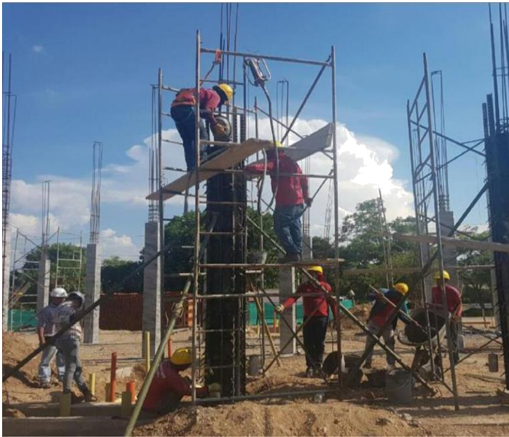
Imagen 15. Fundida de columnas en primer nivel Fuente: Autor
