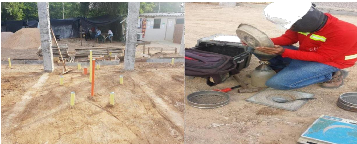
Imagen 19. Relleno y compactación con sub-base granular Fuente: Autor
