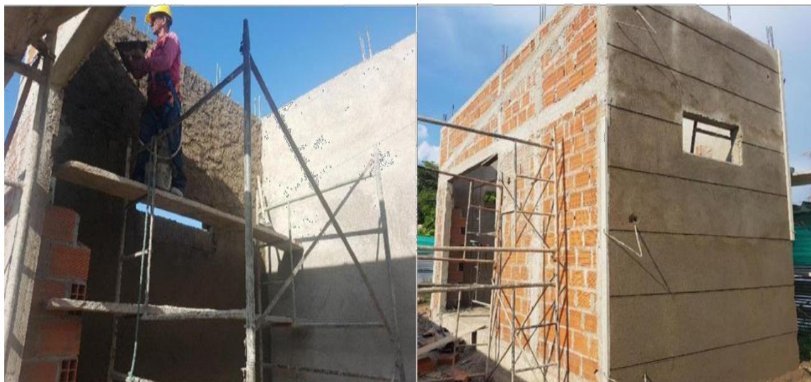
Imagen 67. Pañete en muros de cuarto de bombas
