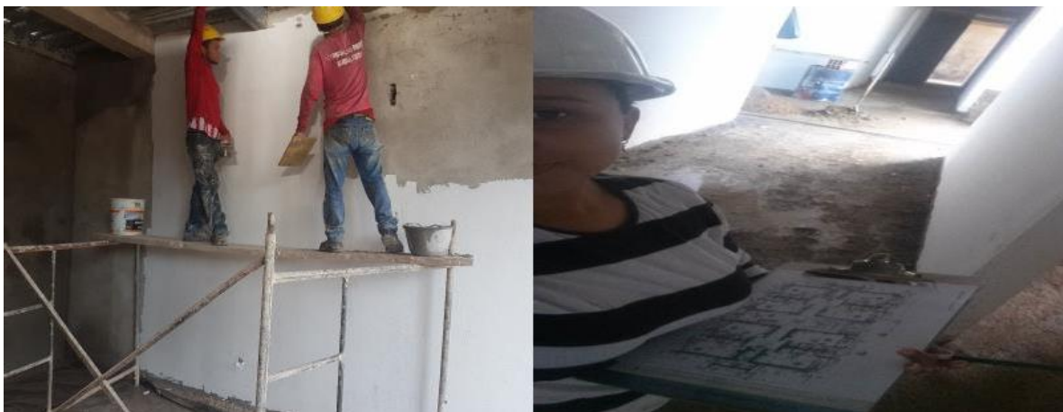
Imagen 55. Estuco en muros del primer nivel
