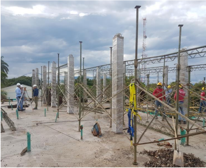
Imagen 45. Instalación de cerchas para placa aérea Fuente: Autor
