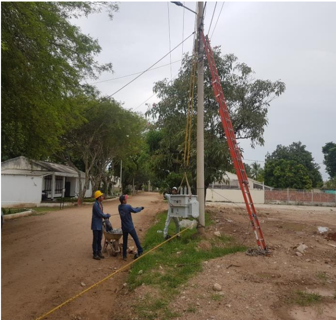
Imagen 44. Instalación de cerchas para placa aérea Fuente: Autor
