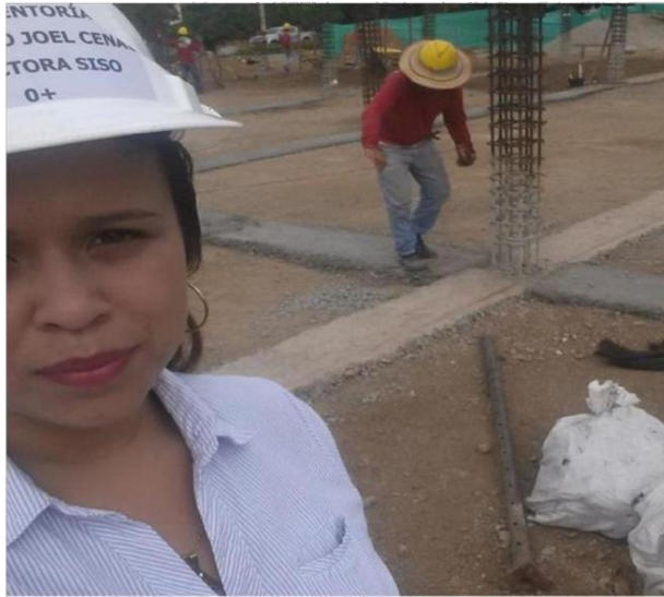
Imagen 10. Concreto de limpieza
