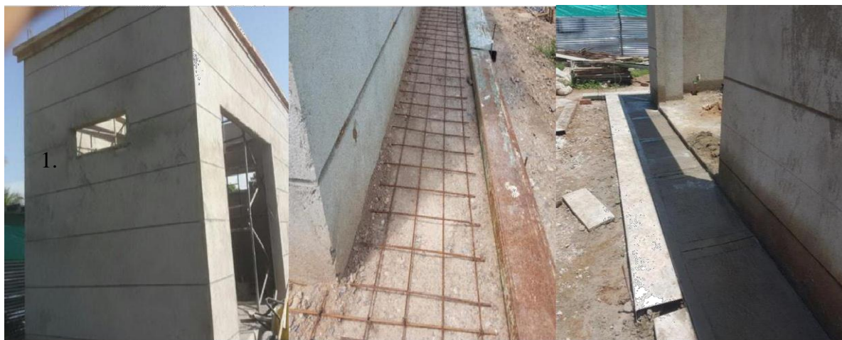
Imagen 68. Andén perimetral del cuarto de bombas
