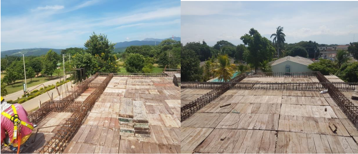
Imagen 47. Amarre e instalación de vigas aéreas Fuente: Autor
