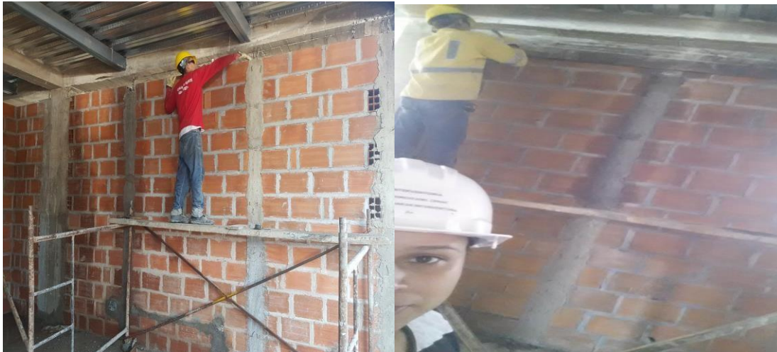
Imagen 50. Instalación y fundida de viguetas en primer nivel Fuente: Autor
