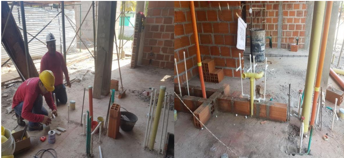
Imagen 51. Instalación de tubería hidráulica y sanitaria en baños del primer nivel
