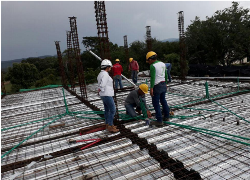
Imagen 37. Instalación de red eléctrica en la placa entrepiso Fuente: Autor
