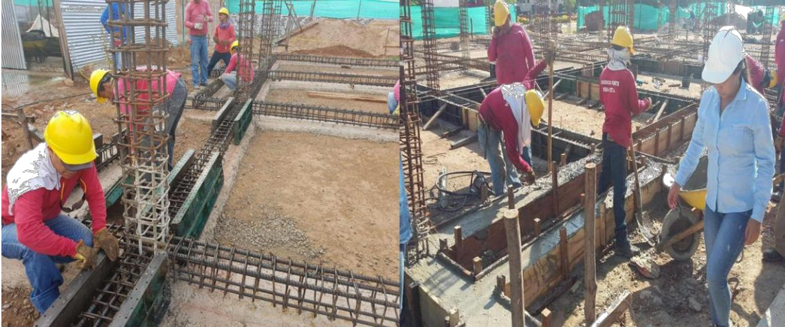
Imagen 12. Encofre y fundida de vigas de cimentación Fuente: Autor
