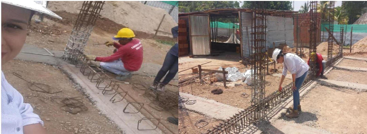
Imagen 11. Instalación y amarre de vigas de cimentación
