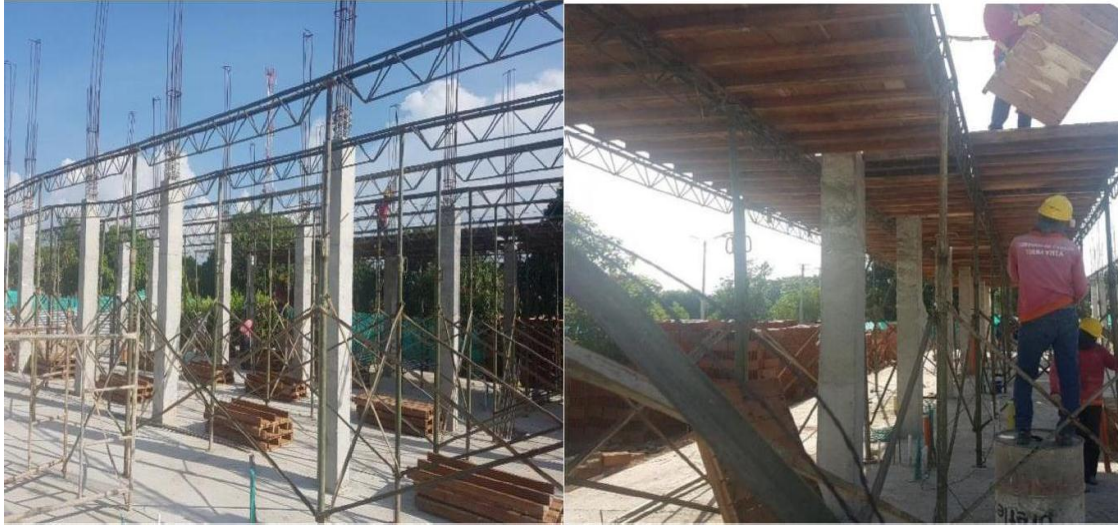
Imagen 27. Formaleta para placa entrepiso Fuente: Autor
