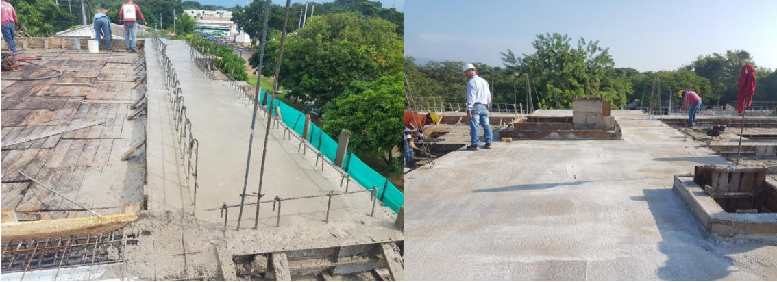
Imagen 53. Vigas y placa aérea
