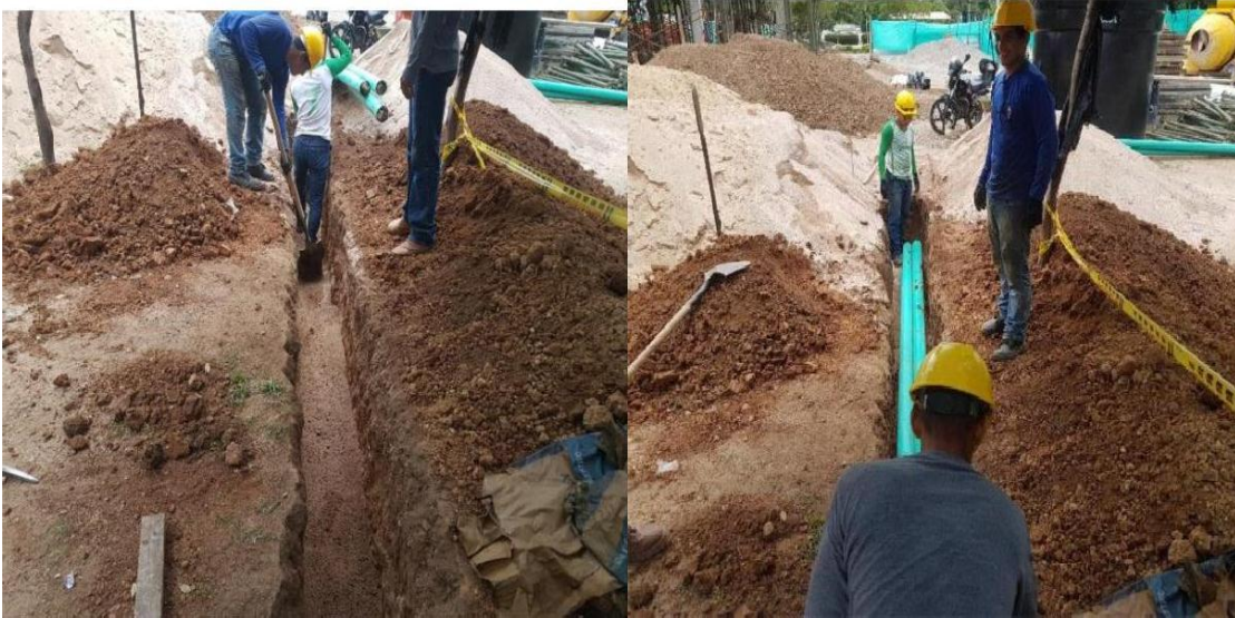
Imagen 39. Instalación de tubería para red eléctrica
