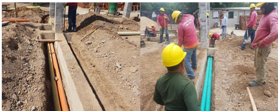
Imagen 17. Instalación de redes para aguas lluvias, ventilación y eléctrica Fuente: Autor
