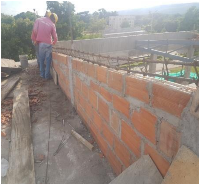
Imagen 57. Instalación de vigueta en culata de la placa aérea
