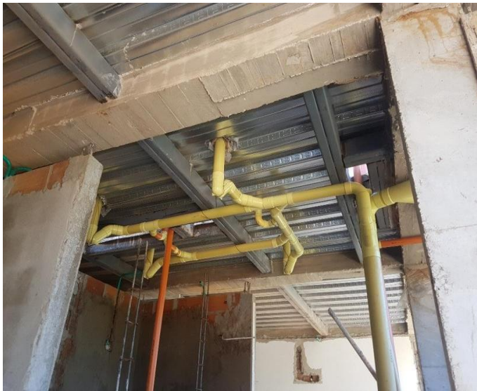
Imagen 64. Instalación de redes hidráulicas y sanitarias en baños para segundo nivel
