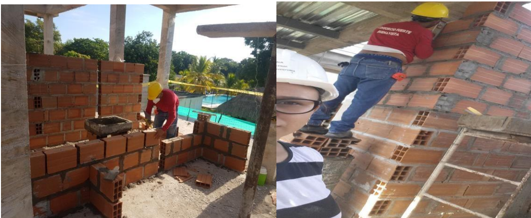
Imagen 60. Mampostería en segundo nivel Fuente: Autor
