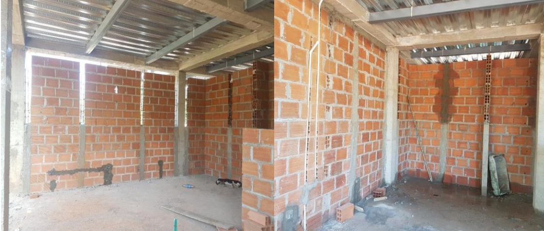
Imagen 49. Instalación y fundida de columnetas en primer nivel Fuente: Autor
