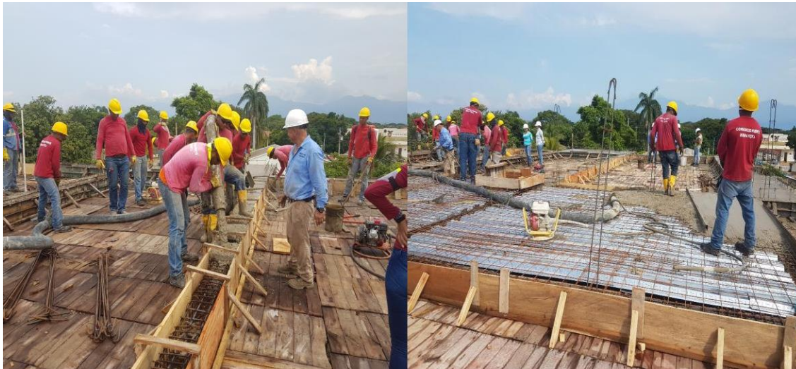
Imagen 52. Fundida de vigas y placa aérea
