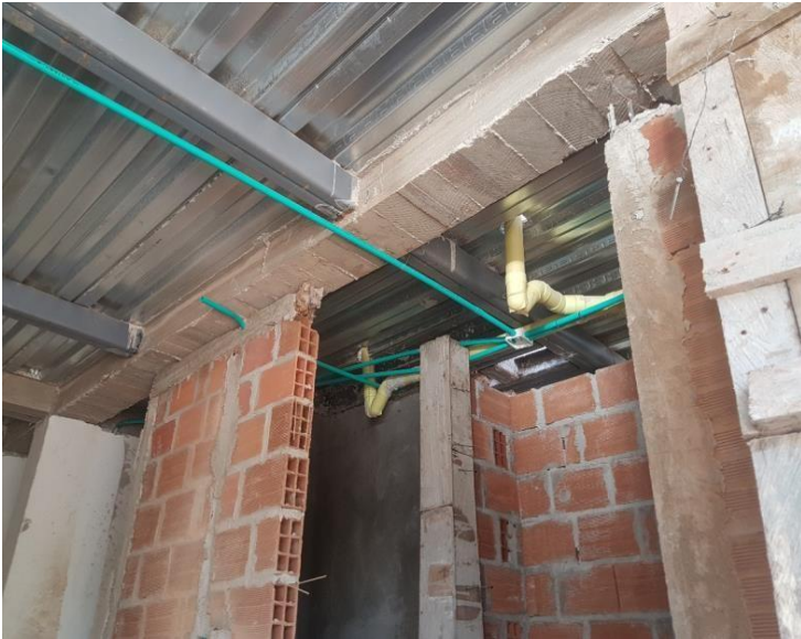
Imagen 65. Instalación de red eléctrica en baños del primer nivel Fuente: Autor
