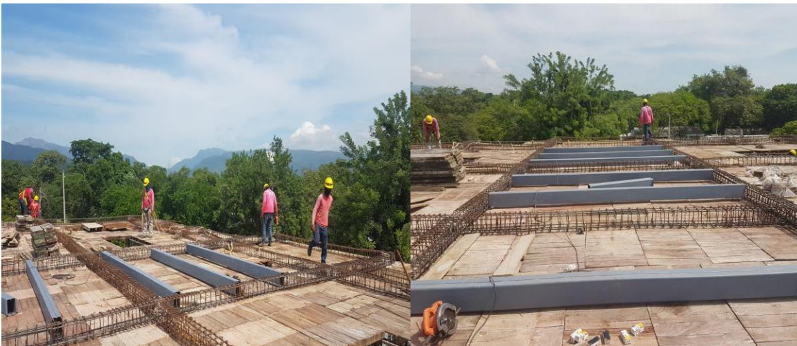
Imagen 48. Instalación de perlines en placa aérea Fuente: Autor
