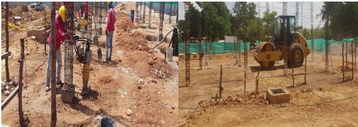
Imagen 9 Compactación manual y mecánica de sub-base Fuente: Autor
