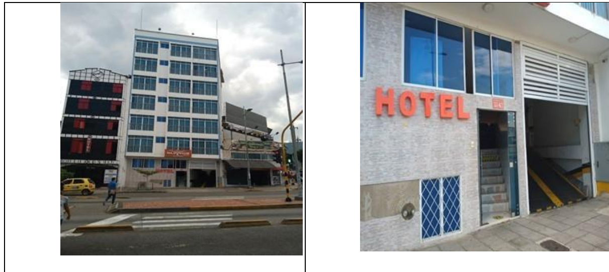
Desde su frente la presentación de la Fachada y estructura del Hotel Isla Mayor Un Sueño Real Bucaramanga
