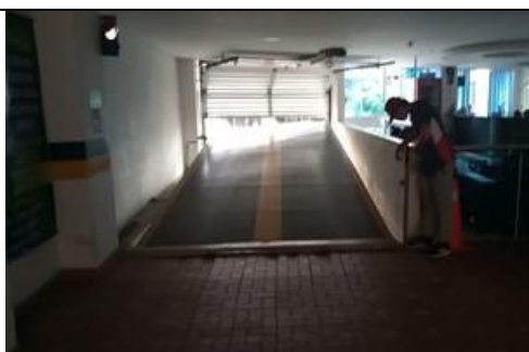
Vista de adentro hacia la rampa de Parqueadero que queda en el primer piso del Hotel junto a la Sala de Espera y Recepción
