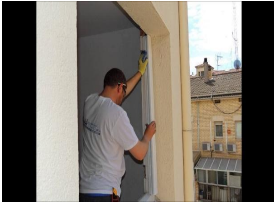
Ilustración N° 1: Instalación de puertas y ventanas.
