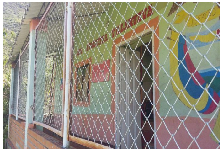
Sede Villanueva, entrada principal.
