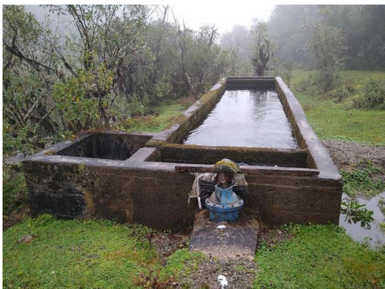
Anexo 3. Tanque desarenador del distrito de riego a pequeña escala
