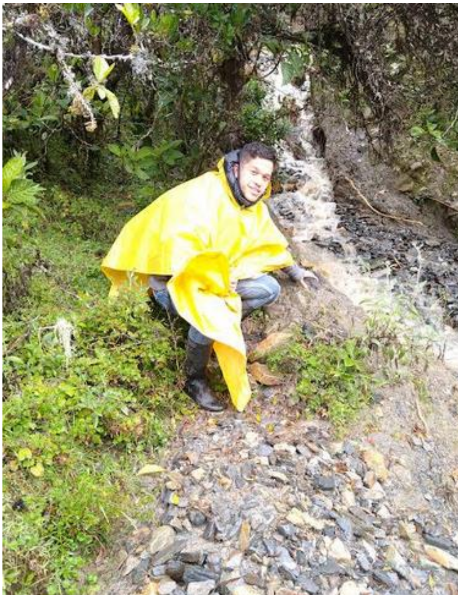
Anexo 37. Deslizamiento de tierra sobre la tubería principal
