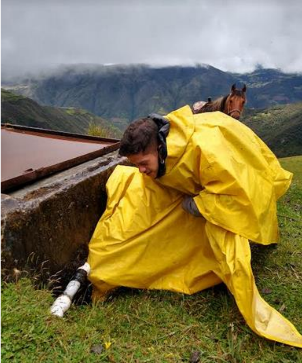
Anexo 36. Revisión del estado de las tuberías
