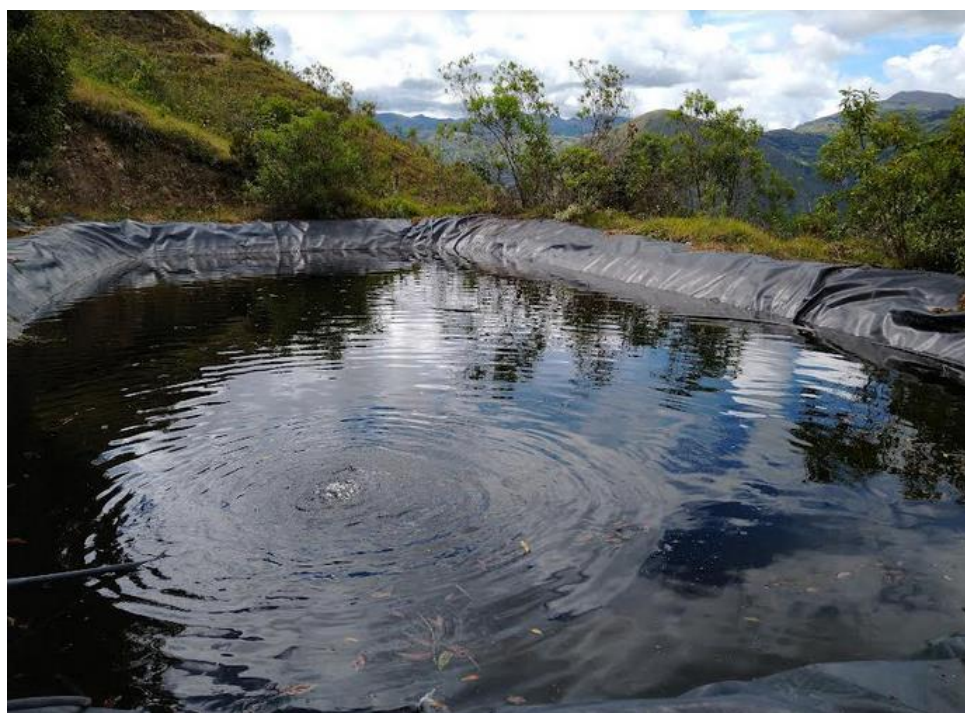
Anexo 17. Estado actual de reservorio 1
