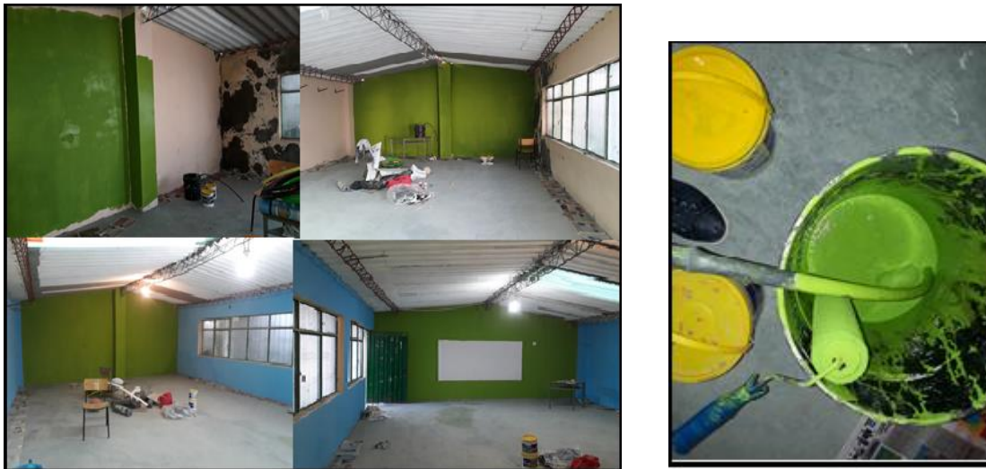
Ilustración 12: aplicación de pintura. (elaboración propia).
