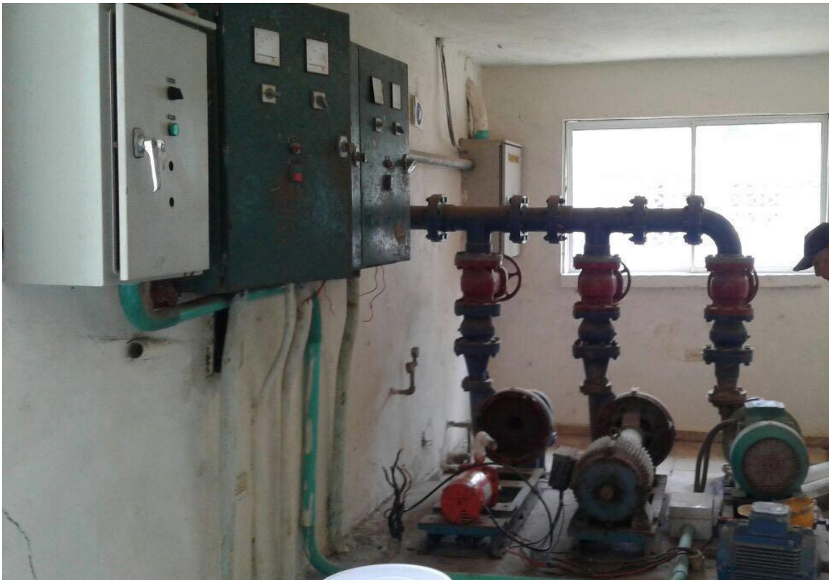
Fig.10 Instalación de motobombas y cuarto de control
