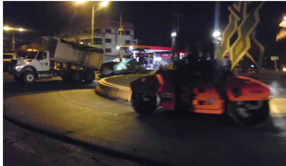
Figura 19: acabado del compactador
