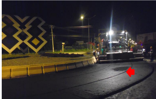
Figura 17: asfalto de la pavimentadora vogelee
