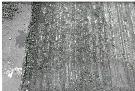
Figura 18: trabajo realizado por la fresadora
