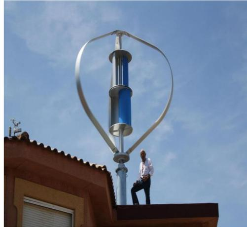
**Figura 5: Aerogenerador Darrieus**
