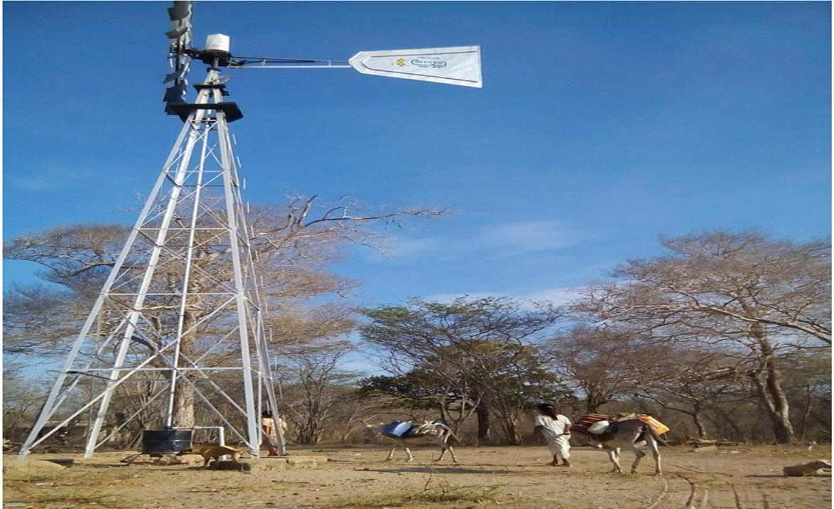
Figura 20: Entrada a la Comunidad y molino de viento para el bombeo de agua
