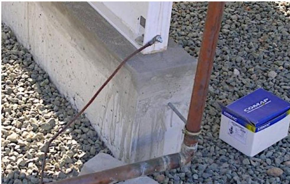
Ilustración 14. BORNE DE PUESTA A TIERRA DE INSTALACIÓN DE GAS. Fuente. [Fenpa.es/rebt/gas/pto3.htm](http://Fenpa.es/rebt/gas/pto3.htm)
