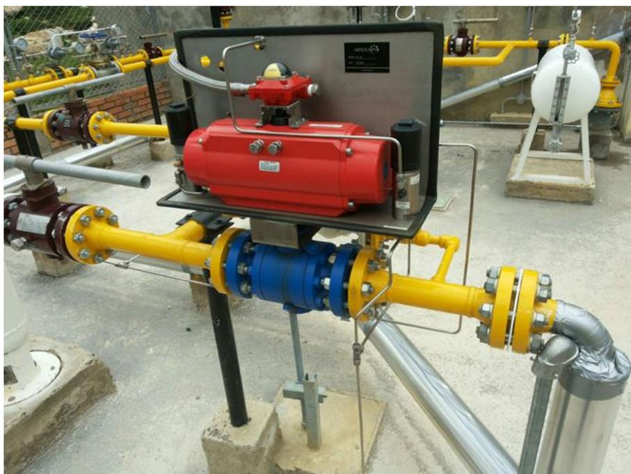
Ilustración 4. VÁLVULA DE CORTE PLANTA GASES DEL ORIENTE (Pamplona, Norte de Santander).
