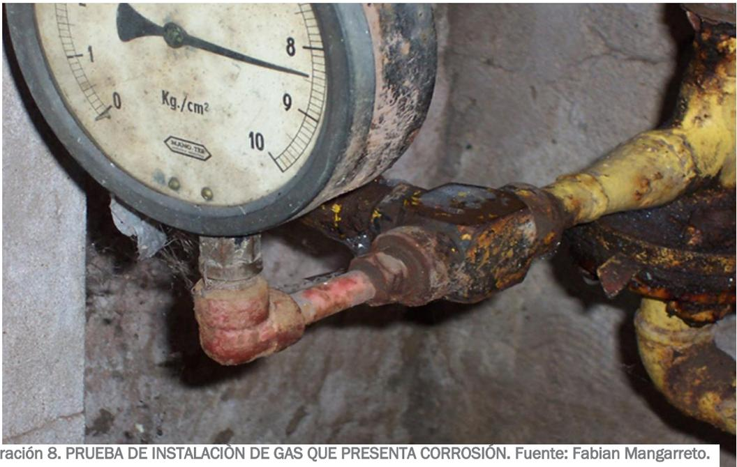
Ilustración 8. PRUEBA DE INSTALACIÓN DE GAS QUE PRESENTA CORROSIÓN. Fuente: Fabian Mangarreto.
