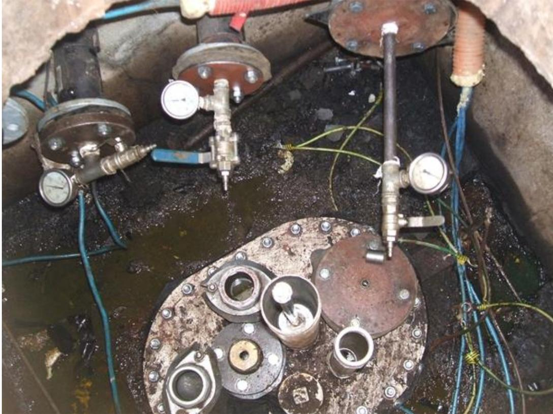
Ilustración 7. PRUEBA DE HERMETICIDAD. Revesgal - España
