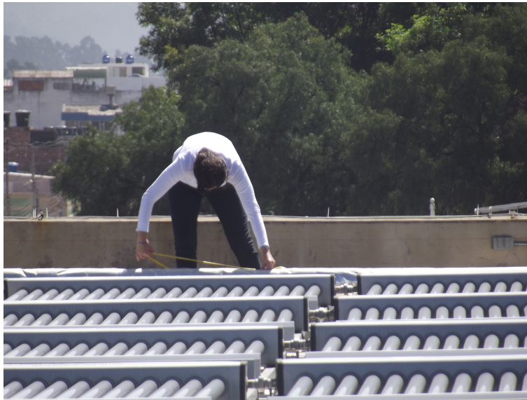
Figura 3-12: Medición longitud de tuberías en el techo del Centro Urbano Recreacional Infantil. Autor
