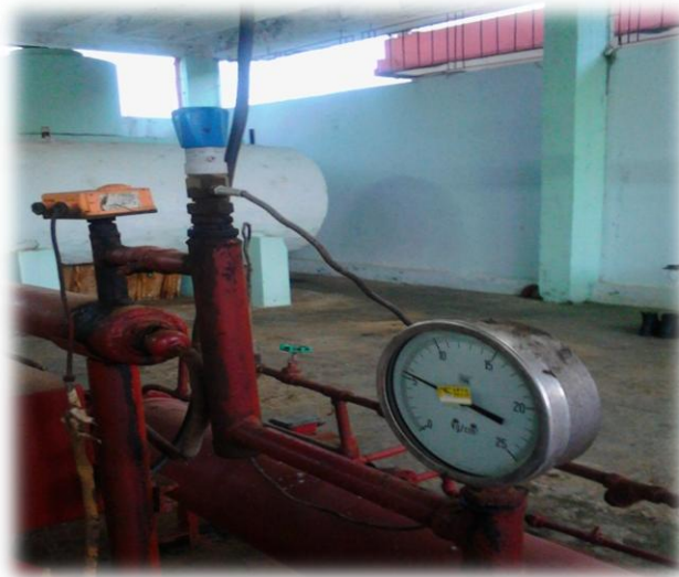
Figura 8: quemador del generador de vapor UNICA Fuente: (Guillermo Cordero)
