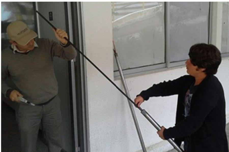
**Figura 3-7:** Introducción del tubo de cobre a la cápsula madre
