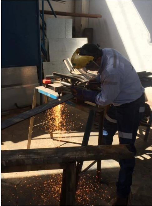
Figura 31. Proceso de corte de material con técnica oxicrote. (Autor)
