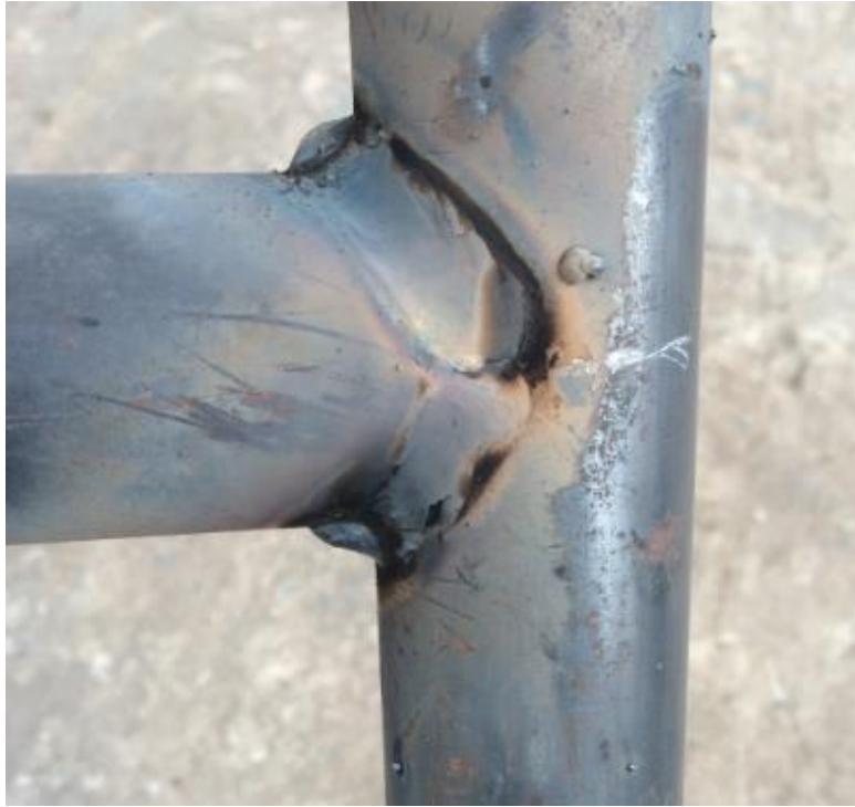
Figura 37. Corrección de serie 100 en proceso de soldadura. (Autor)
