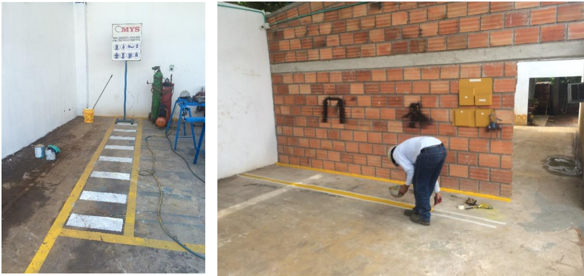
Figura 29. Demarcación de zona de trabajo. (Autor)
