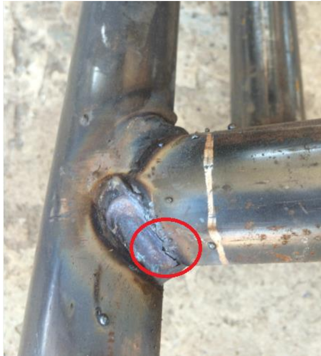
Figura 33. Fracturas en soldadura serie 100. (Autor)
