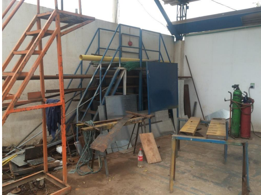
Figura 27. Fotografía del estado en el que se encontró el taller de M. Y. S. (Autor)
