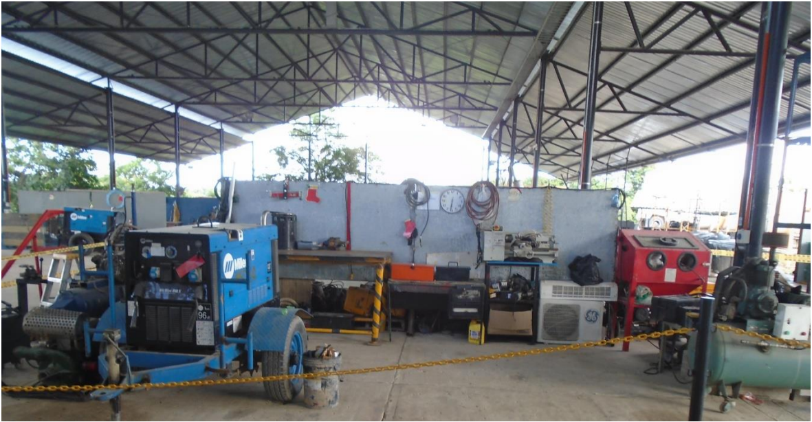
Figura 16. Área de mantenimiento eléctrico. Fuente propia
