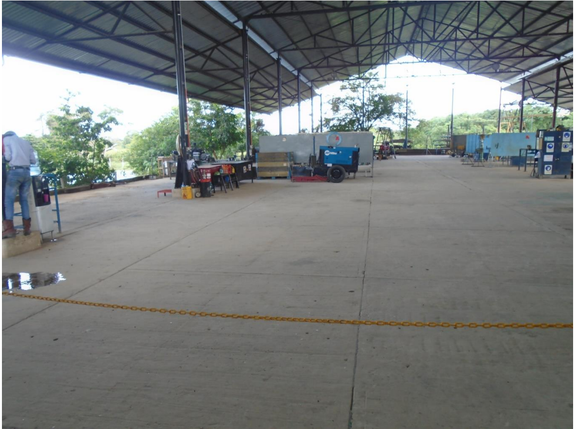
Figura 17. Área de mantenimiento automotriz
