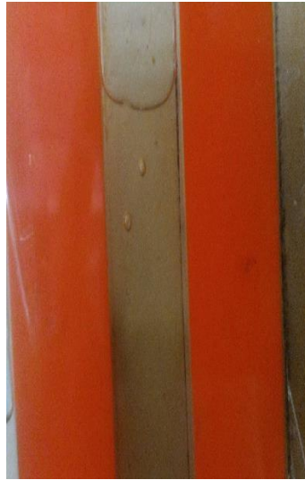
Figura 24. Discontinuidades en la fabricación
