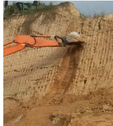
C. Muestreo tipo canal con la ayuda de la retroexcavadora.
