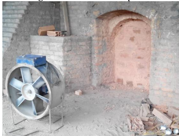
Figura 44. Sellado de la puerta.
