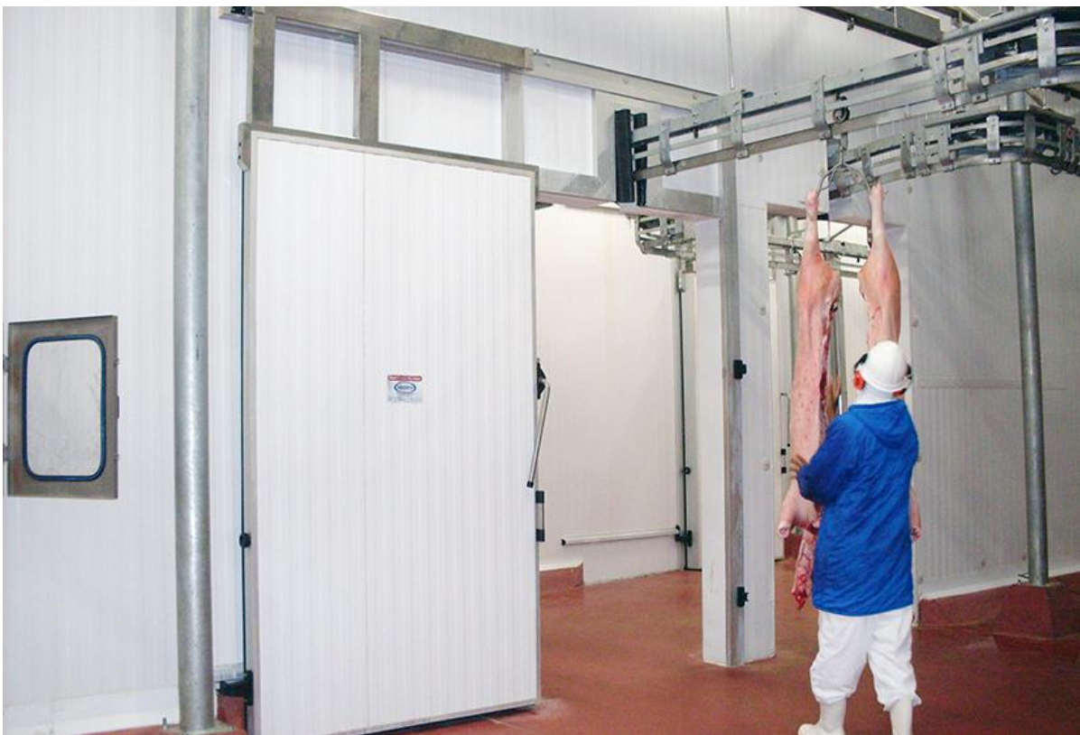
Imagen 3. Puertas corredizas con paso de riel de acero inoxidable. Autor: ISOESTE.
