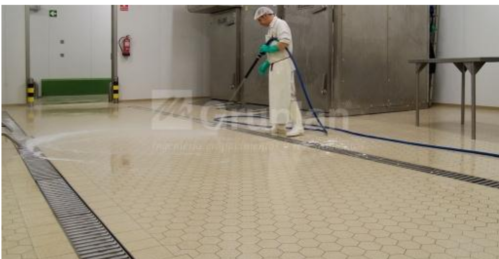
Imagen 4. Piso y paredes con cubrimiento en material sanitario. Autor: GRUPLAN
