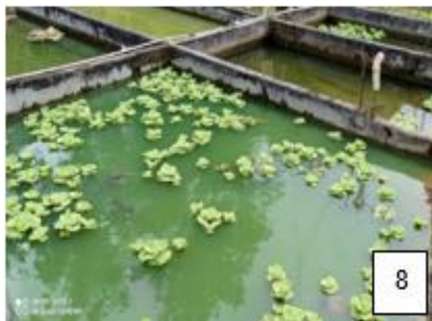
Figura 8. Estanques de Concreto. Fuente: Mosquera, (2021)
