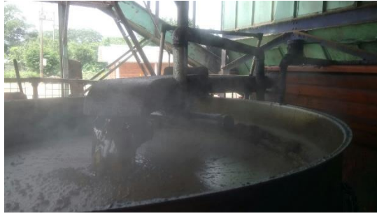
Tanque de pérdida de humedad del CPO
