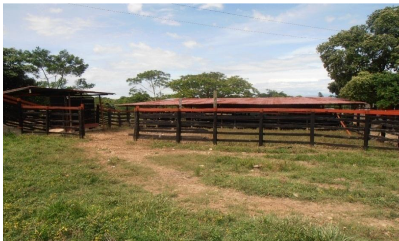
Imagen N°2. Instalaciones de manejo, corral en estructura metálica y cubierta, suelo encapotado y en piedra Propietario Sr. Silvano Becerra Becerra, Finca la Selva, Vereda La Esmeralda, Municipio de Tibù.
