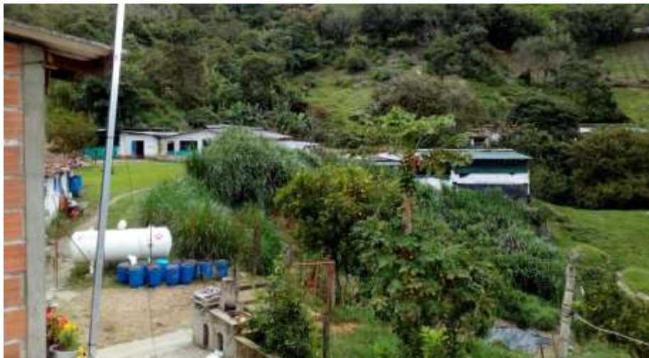
Figura 2. Galpones, oficina y casa habitación de la Granja la ESSE
