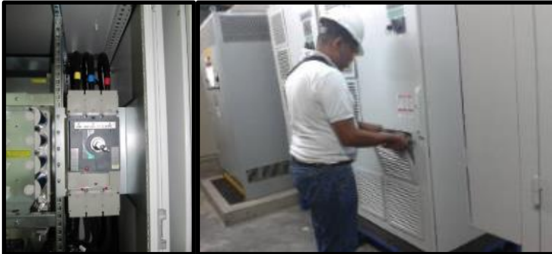
Figura 12. Filtro eliminador de armónicos ACCUSINE
