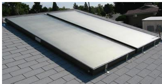
Figura1.2: Foto de un colector solar de placa plana con cubierta
