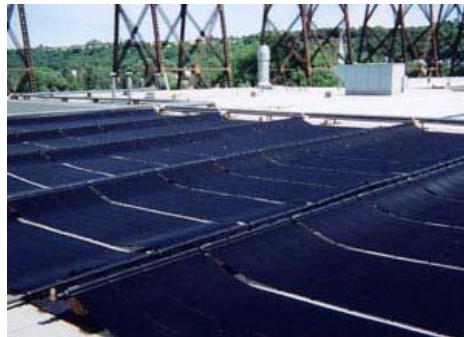
Figura 1.5: Foto de un colector de placa plana sin cubierta
