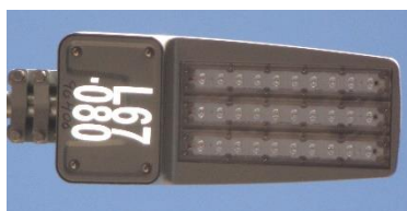
Figura 14. Luminaria Led 67 W. Tomada de: Concesión de Alumbrado Público.
