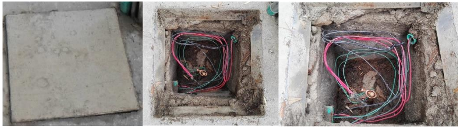
Figura 7. Puesta a Tierra. Tomada de: Concesión de Alumbrado Público.
