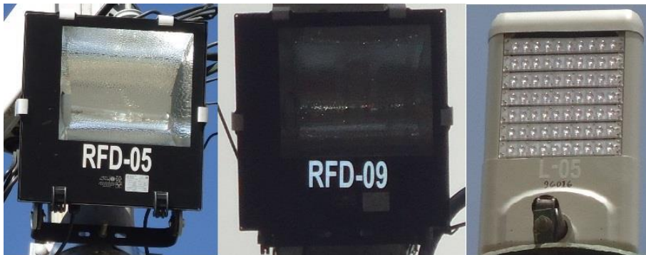
Figura 11. Reflectores Meta Halide 250, 400 W y Led 150 W. Tomada de: Concesión de Alumbrado Público.
