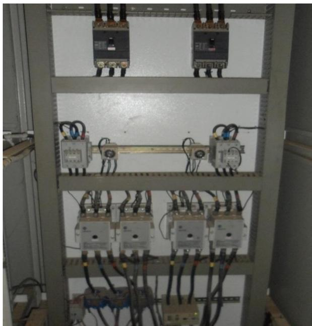
*Figura 17. Sistema de arranque existente 75CV.*
