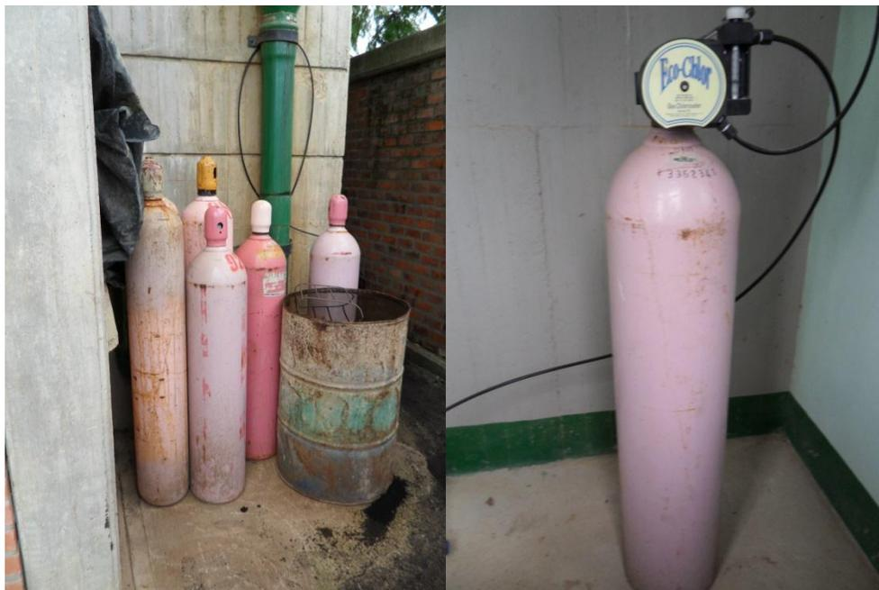
*Figura 9. Sistema de desinfección existente.*
