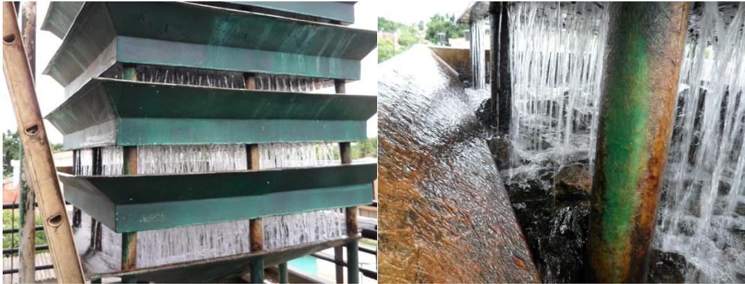
*Figura 4. Bandejas de aireación existentes.*
