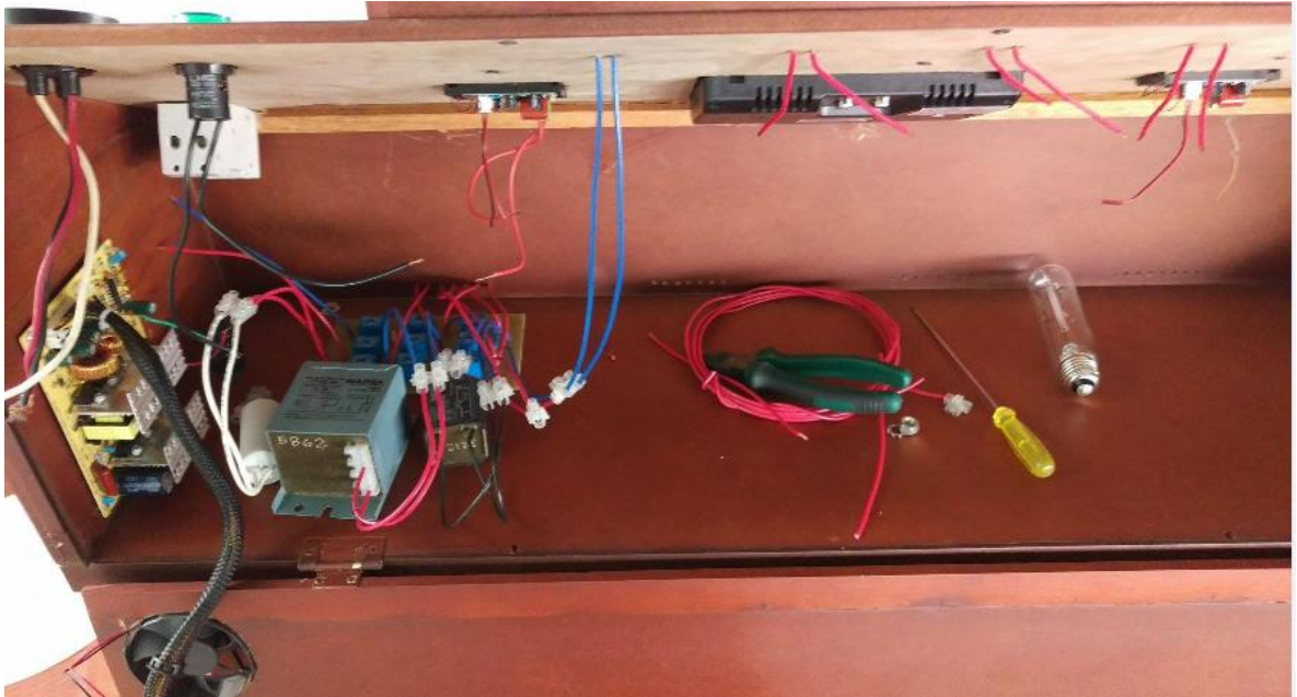
Figura 56: Instalación de fuente de poder y kit de 70W [Fuente. El autor].
