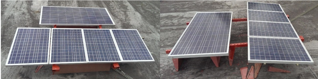
Figura 15. Montaje físico de los paneles solares.
