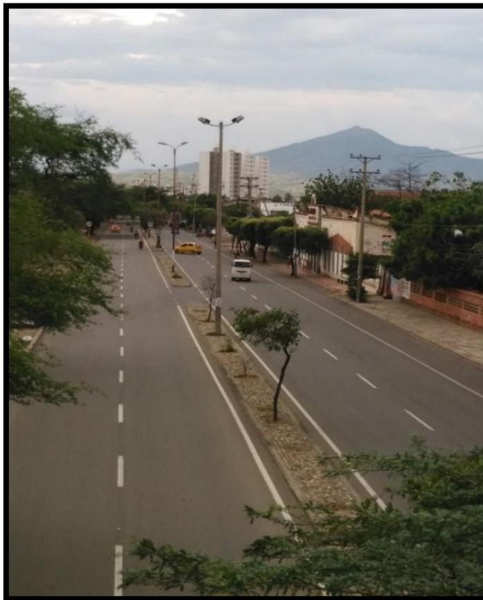
**6.4.1 Configuración de disposición de Luminarias (Altura del punto de luz (H) e Interdistancia de postes (S)).** Para la altura del punto de luz el RETILAP en la tabla 510.6 establece una altura en el rango de 10 a 12 metros para una vía de tipo de iluminación M2 y una relación S/H de 3.5 a 4. El valor que se toma para la altura del punto de Luz es de 12 metros. Por lo tanto se obtiene que:
