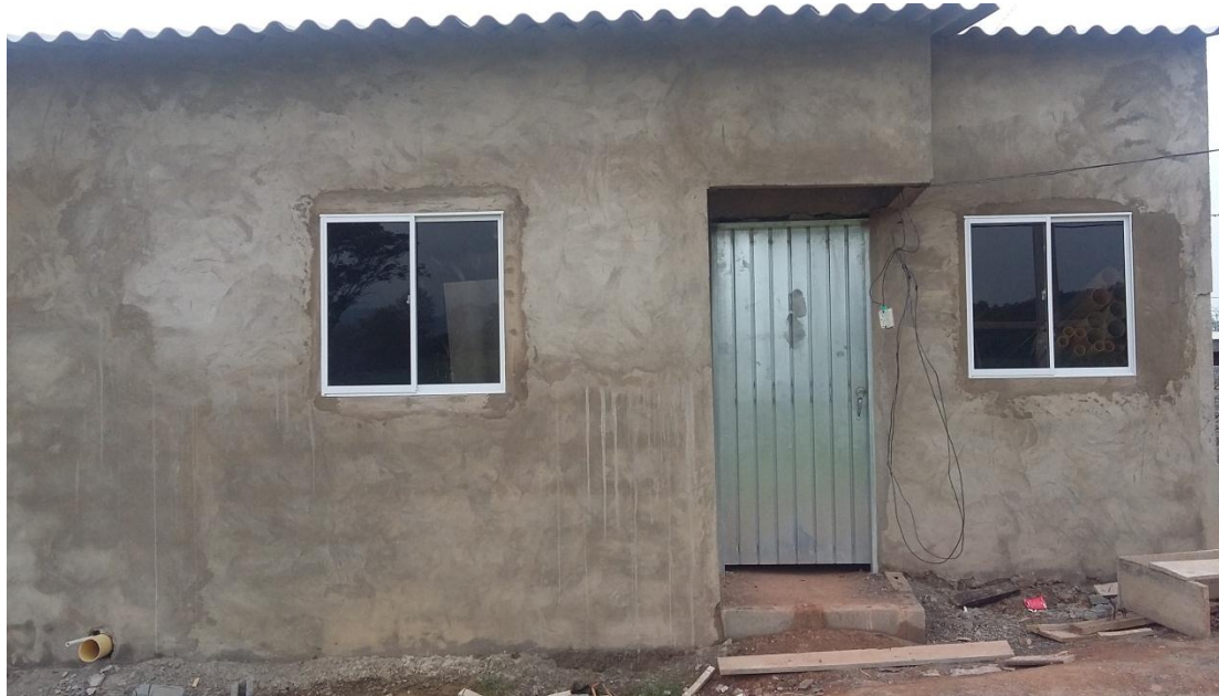
Figura 18. Instalación de puerta metálica
