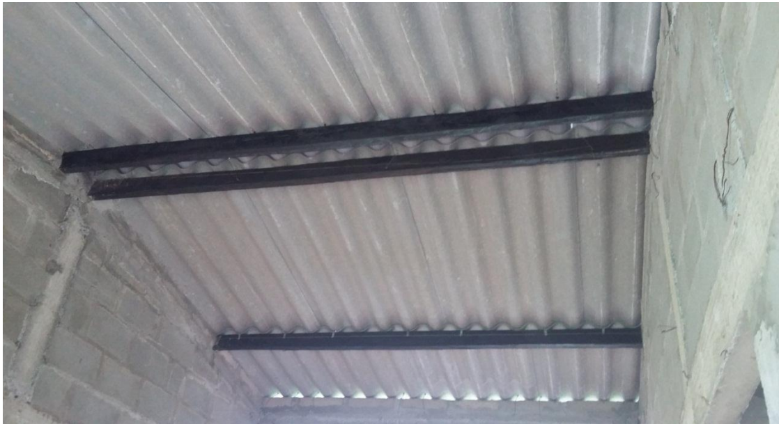
Figura 14. Viviendas a nivel de cubiertas con instalación de caballeta
