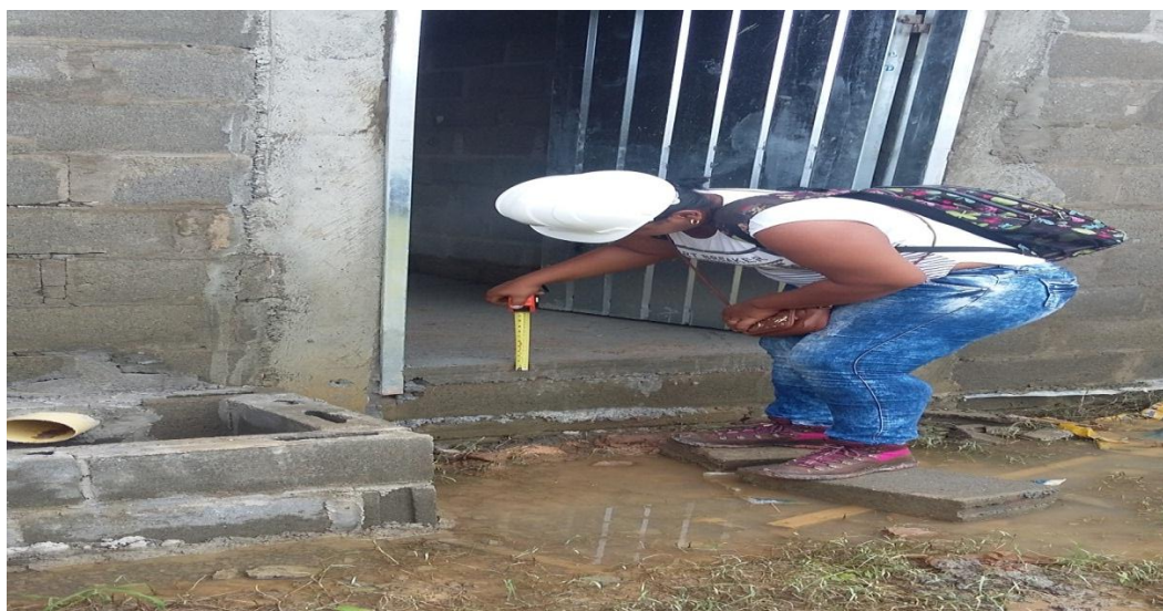
Figura 13. Verificación de espesor en plantilla E=0.05 m
