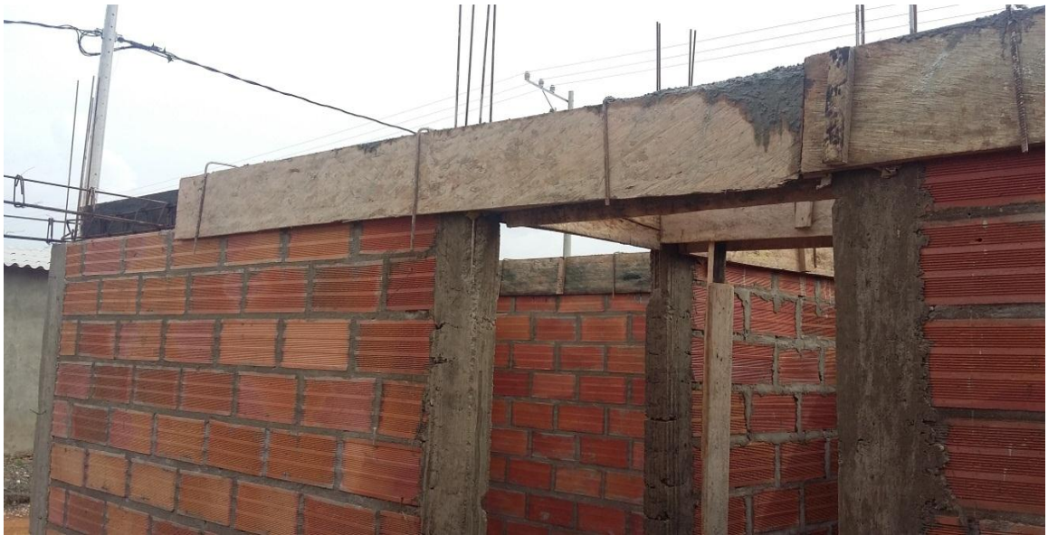
Figura 9. Encofrado de vigas
