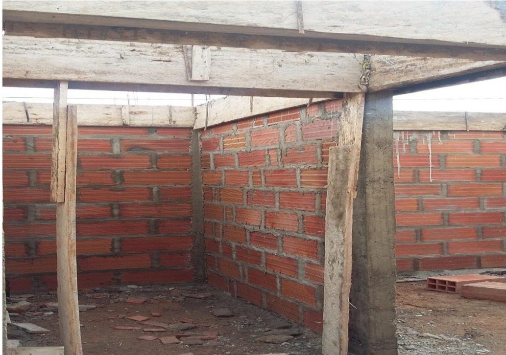
Figura 10. Encofrado de vigas en formaletas de madera
