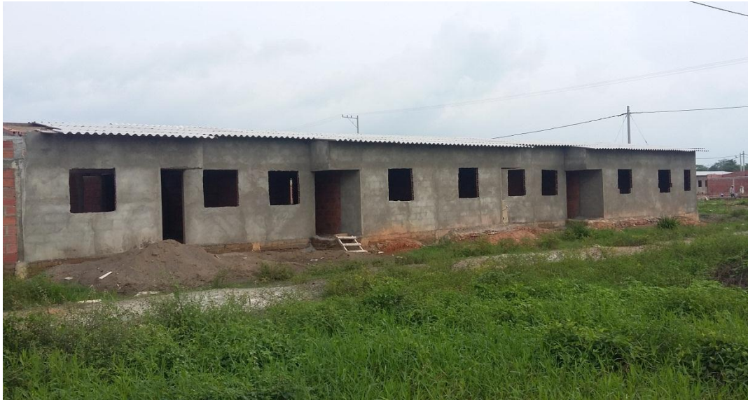
Figura 17. Vivienda s debidamente pañetadas
