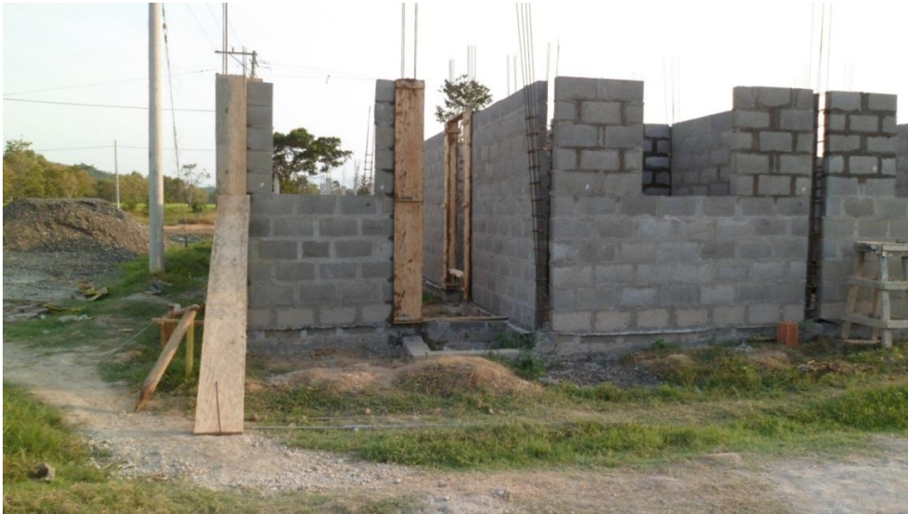
Figura 8. Encofrado de columnas
