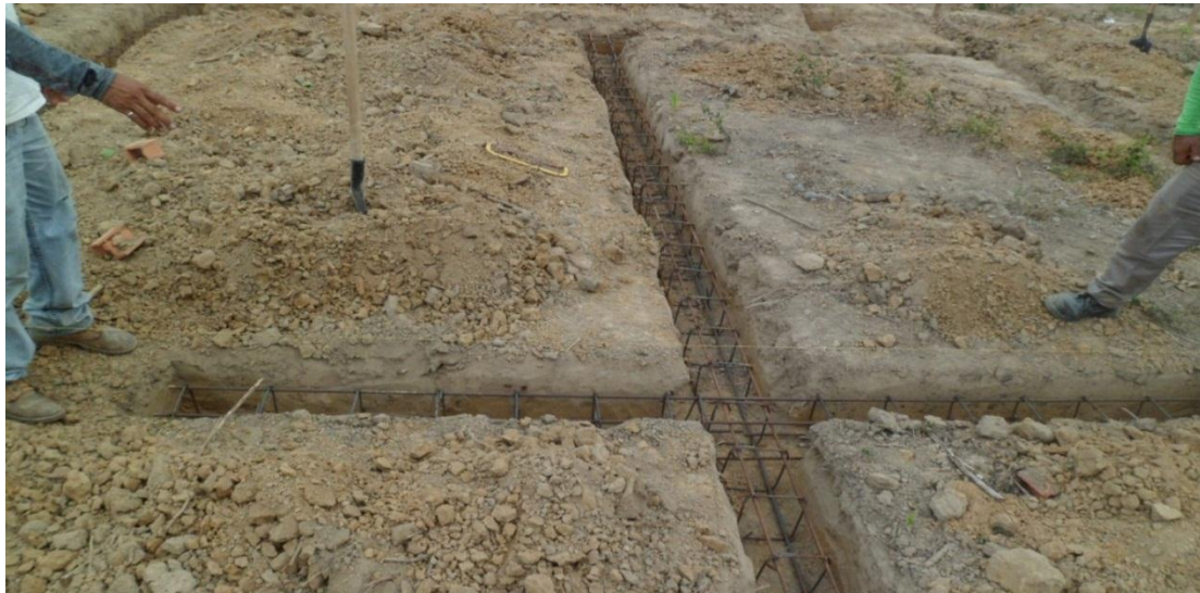
Figura 6. Instalación de canastillas de acero para vigas de cimentación
