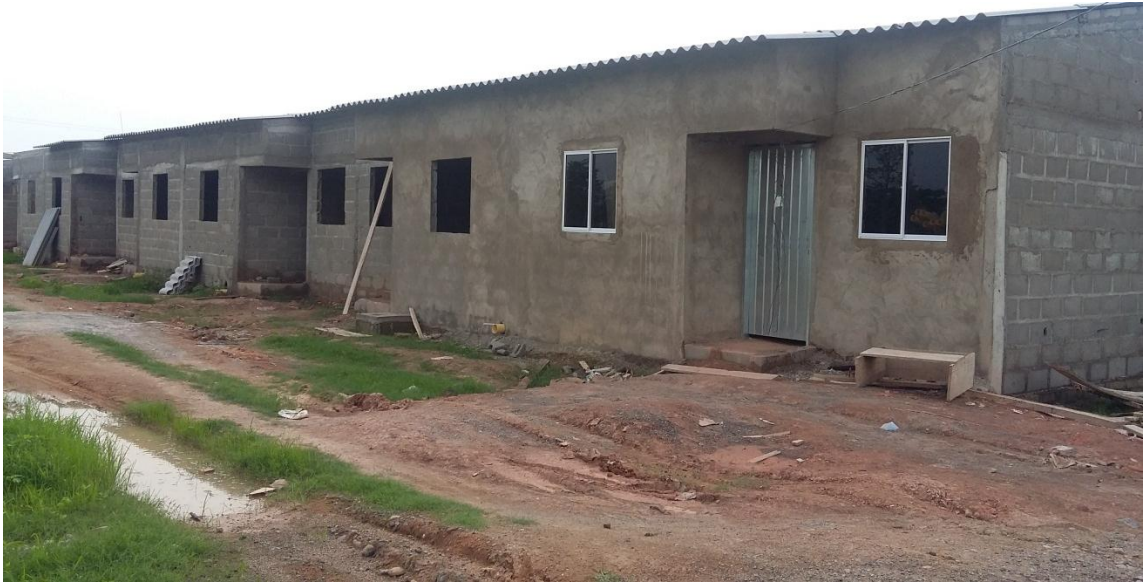
Figura 19. Instalación de ventanas
