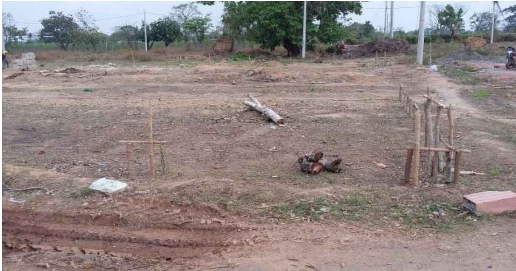
Figura 4. Colocación de estancas debidamente señaladas
