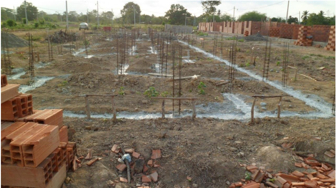
Figura 7. Vigas de cimentación debidamente fundidas
