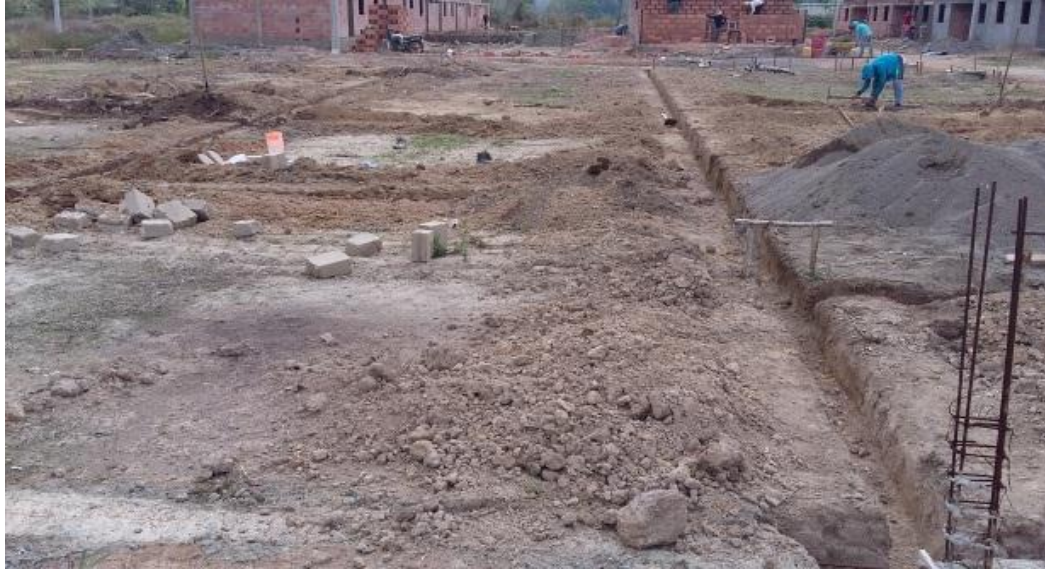
Figura 5. Excavaciones para viga de cimentación
