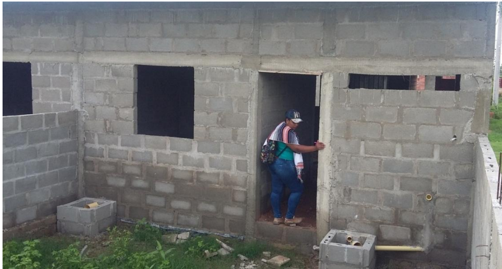
Figura 16. Registro de aguas lluvias y sanitario
