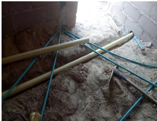
Figura 20. Acometidas eléctricas
