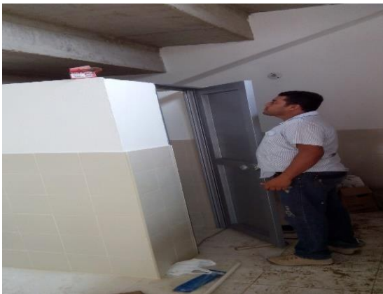
Figura 27. Inspección de puertas
