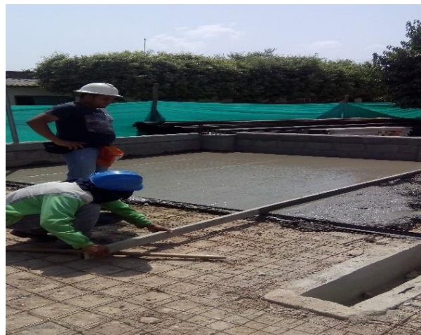
Figura 35. Vaciado de loza de cancha
