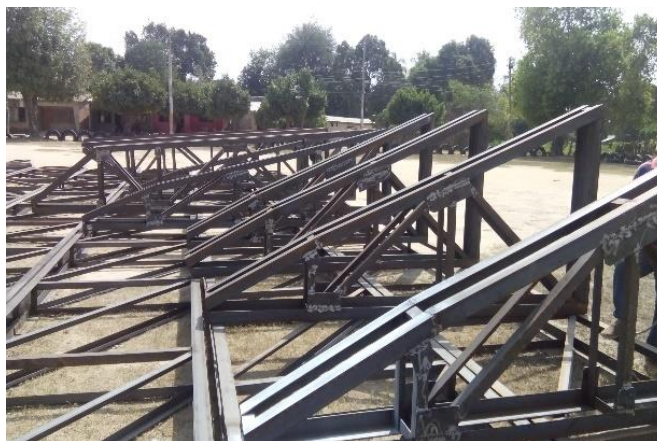
Figura 36. Estructura de cubierta
