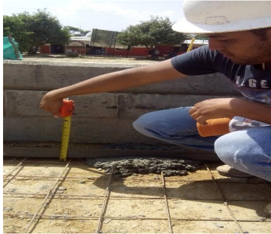
Figura 34. Inspección de espesor
