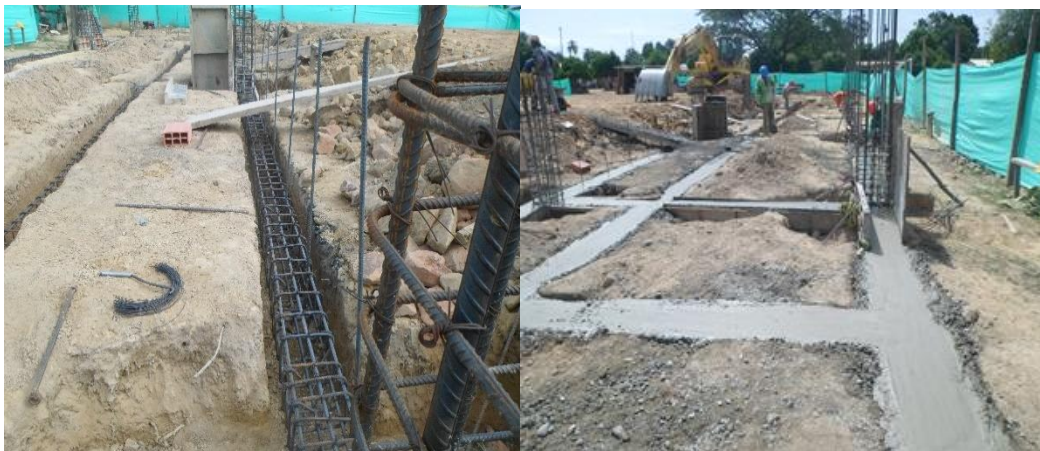
Figura 8. Vigas de cimentación
