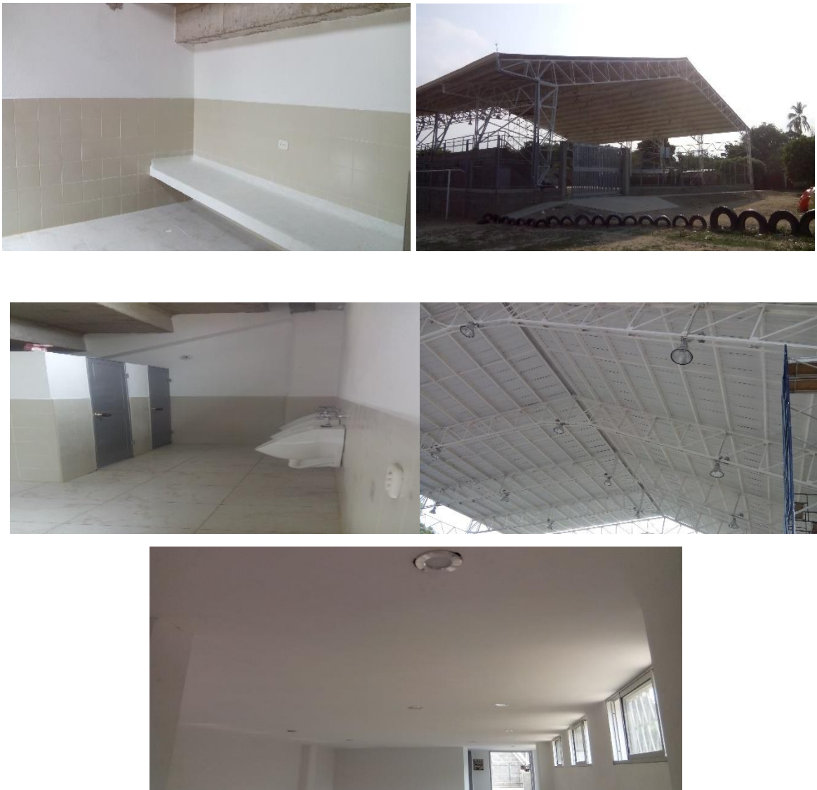
Figura 47. Acabados finales de obra
