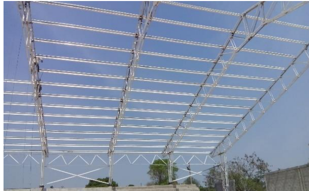
Figura 37. Instalación de estructura
