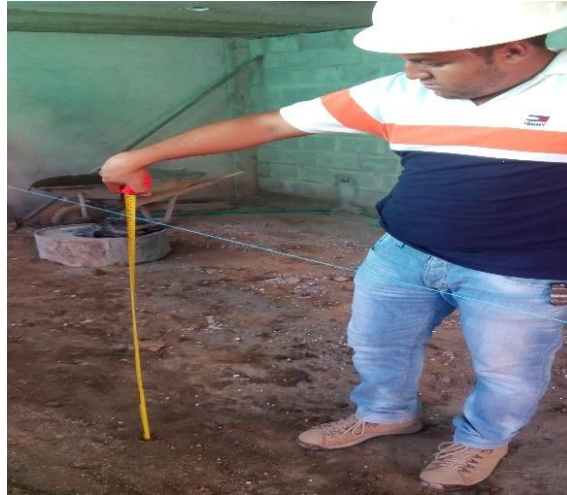
Figura 32. Inspección de niveles
