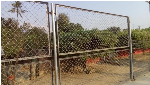
Figura 41. Mallas de cerramiento
