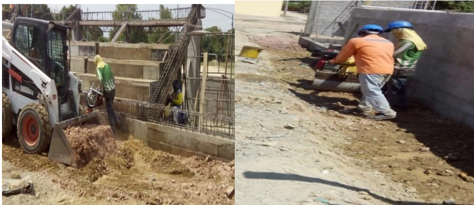
Figura 4. Lleno y compactación
