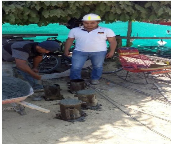
Figura 45. Cilindro de concreto
