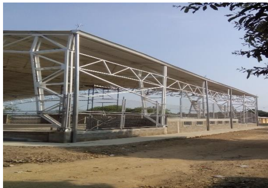
Figura 42. Acabados de malla y cubierta
