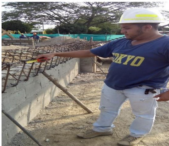
Figura 43. Espaciamiento de flejes
