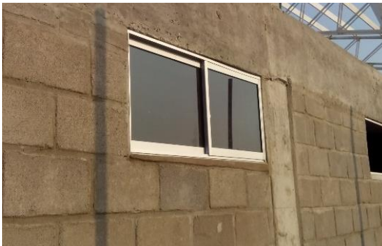
Figura 28. Instalación de ventanas
