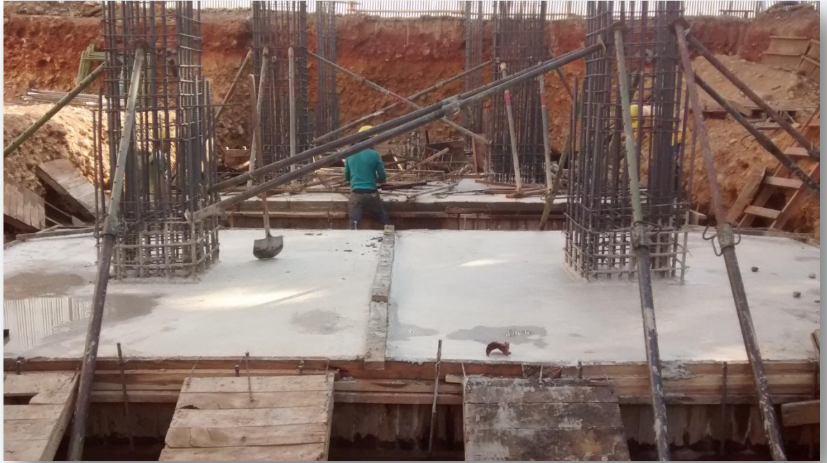
Ilustración 39 Zapatas mixtas fundidas, proceso de fraguado.
