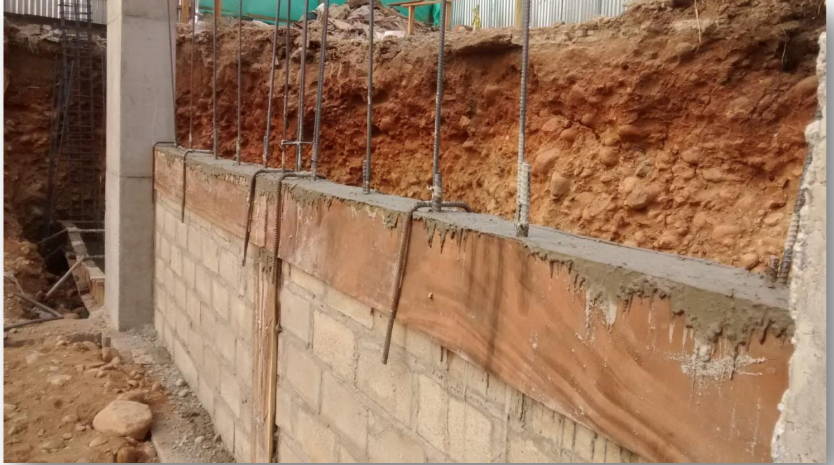
Ilustración 55 Viguetas de muro de contención fundida.
