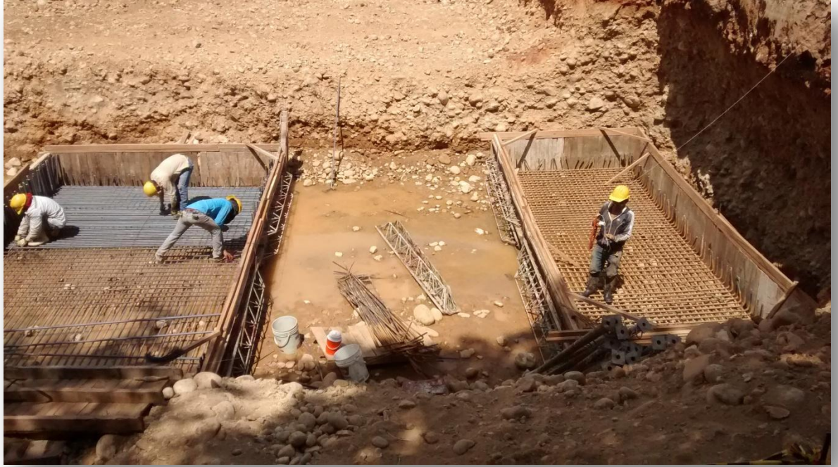
Ilustración 34 Armado de Zapatas.
