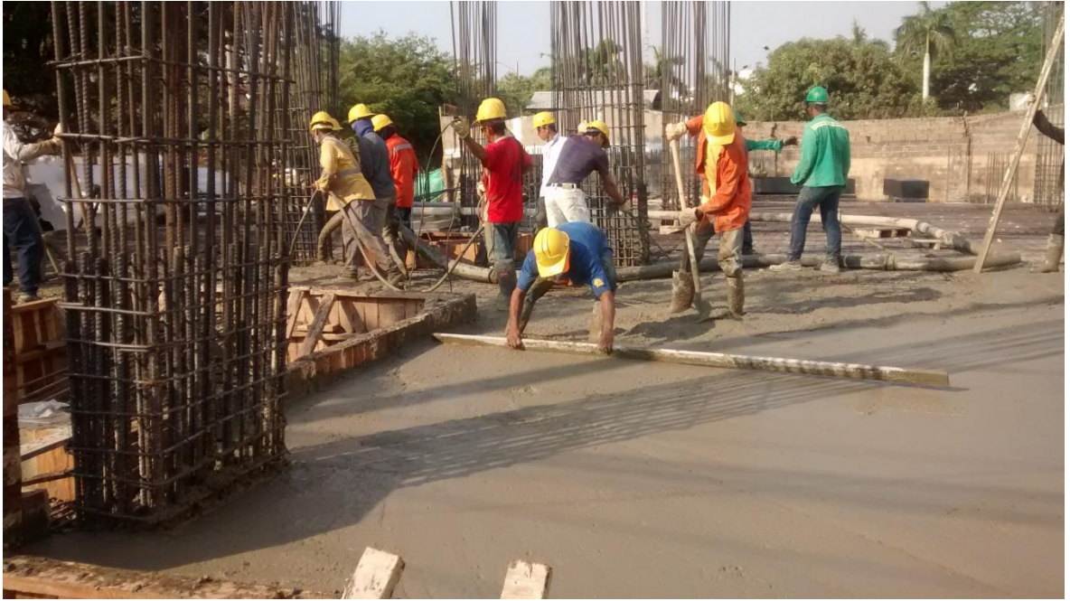
Ilustración 71 Fundiendo placa de entre piso.
