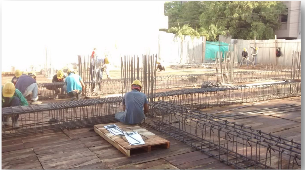
Ilustración 64 Instalación de casetones.
