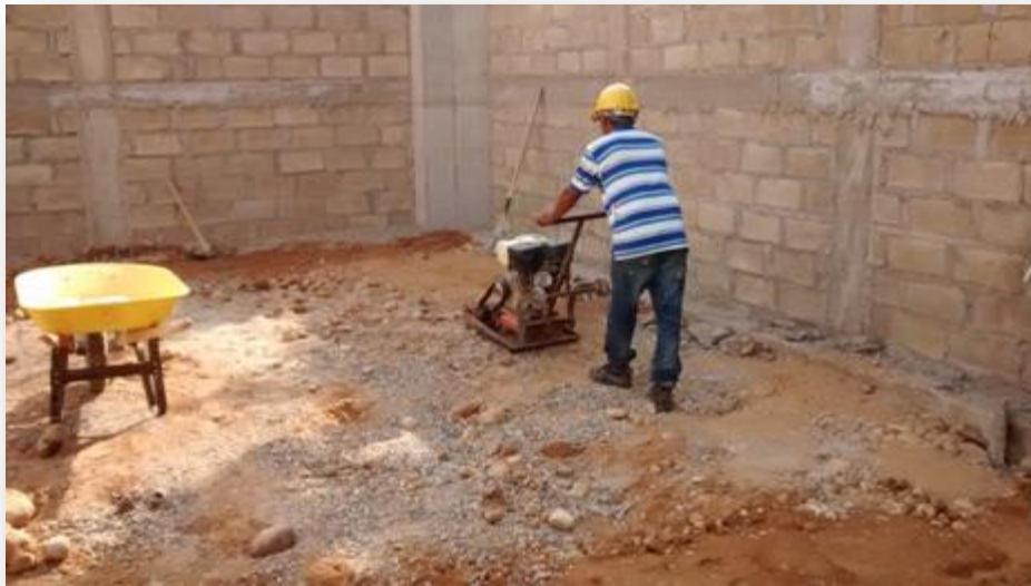
Ilustración 26 Compactación del terreno.
