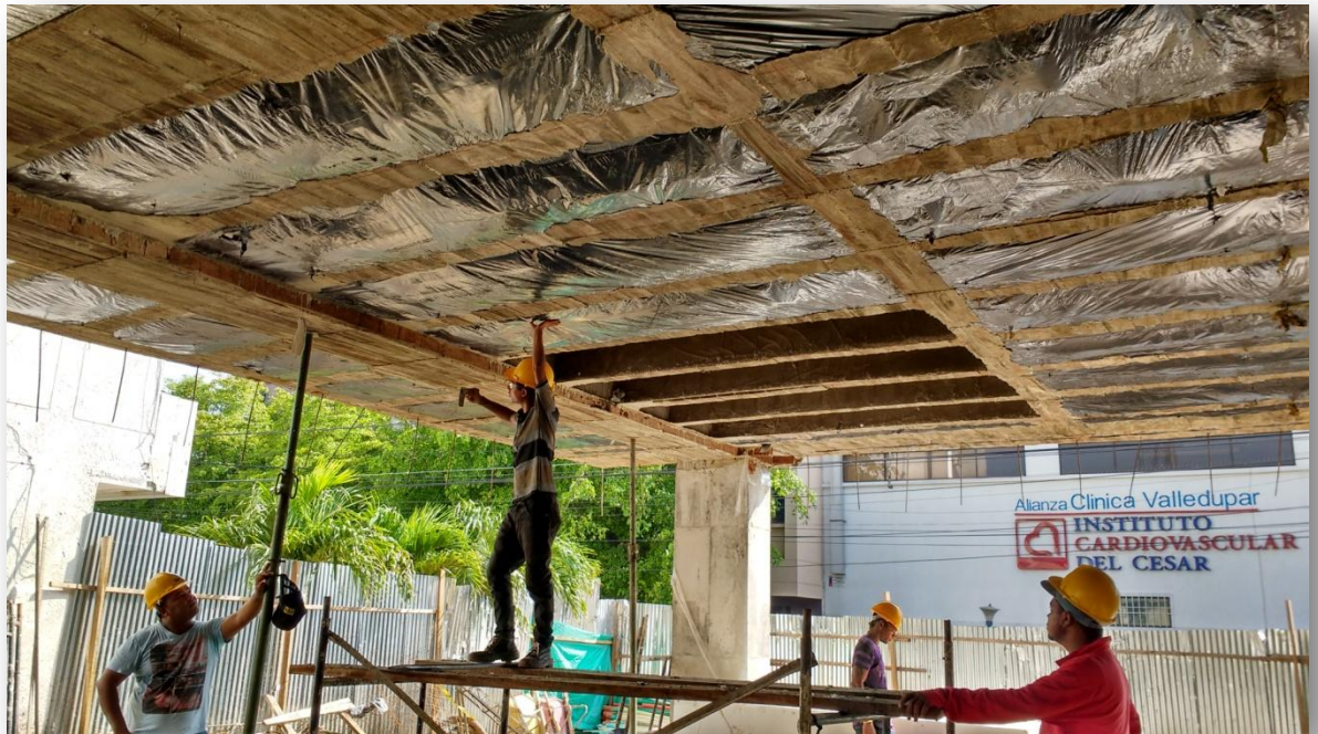
Ilustración 73 Retiro de casetones.
