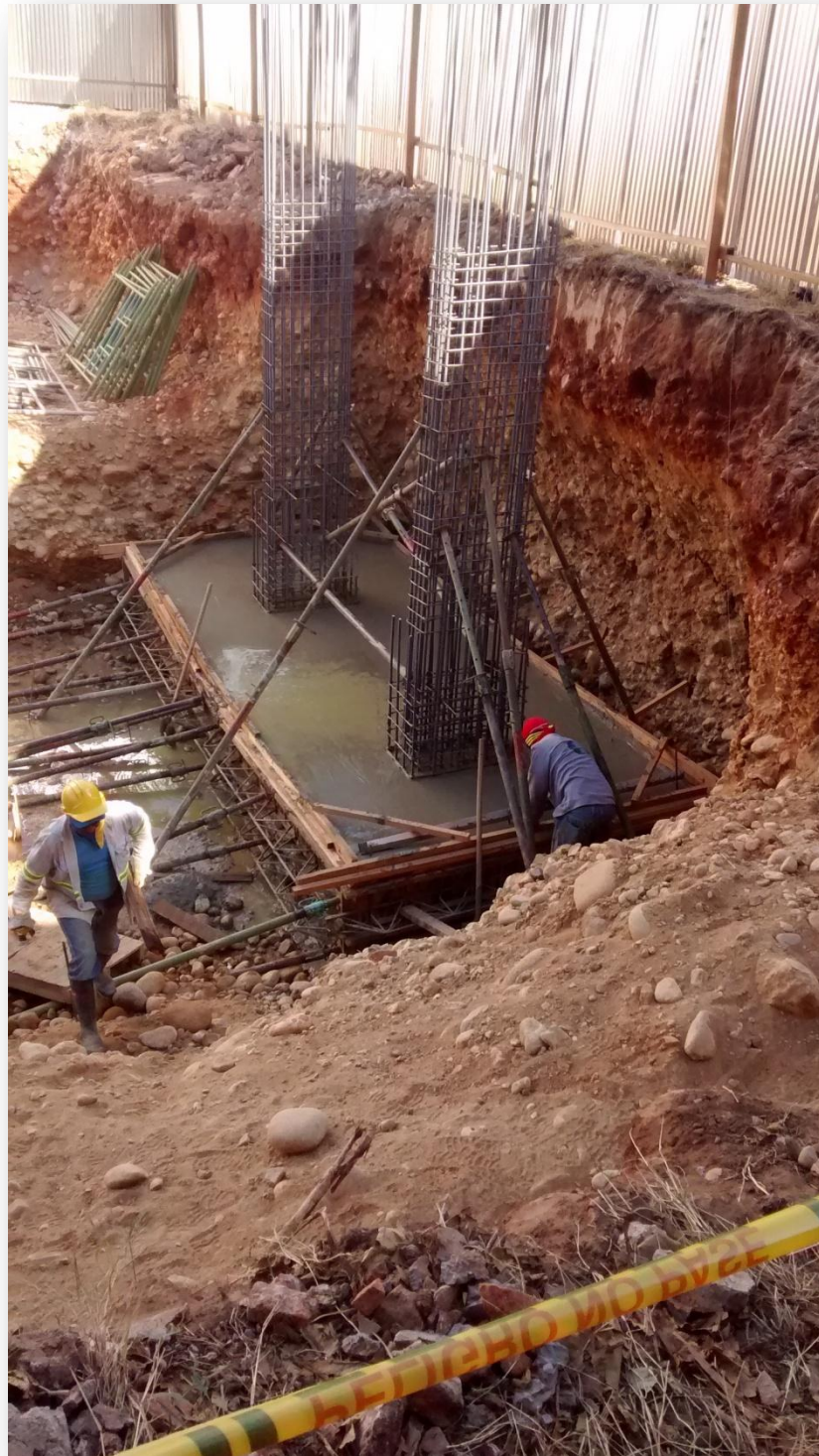
Ilustración 38 Zapatas mixtas fundidas, nivelando la superficie.
