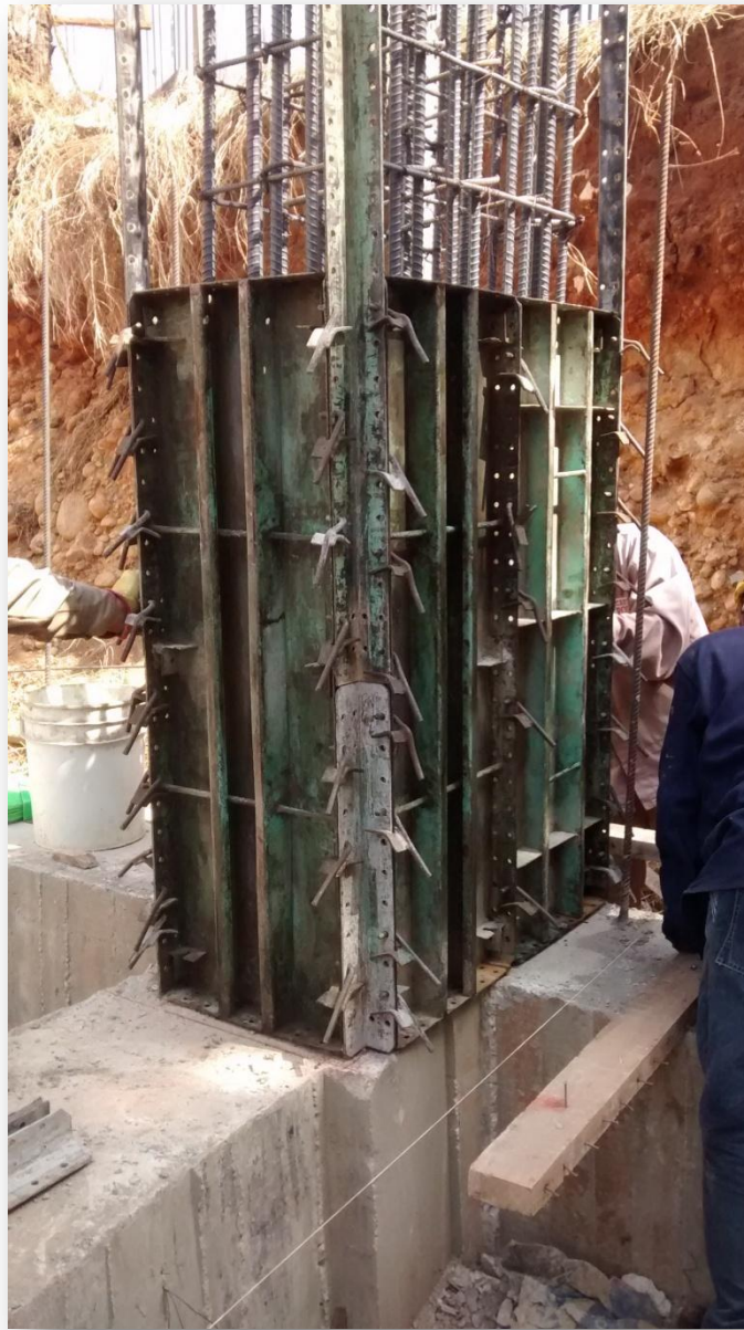
Ilustración 47 Encofrado de columna.
