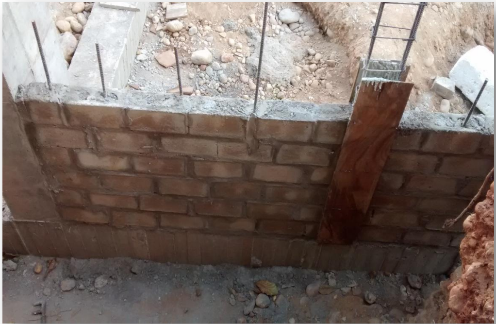
Ilustración 51 Muro de contención.
