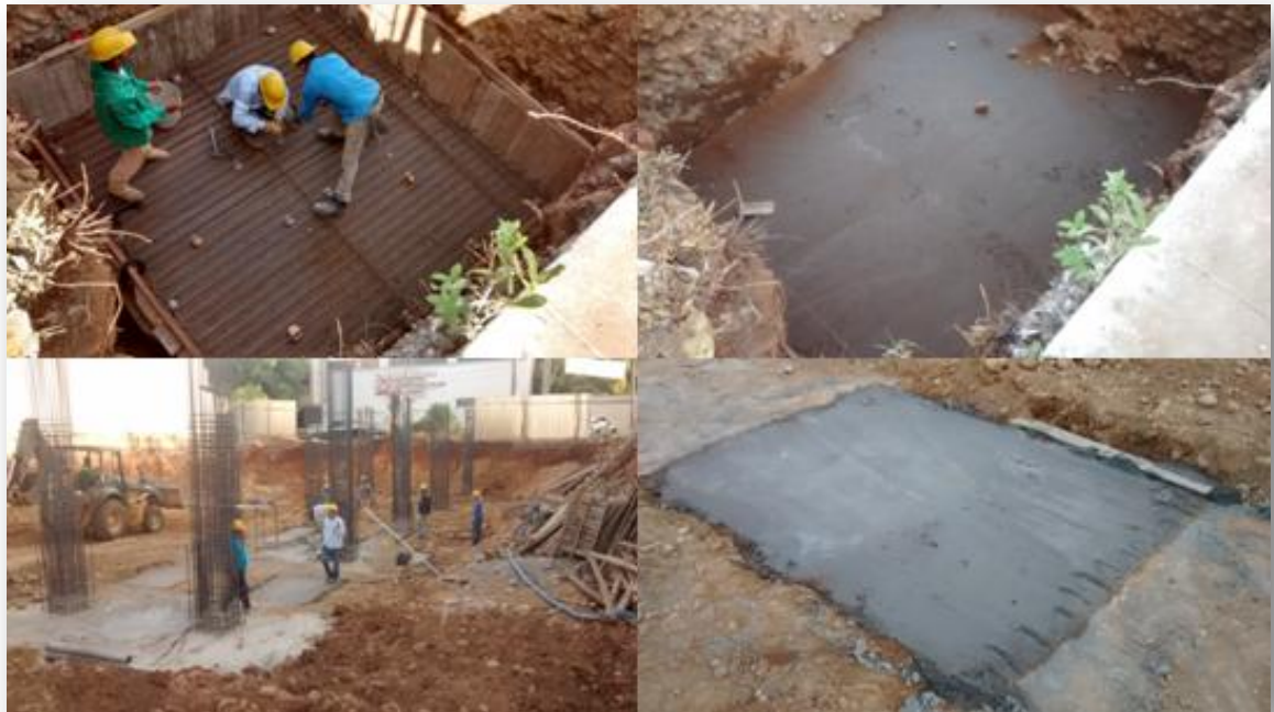
Ilustración 27 Solado para viga de cimentación y zapatas.
