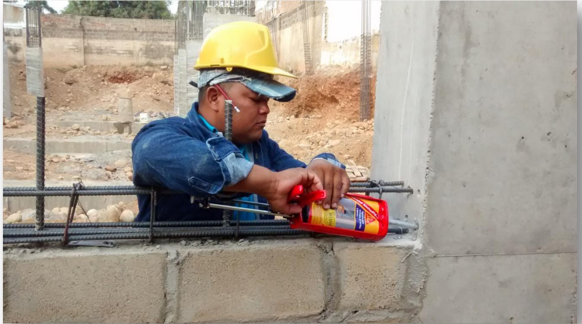
Ilustración 54 epóxico para anclajes vigueta de muro de contención.
