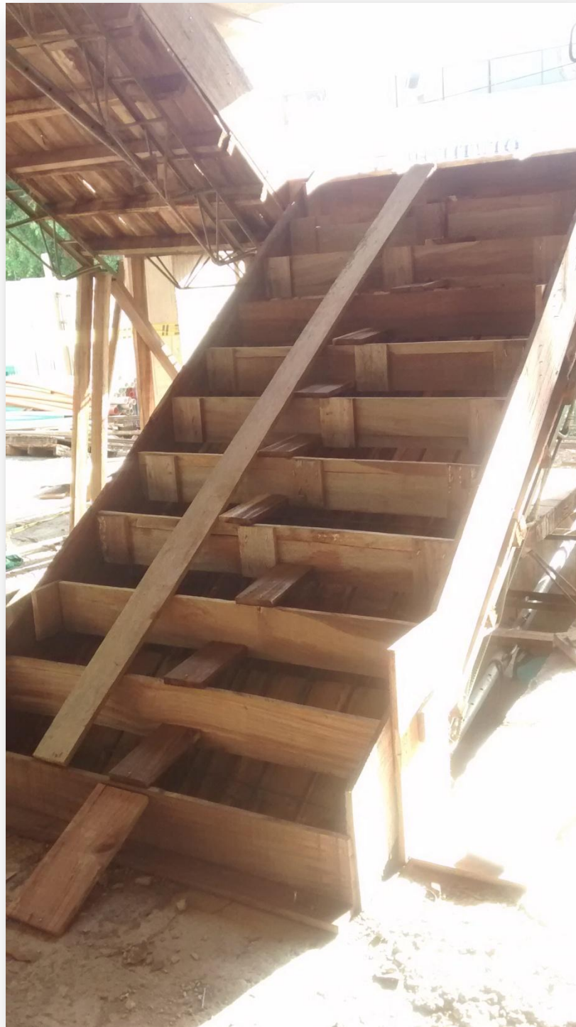
Ilustración 77 Escalera lista para fundir.
