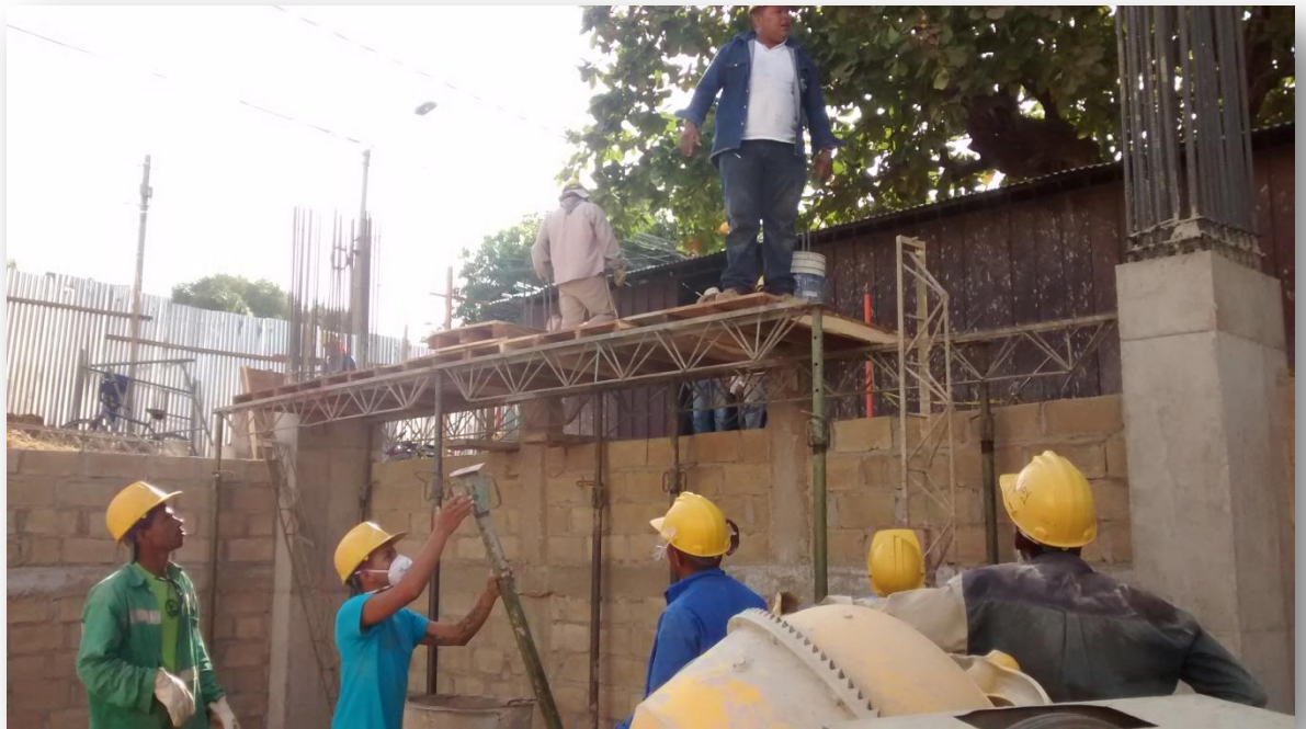
Ilustración 60 armado de plataforma para placa aligerada.
