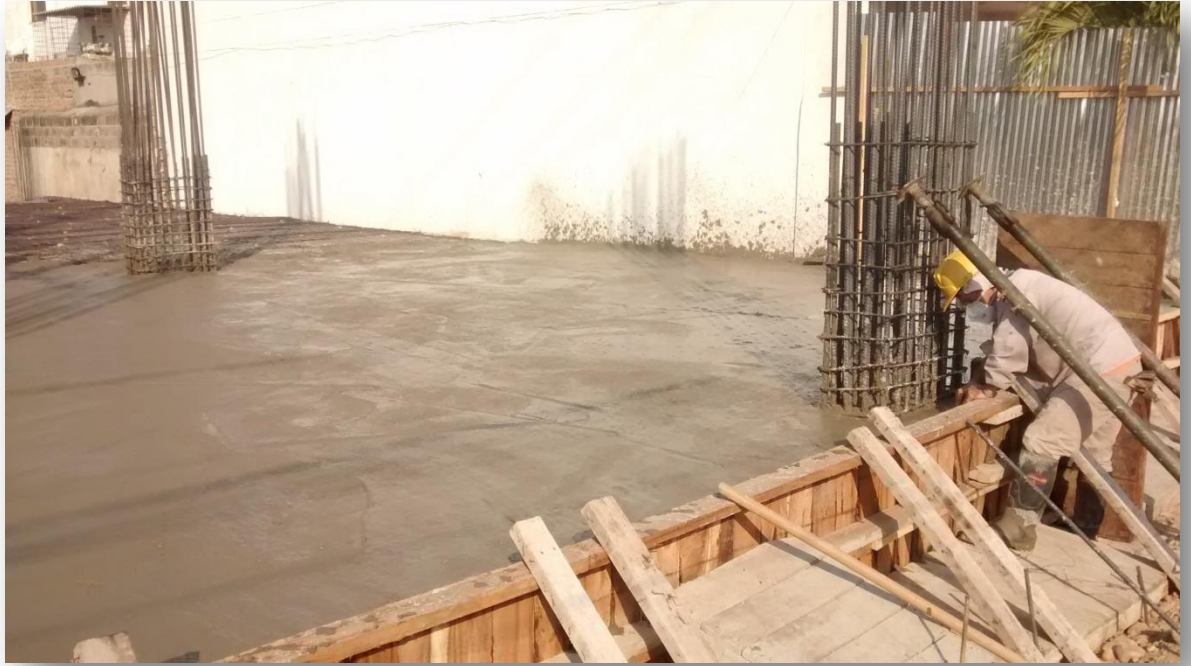
Ilustración 70 Placa de entre piso fundida.
