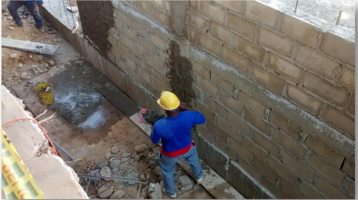
Ilustración 56 Pañete muro de contención.
