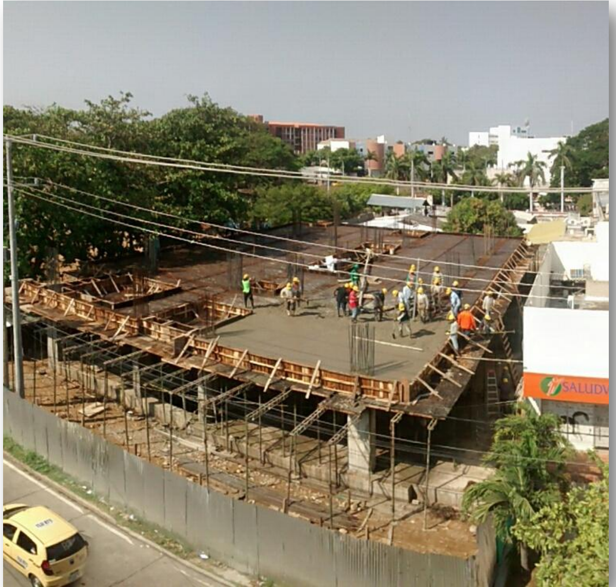
Ilustración 72 Fundiendo segunda placa de entre piso.
