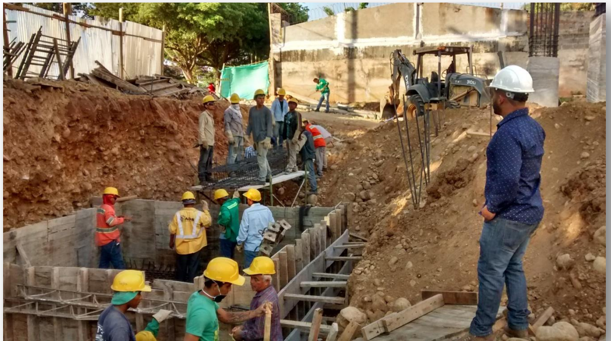
Ilustración 45 instalación de columnas.
