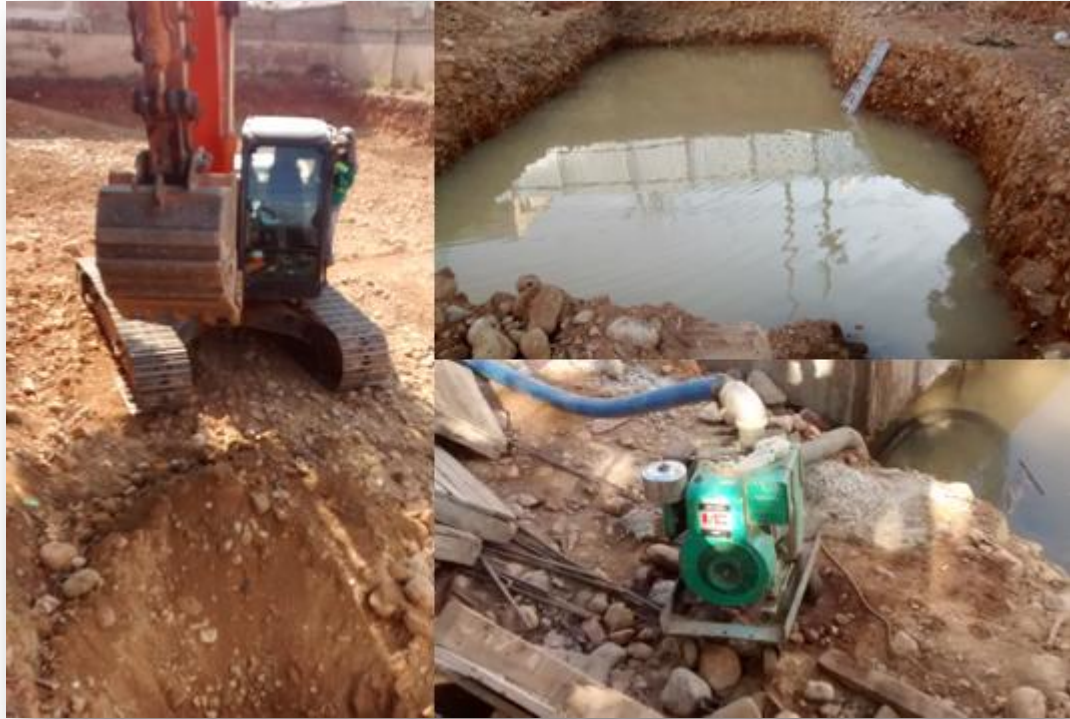
Ilustración 25 Excavación con retroexcavadora y evacuación de aguas a causa del nivel freático.
