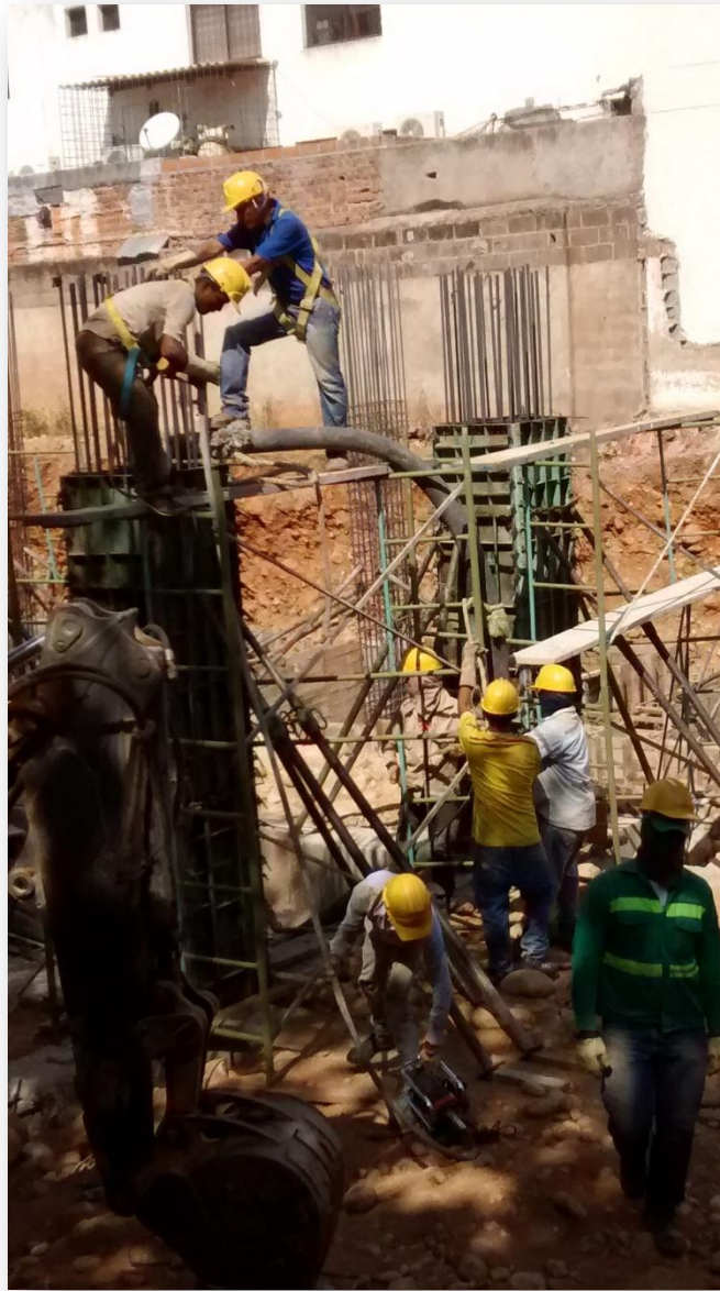
Ilustración 48 Fundiendo columnas.
