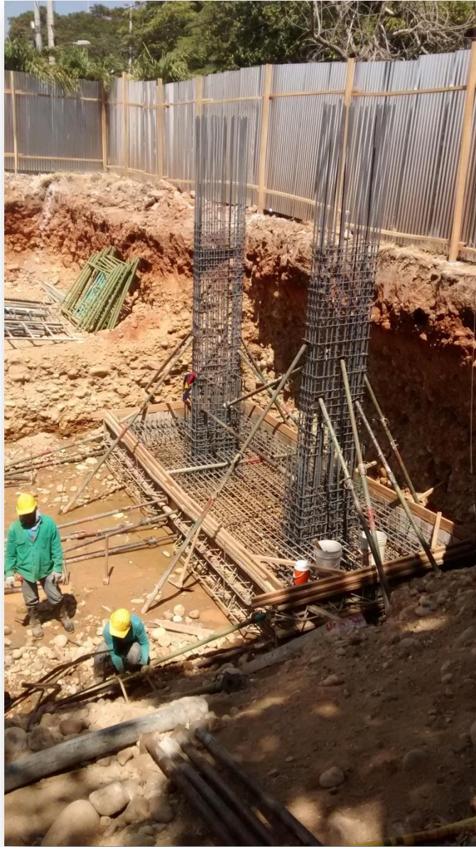
Ilustración 35 Zapatas mixtas, armadas y formaleteadas.
