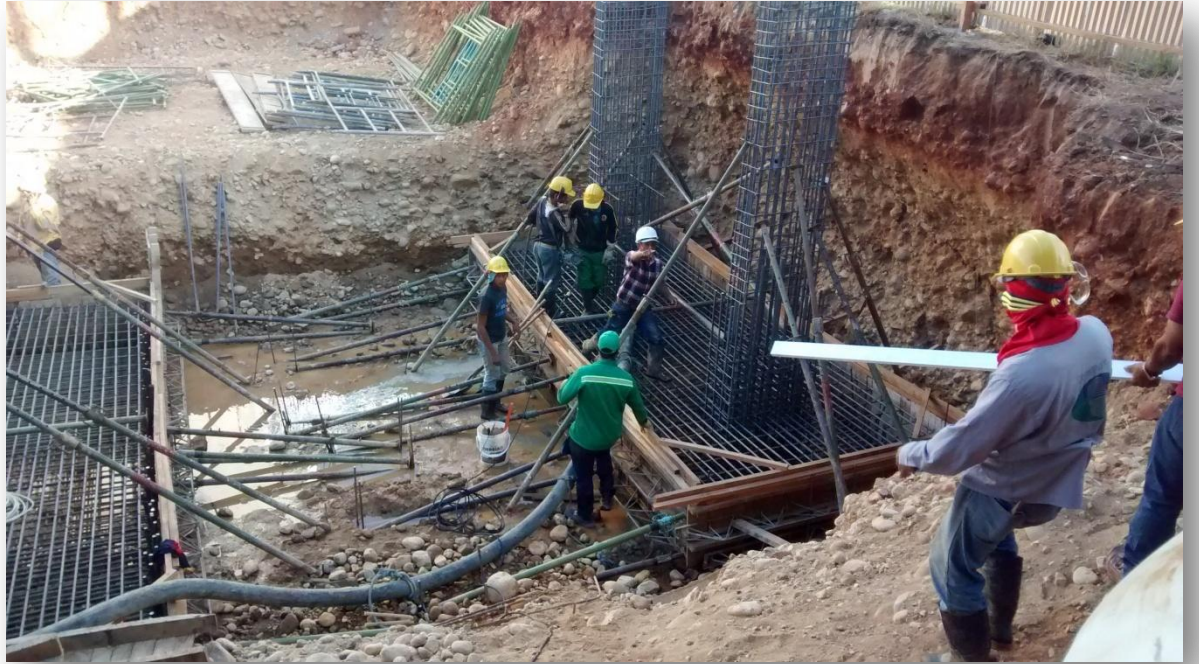
Ilustración 37 Zapatas mixtas a punto de fundirse
