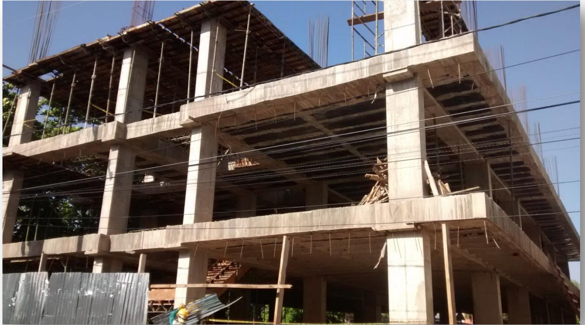
Ilustración 80 Vista lateral de la obra.
