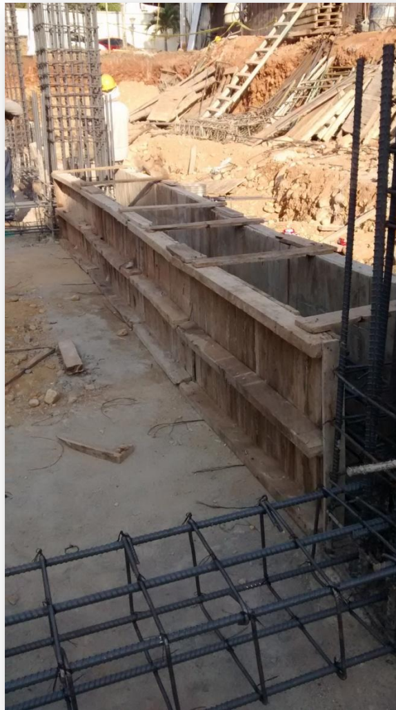
Ilustración 41 Viga de cimentación encofrada
