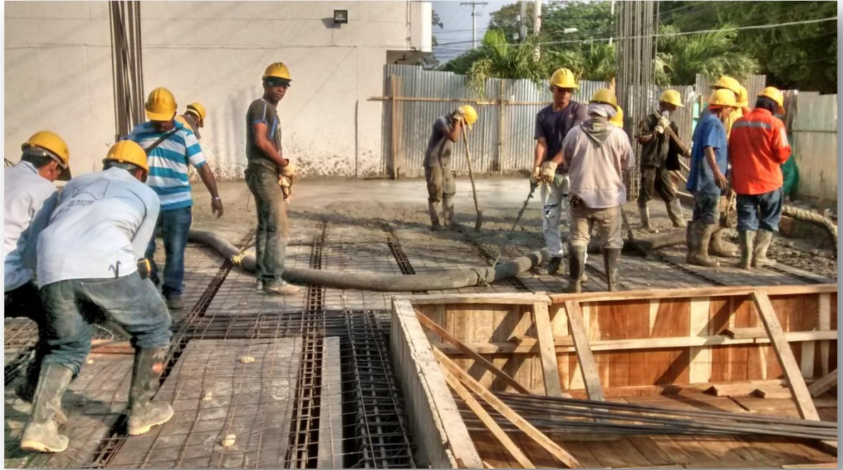
Ilustración 69 Fundiendo placa de entre piso.
