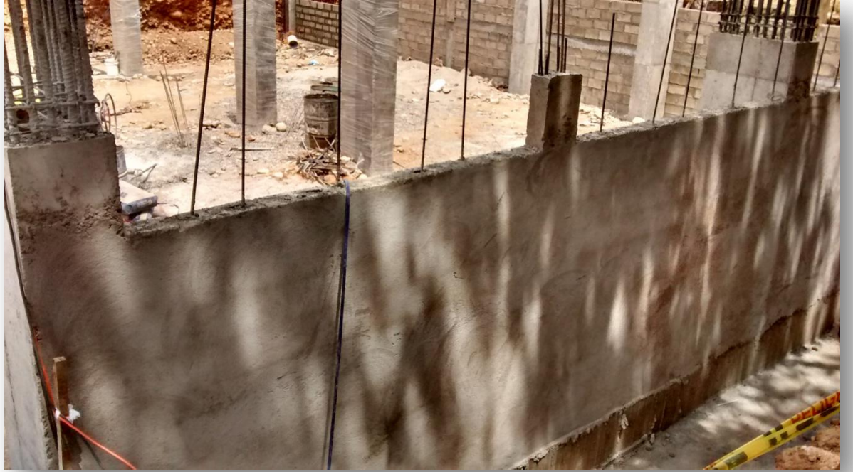
Ilustración 57 Muro de contención empañetado.
