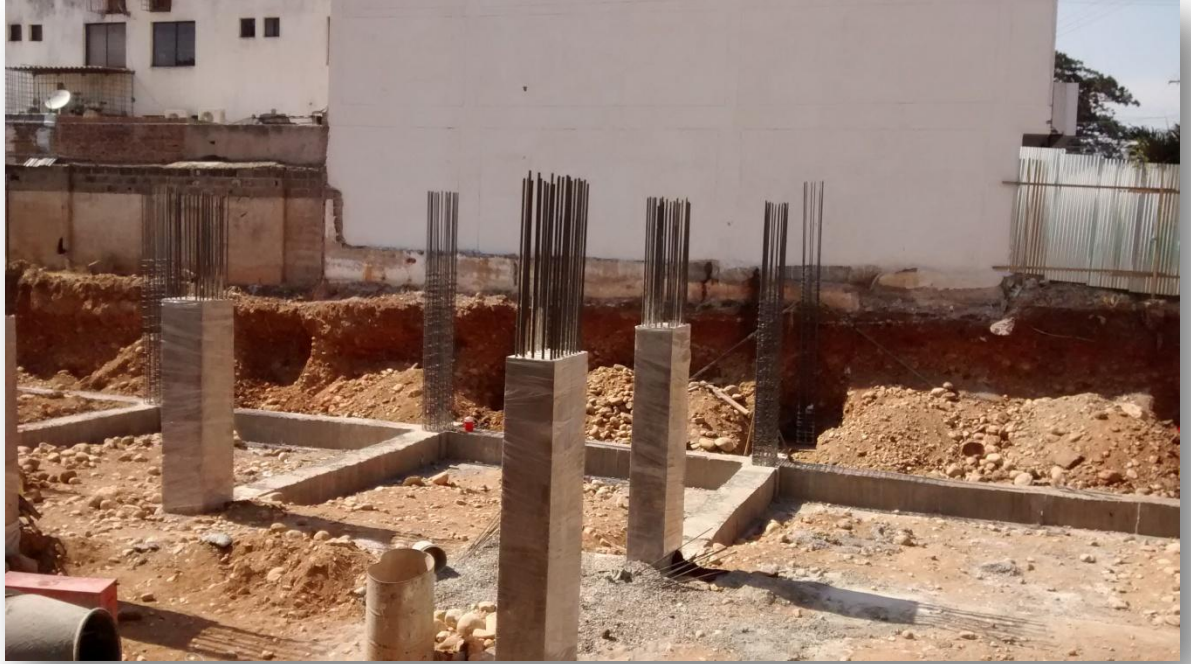
Ilustración 50 Columnas Fundidas.
