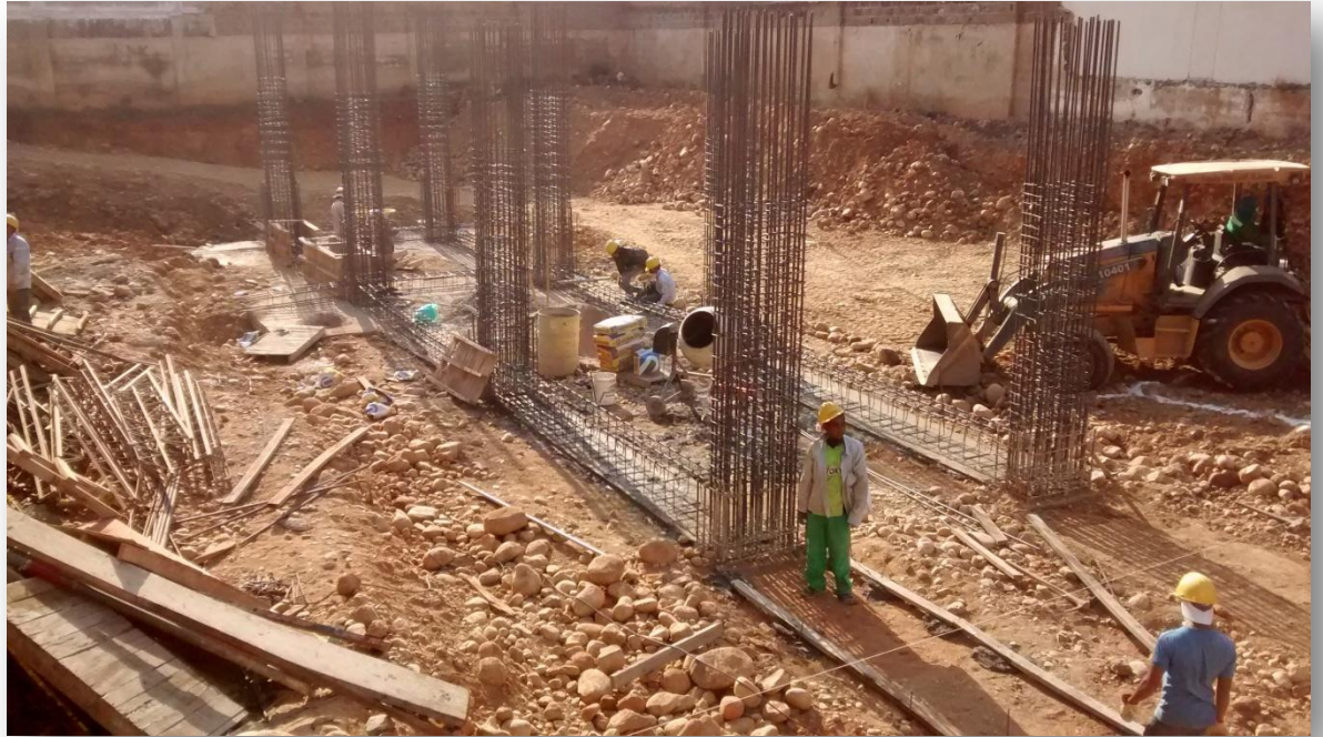
Ilustración 42 Vigas de cimentación
