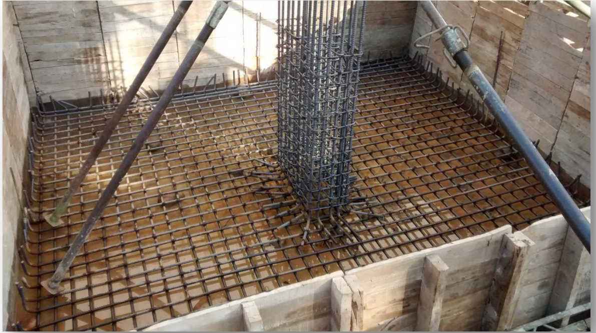
Ilustración 46 Instalación de columna.
