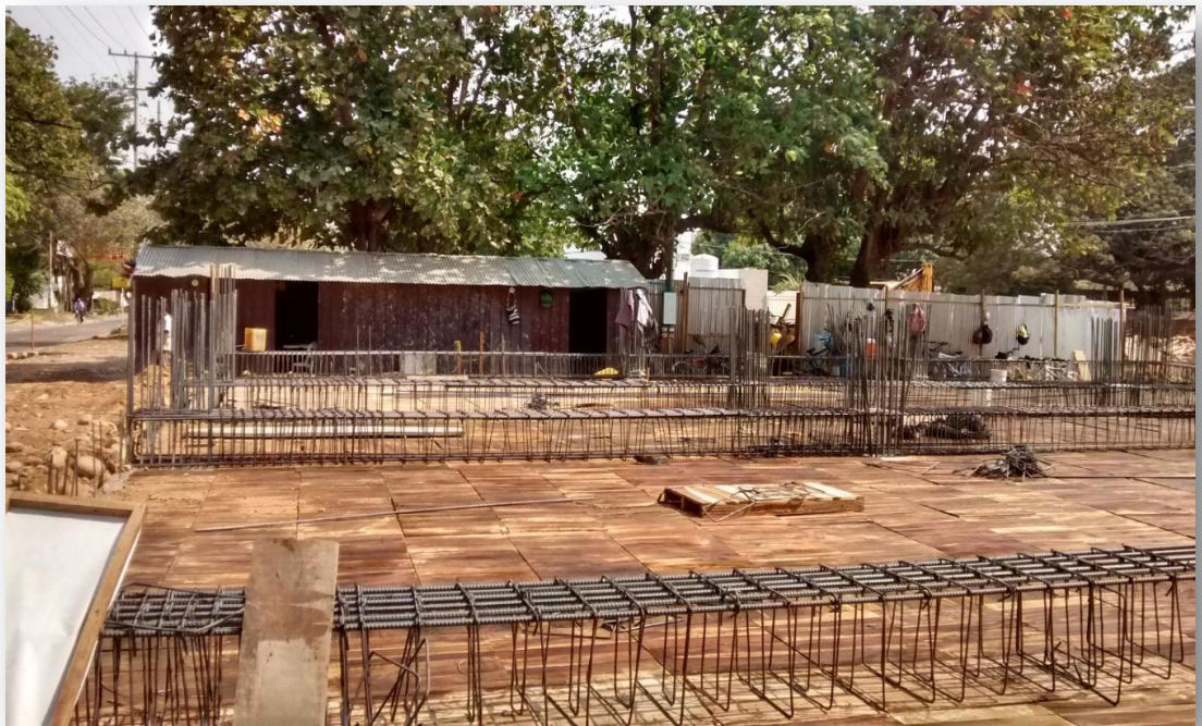
Ilustración 63 Armandando vigas de carga para la placa #1.
