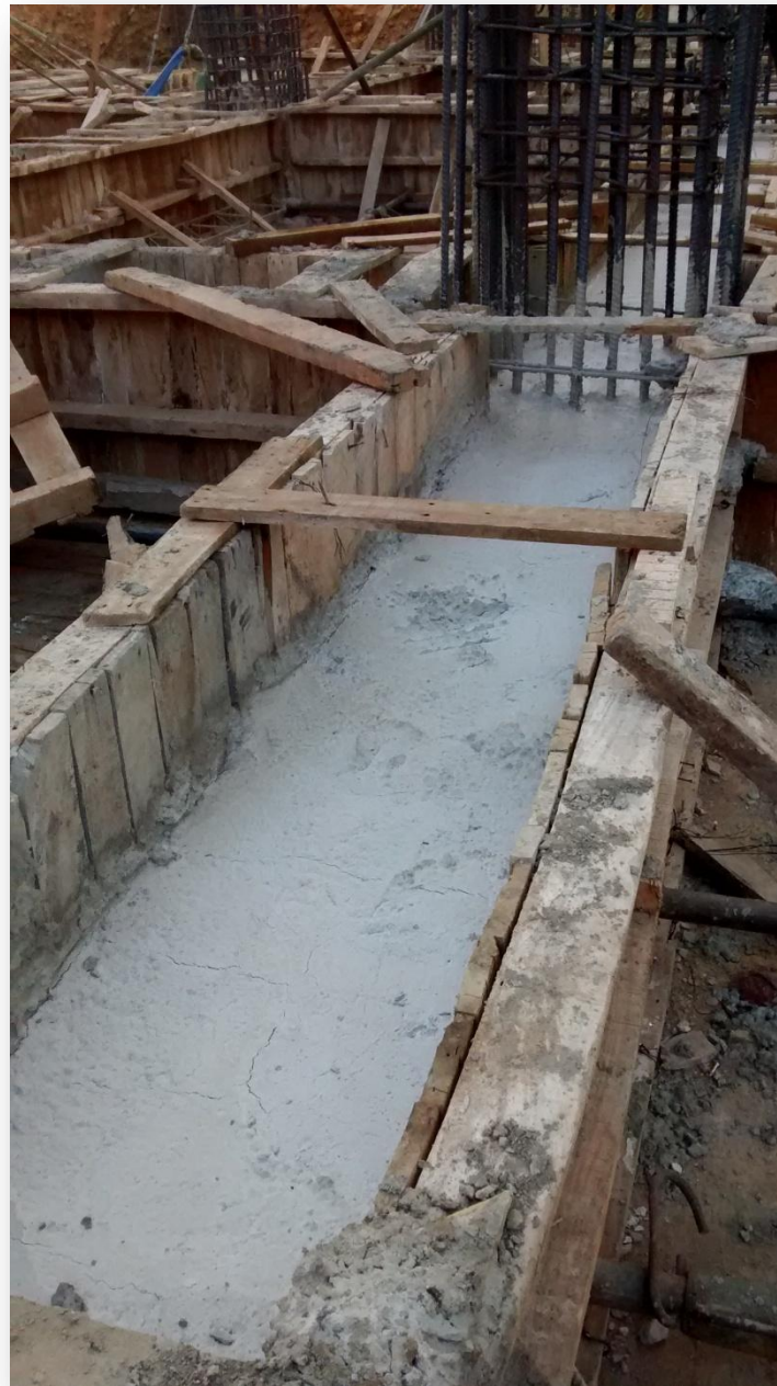
Ilustración 43 Viga de cimentación fundida.
