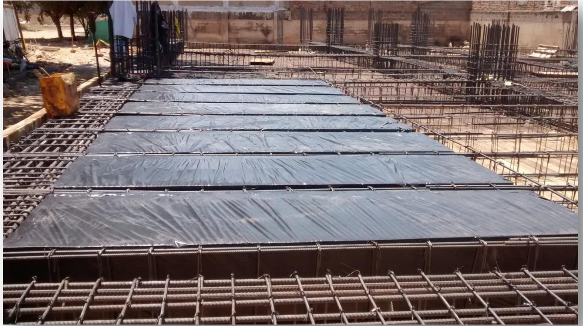
Ilustración 67 Instalación de casetones.
