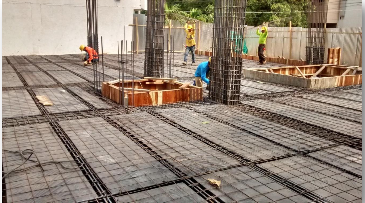
Ilustración 68 Instalación de malla electro soldada.
