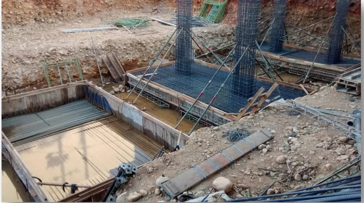
Ilustración 36 Zapatas mixtas, armadas y formaleteadas.
