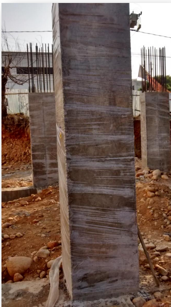
Ilustración 49 Columna forrada en plástico para retener la humedad.
