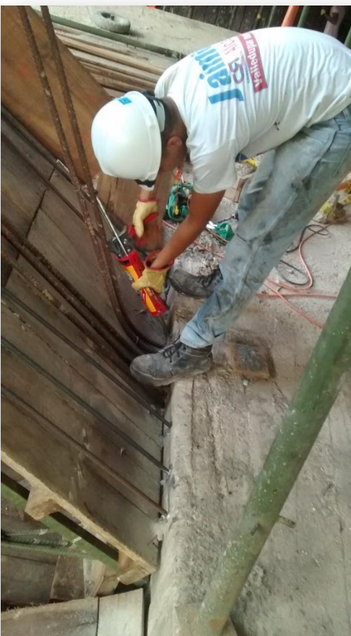
Ilustración 75 Epóxico, anclaje para escaleras.
