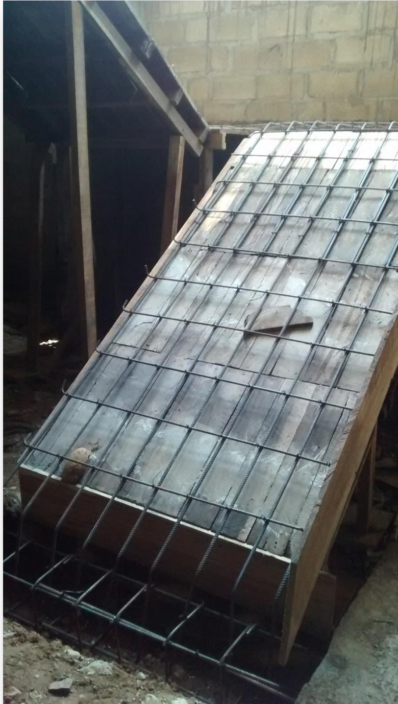
Ilustración 76 Armadura escaleras.
